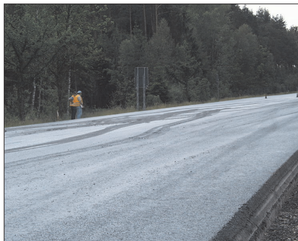
Bild 4: Aufgewickelte Abdichtung aus Bitumenemulsion
