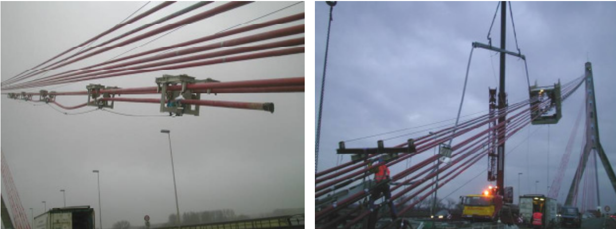
Bild 10: Austausch mehrerer Tragseile an der Rheinbrücke Düsseldorf-Flehe
