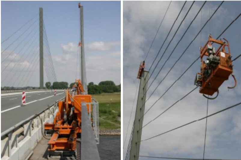
Bild 7: Seilprüfung mit dem Brückenseilbesichtigungsgerät
