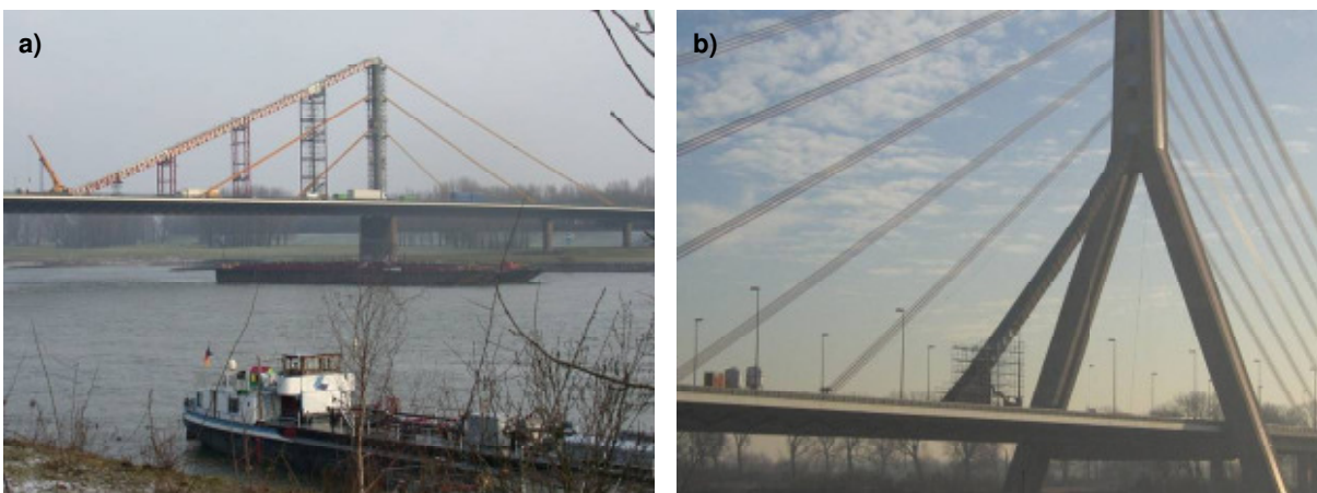
Bild 11: Gerüstkonstruktionen für die Korrosionsschutzerneuerung an den Seilen a) Rheinbrücke Duisburg Neuenkamp b) Rheinbrücke Düsseldorf Flehe
