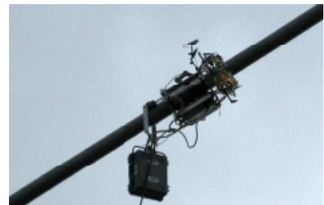
Bild 8: Visuelle Seilprüfung mit Seilbefahrergerät
