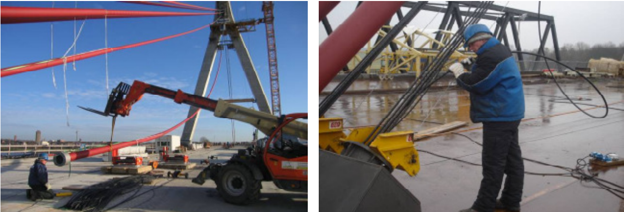
Bild 5: Montage der Litzenbündelseile für die Niederrheinbrücke Wesel
