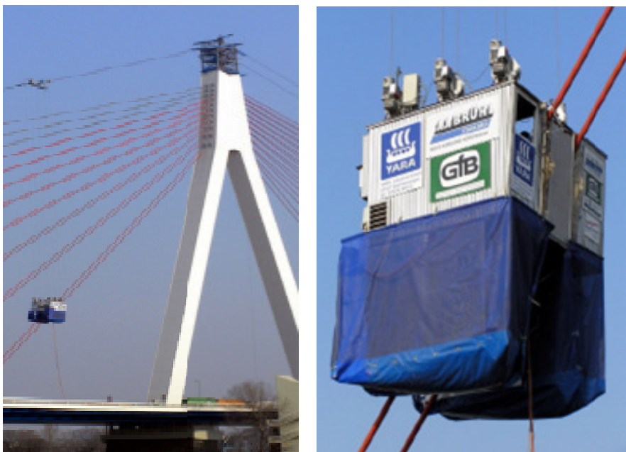
Bild 12: Seilbahn zur Korrosionsschutzerneuerung an den Seilen Rheinbrücke Neuwied [19]
