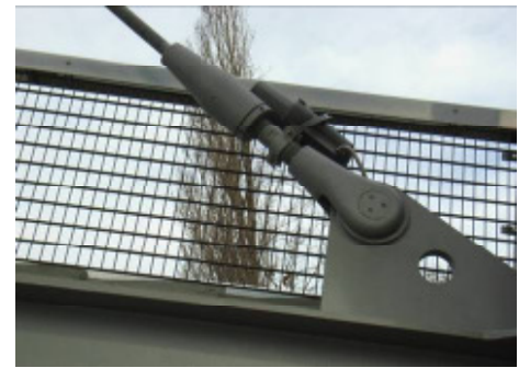
Bild 2: Seilverankerung und Spannelement der Fußgängerbrücke Kehl-Straßburg
