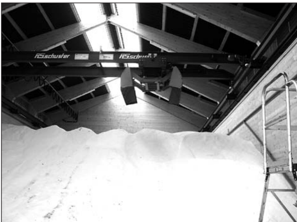
Bild 55: Brückenkran der Straßenmeisterei Lüdenscheld
