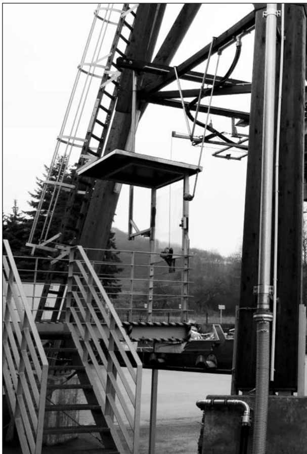
Bild 94: Ladepodest der Straßenmeisterei Halle
