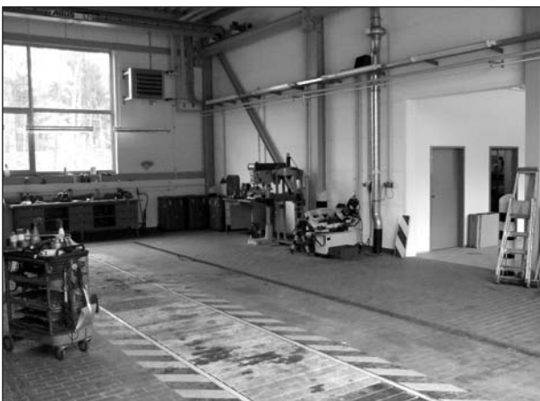
Bild 84: Gekennzeichnete Grube mit Rollabdeckung in der Straßenmeisterei Celle
