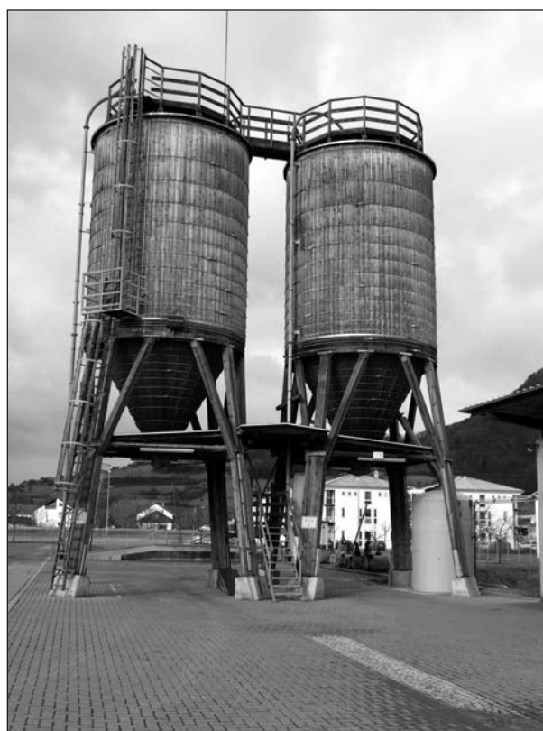
Bild 61: Silos der Straßenmeisterei Engen-Welschingen
