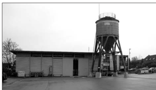
Bild 69: Salzhalle und zugehöriges Silo der Straßenmeisterei Halle
