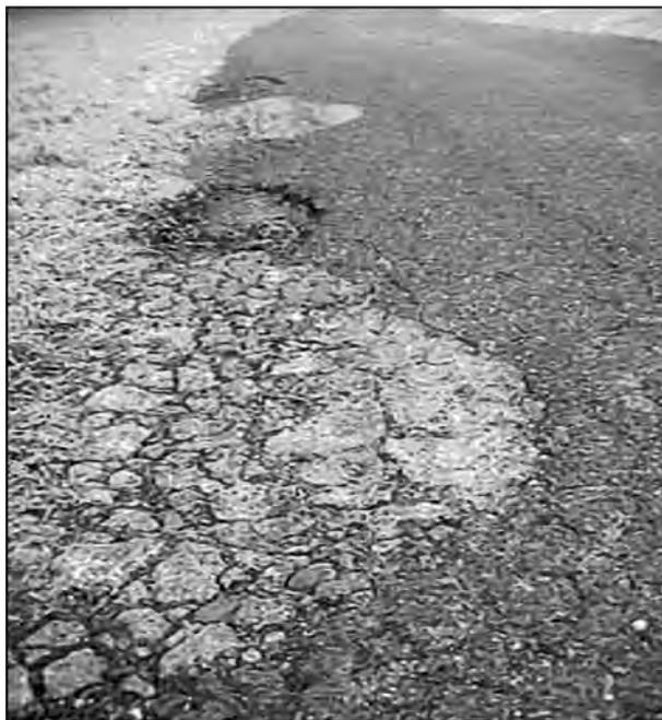
**Bild 1:** Mittels der visuellen Begutachtung des Oberflächenbildes lassen sich Schäden frühzeitig dokumentieren und gegebenenfalls ausbessern
