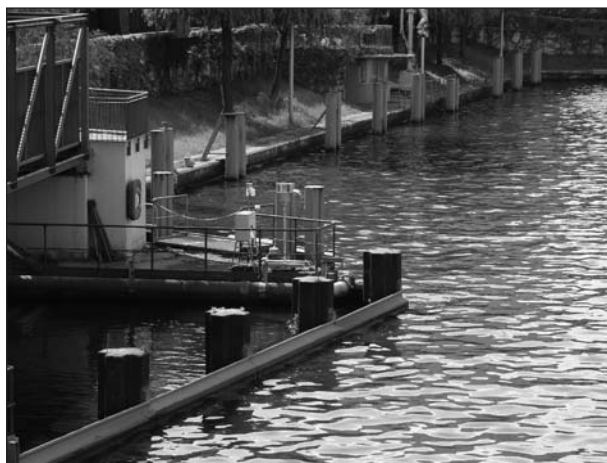
Bild 15: Foto von der Dauermessstation Michaelbrücke vom 12.05.2008
