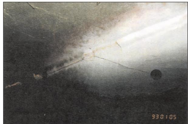
Bild 31: Rissverlauf im Längsrippensteg mit Abbohrung
