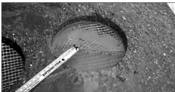
**Bild 135:** Kein Verbund zwischen Schutz- und Deckschicht sowie zwischen Asphalt und Gitter
