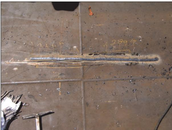
Bild 34: Instandsetzung Deckblechriss
