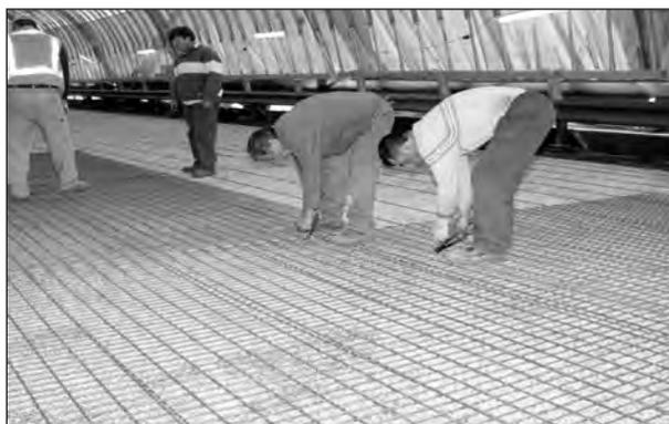
**Bild 104:** Einbau der Bewehrung
