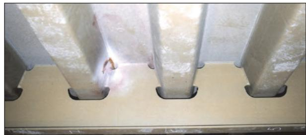
Bild 46: Einbau eines Zwischenquerträgers mit Nachfolgeschäden
