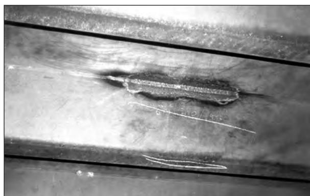
Bild 19: Schäden der Kategorie 1: Risse in der Verbindungsnaht zwischen Deckblech und Längsrippe – Trapezprofil, instand gesetzte Naht zur späteren Prüfung noch ohne Beschichtung
