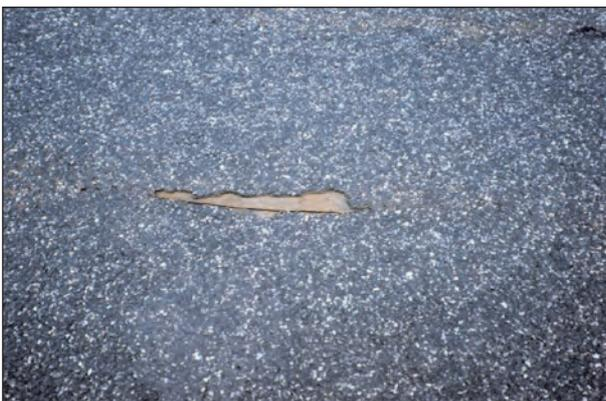
**Bild 63:** Deckblechriss bei einer Brücke mit Dünnbelag
