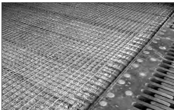
**Bild 105:** Bewehrung (Bereich Fahrbahnübergang)
