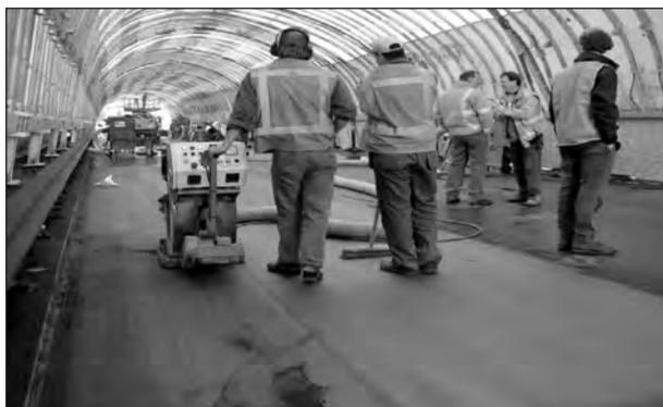
**Bild 102:** Oberflächenvorbereitung des Stahldeckblechs mit Strahlverfahren SA 2,5
