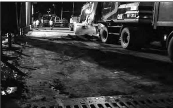
**Bild 95:** Entfernen des Asphaltbelags
