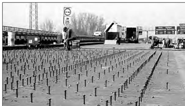
Bild 108: Aufschweißen von Kopfbolzendübel
