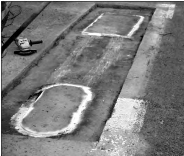
**Bild 37:** Ausführung einer Notfallreparatur
