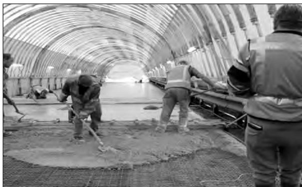
**Bild 106:** Einbringen von hochfestem Beton B 105
