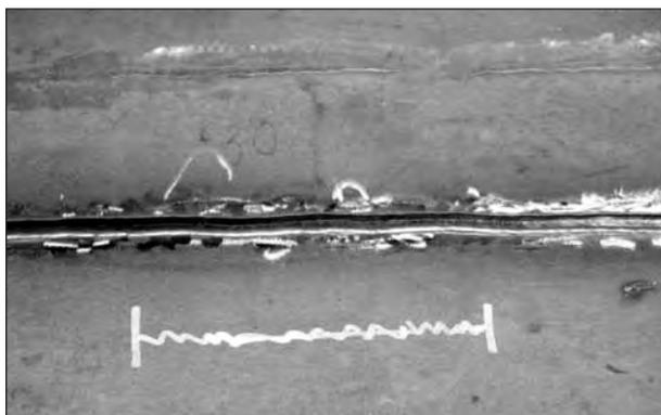
**Bild 100:** Instand gesetztes Deckblech
