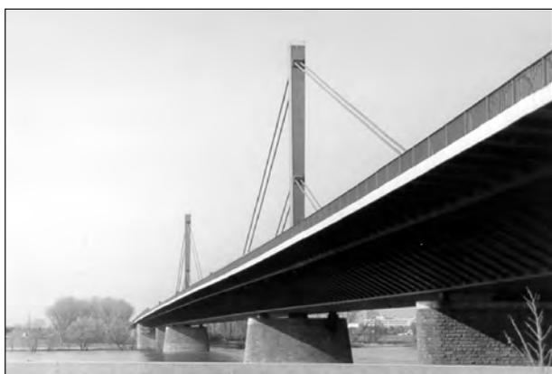
**Bild 15:** Schrägseilbrücke mit Sektkelchprofilen
