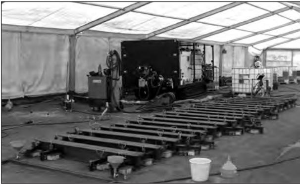
**Bild 87:** Geräte für das Injizieren und Niederhalter unter Zelt
