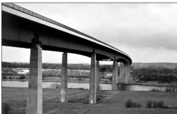
**Bild 14:** Balkenbrücke mit Trapezprofilen
