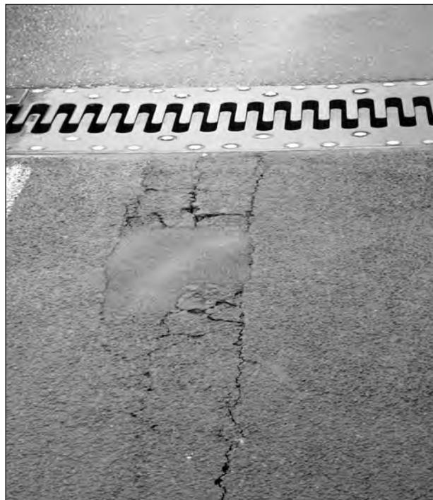
**Bild 64:** Deckblechriss bei einer Brücke mit Asphaltbelag
