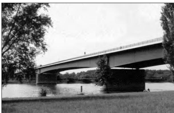
**Bild 16:** Balkenbrücke mit eingepassten V-Steifen
