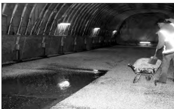
**Bild 103:** Aufbringung der Epoxy-Abdichtung und Abstreuen der Oberfläche
