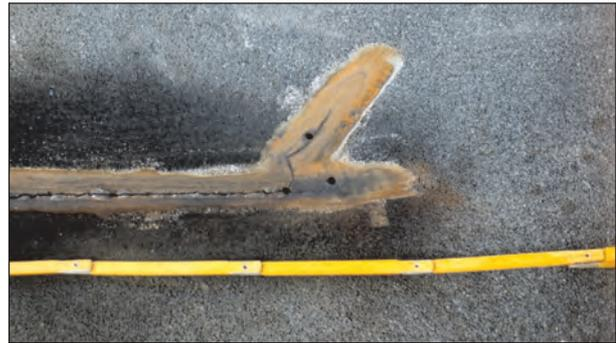
Bild 45: Abbohren eines Risses mit Nachfolgerissen
