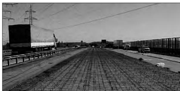
Bild 109: Verbundsicherung und Bewehrung für Aufbeton
