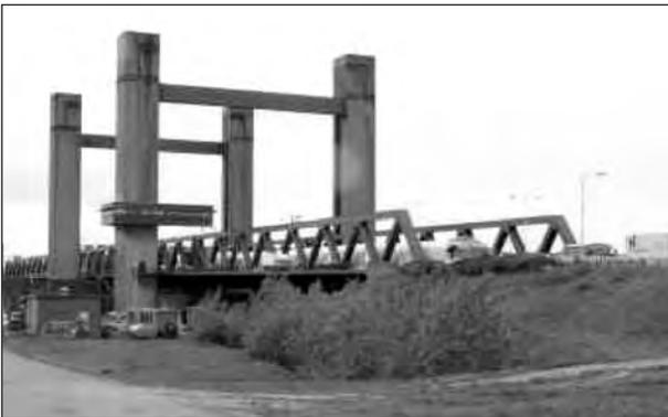
**Bild 94:** Caland Brücke, kombinierte Straßen- und Eisenbahnbrücke (Zwei feste Brücken mit 180/86 m Spannweite, Mitte Hubbrücke mit 69 m Spannweite)
