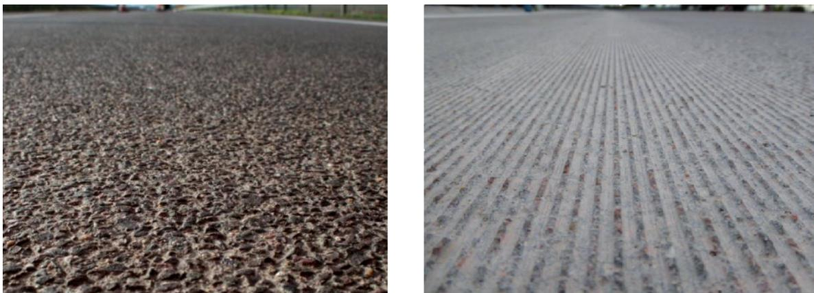
**Abbildung 2.28: Exemplarische Darstellung der Fahrbahnoberfläche einer Betondecke mit Waschbetontextur (links) und Grindingtextur Typ S (rechts) [54]**
