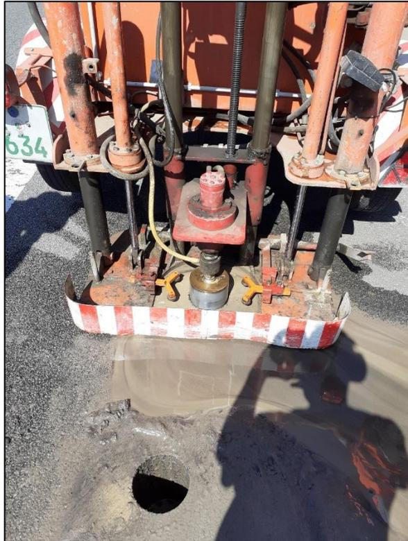
Bild 4-4: Versenkter Bohrkopf bei der Bohrkernentnahme auf der A30
