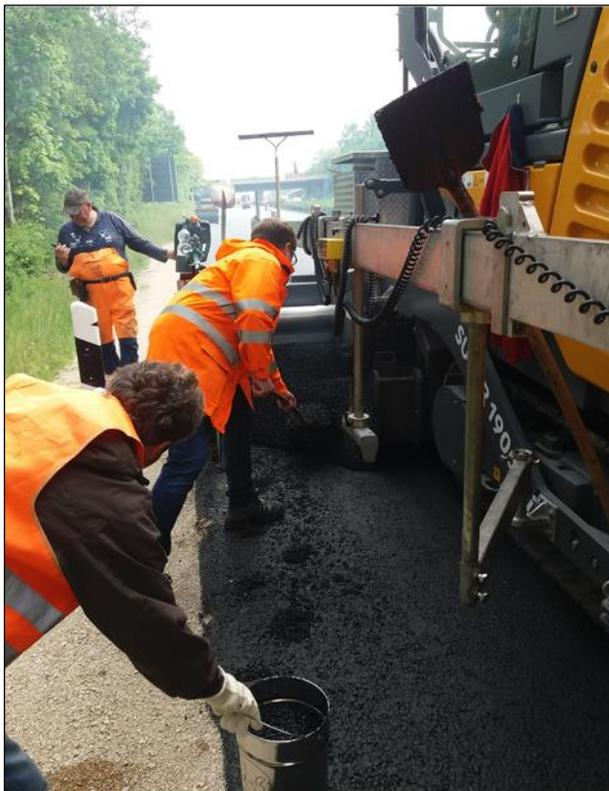
Bild 10: Probenahme des Mischgutes an der Verteilerschnecke
