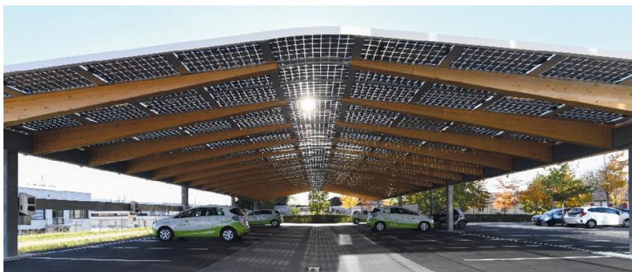
**Bild 12: Konzept A mit vollflächiger solarer Überdachung © ClickCon GmbH & Co. KG**
