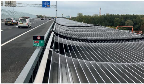
**Bild 2-2: Diffraktor WHIS®top der niederländischen Firma 4Silence aus (4SILENCE 2020)**
