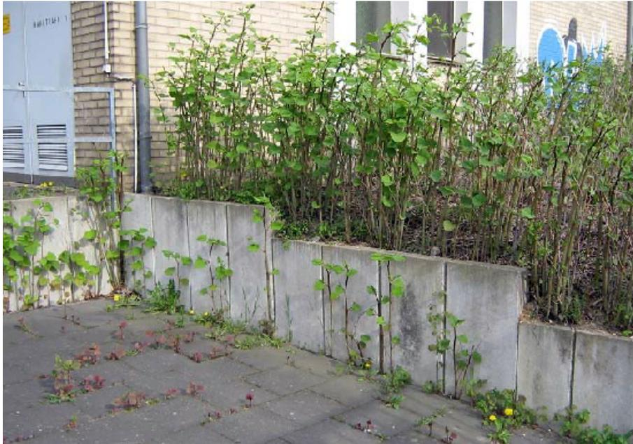
**Bild 4:** Staudenknöterich wächst zwischen Pflasterfugen am Rand einer Stützmauer. Steine können durch die Rhizome gelockert werden, der Pflegeaufwand zum Freihalten der Fläche wird erhöht (Foto: B. Alberternst, Rhöndorf 25.4.2010)
