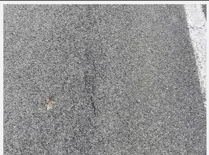
**Bewertung: Unterschiedlicher Zustand innerhalb der Strecke. Teils sehr gut, teils die beschriebenen Merkmale (Einzelrisse sowie Netzrisse und Flickstellen).**
