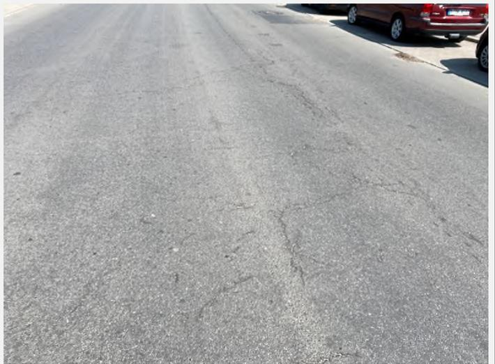
**Bewertung: Teile sind in einem sehr guten Zustand, andere Teile weisen erhebliche Schädigungen auf. Möglicherweise trägt der Unterbau zur Schadensbildung bei.**
