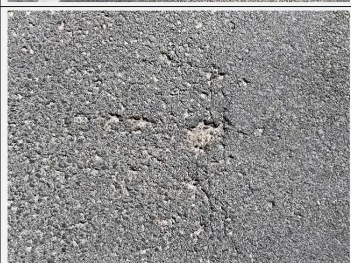
**Bewertung: Zustand teils nicht mehr gut. Verschiedene Schadensmerkmale gehen ineinander über. Referenzstrecke befindet sich in keinem besseren Zustand; allerdings ist der Anteil des sanierten Bereichs bei der Referenzstrecke geringer.**
