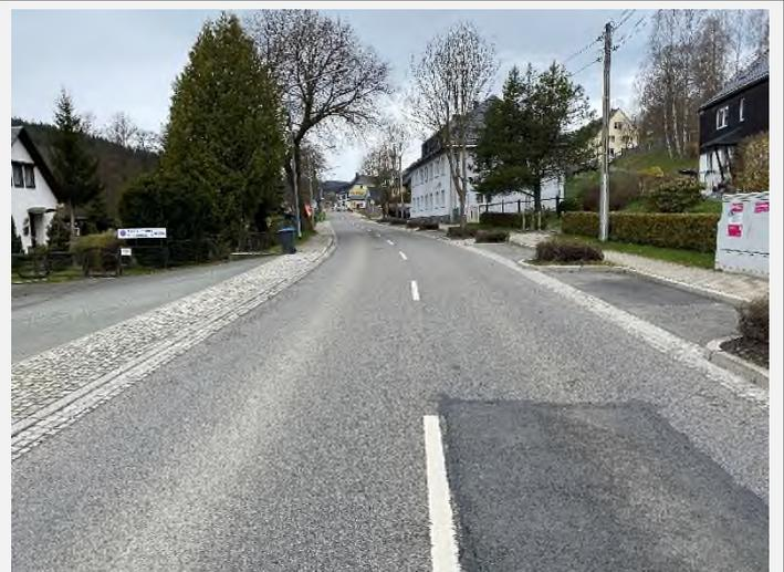
**Bewertung: Die teilweise deutlichen Schädigungen sind im Zusammenhang mit der Höhenlage und dem verformungsbeständigen Mischgut zu sehen.**
