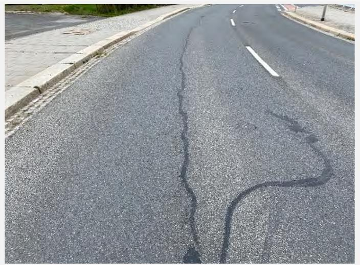
**Bewertung: Rissbildung ist im Zusammenhang mit Höhenlage, Liegedauer und dem verformungsbeständigen Mischgut zu sehen.**
