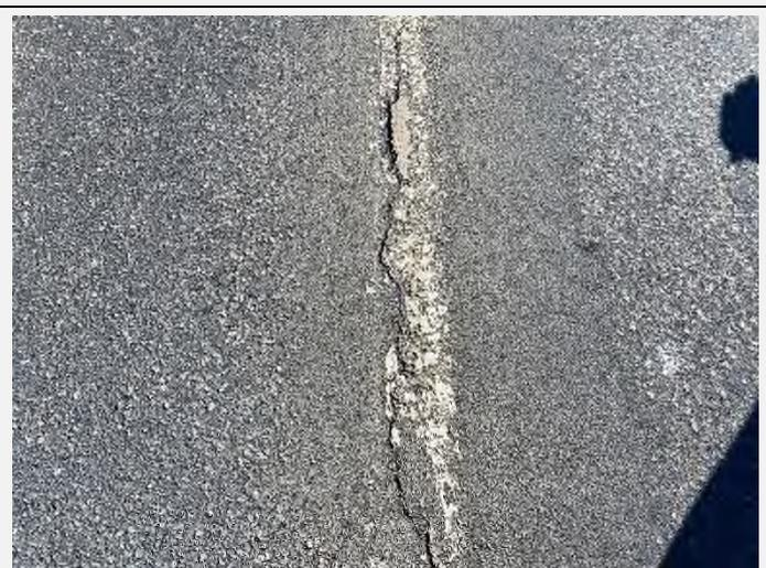
**Bewertung:** Schädigungen sind in Verbindung mit der Liegedauer zu betrachten. Abgesehen von den Rissen, deren Ursache evtl. der Unterbau ist, ist der Zustand nicht schlechter als der Zustand der Referenzstrecke. Aufgrund des hohen Anteils an sanierten Bereichen (ca. 40-50 %) gilt dies nur für die verbliebenen Teile.
