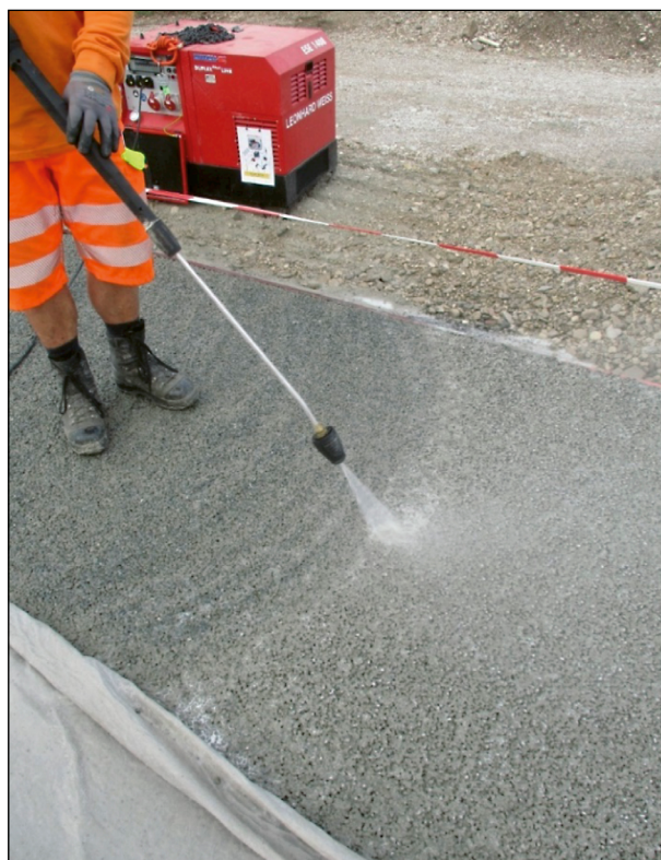
Bild 86: Auswaschen des oberflächlichen Zementleims
