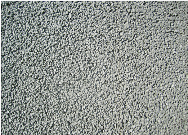
Bild 81: Oberfläche des OPB beim Probefeldeinbau
