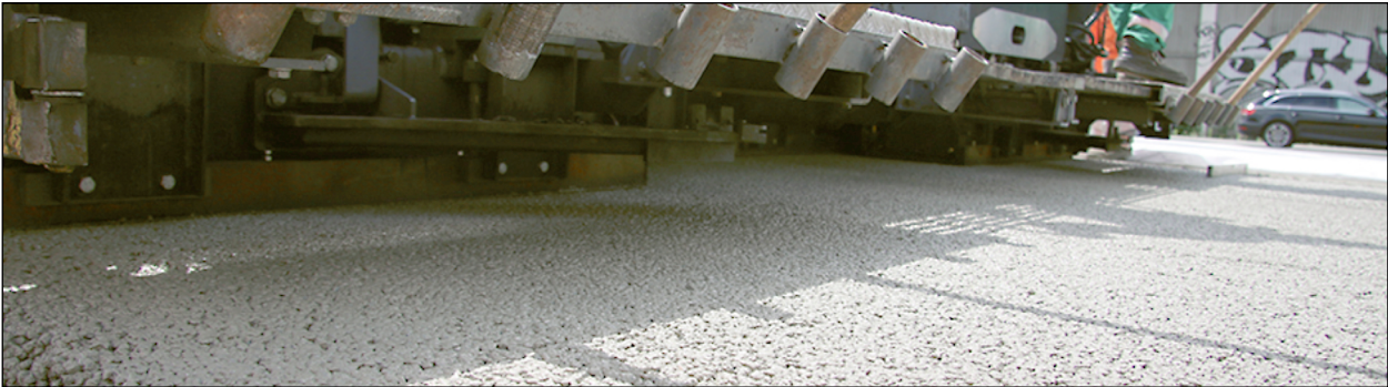
Bild 21: Fertiger beim Einbau des OPB auf der duraBAST (Bundesanstalt für Straßenwesen, 2017c)
