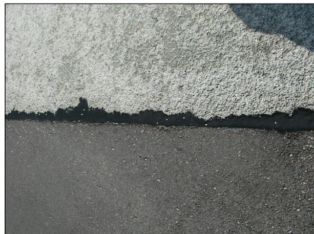
Bild 136: Randbereich zum Asphalt
