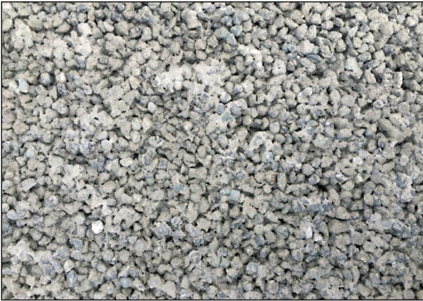
Bild 87: Oberfläche nach dem Auswaschen
