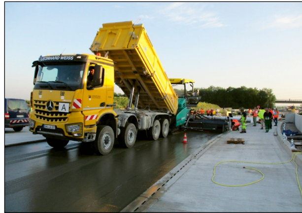
Bild 83: Antransport des OPB
