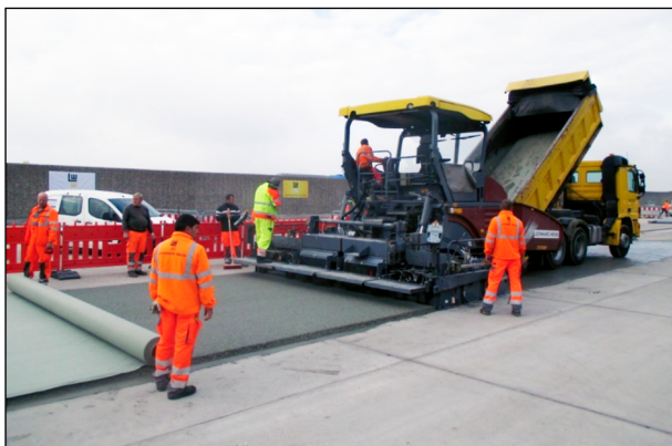
Bild 15: Einbau des OPB mit HV-Bohle
