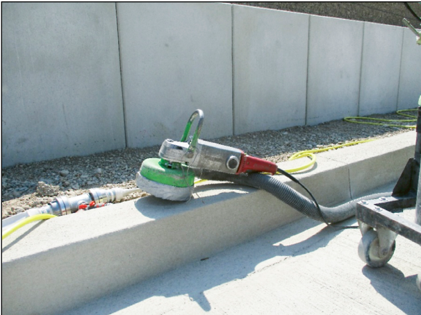
Bild 57: Handschleifgerät für die Randbereiche
