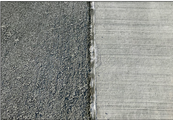
Bild 88: Anschlussbereich zur Lkw-Stellfläche
