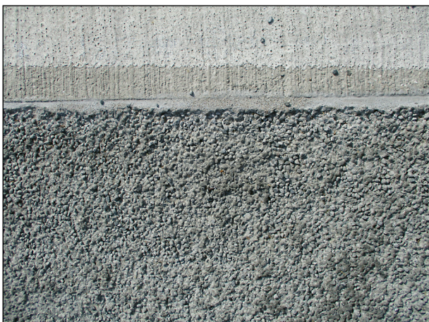
Bild 135: Randbereich mit PCC-Mörtel
