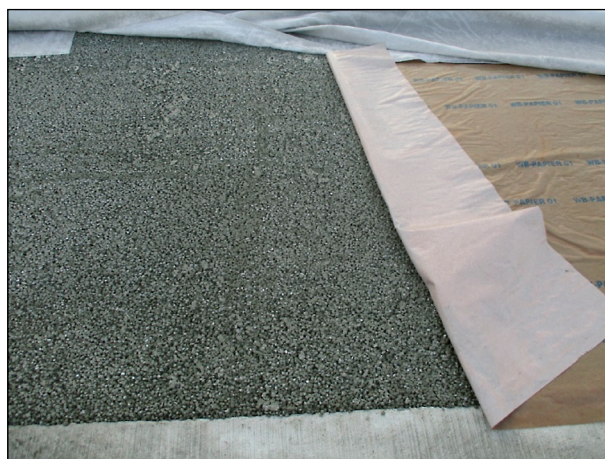
Bild 85: Entfernen des Waschbetonpapiers
