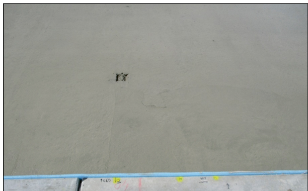
Bild 60: Freigelegtes Leerrohr
