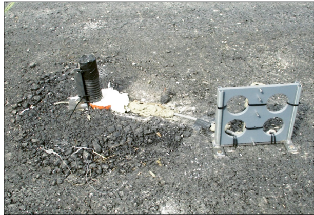
Bild 58: Messaufbau mit Leerrohr vor der Herstellung des UB
