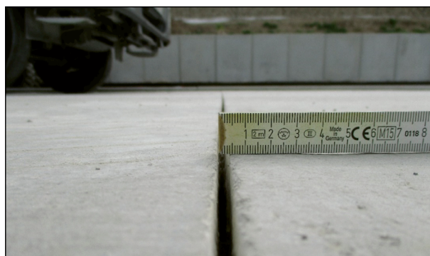
Bild 54: Ausführung des Kerbschnitts vor der Aufweitung
