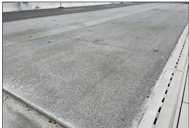
Bild 22: Fertiggestellter OPB auf der duraBAST (LANGER, 2018)
