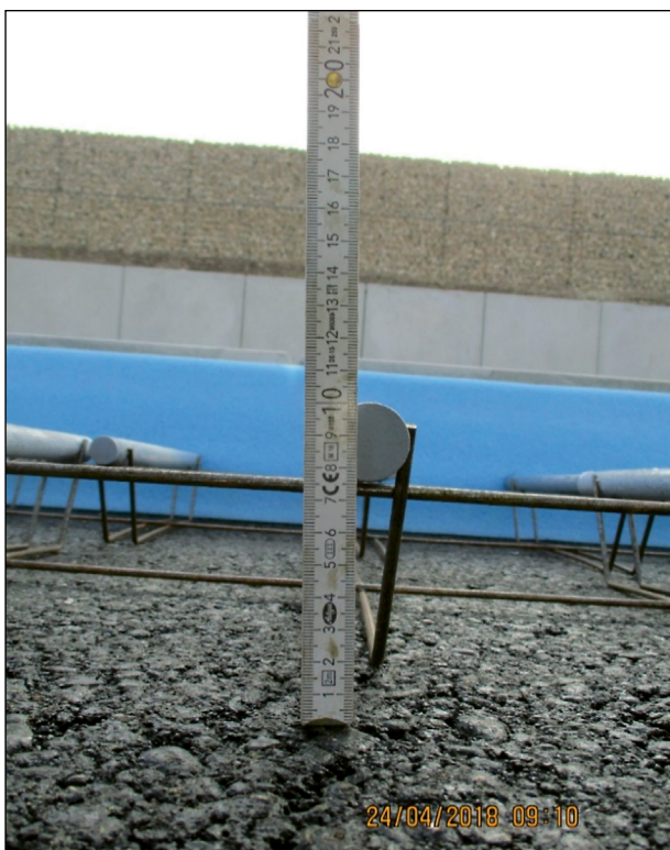
Bild 52: Dübellege im Unterbeton
