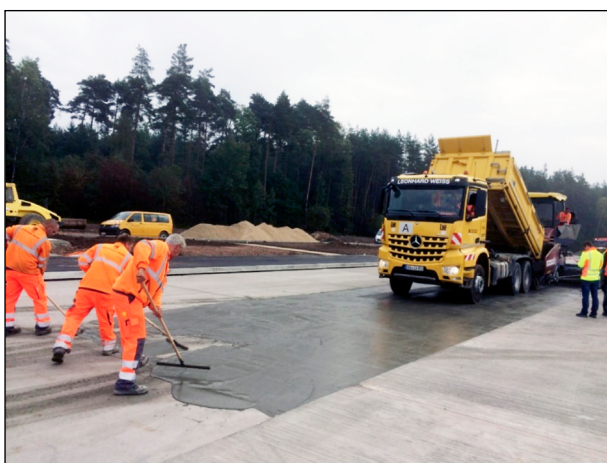
Bild 14: Manuelle Aufbringung der Haftbrücke vor Einbau des OPB
