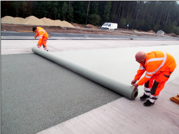
Bild 17: Abdeckung des OPB mit Vlies
