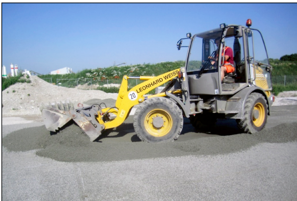
Bild 82: Rückbau des Probefeldes
