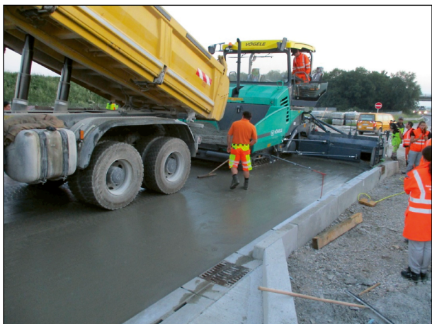
Bild 68: Nacharbeiten der Fahrspuren
