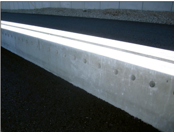
Bild 50: Schlitzrinne mit Perforationen
