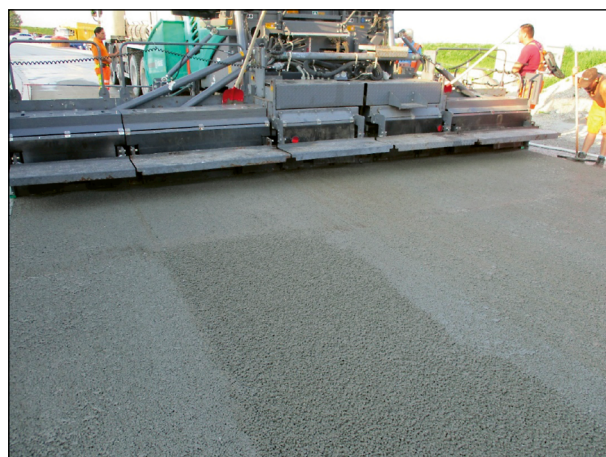
Bild 79: Variation der Vibration beim Probefeldeinbau
