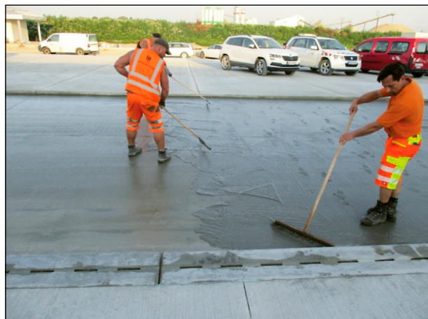
Bild 67: Aufbringung der Haftbrücke
