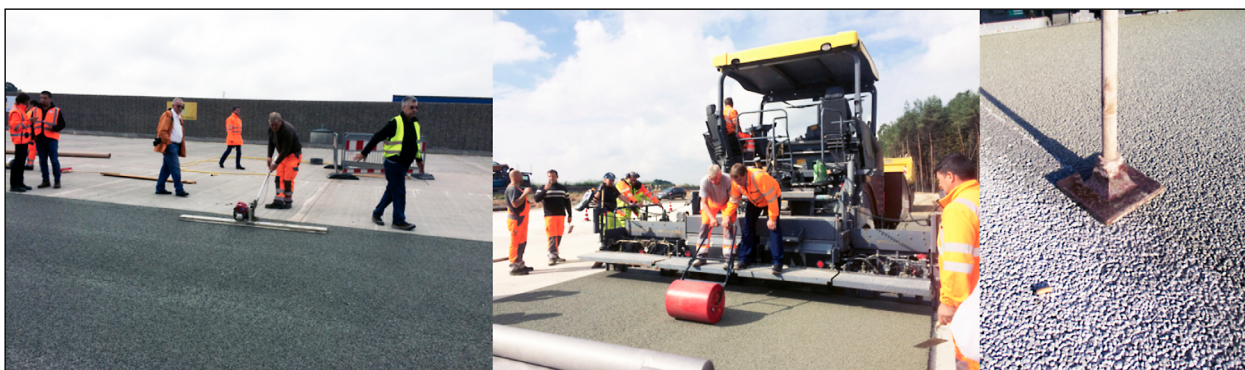
Bild 16: Partielle Bearbeitung der Oberfläche, Silberbach
