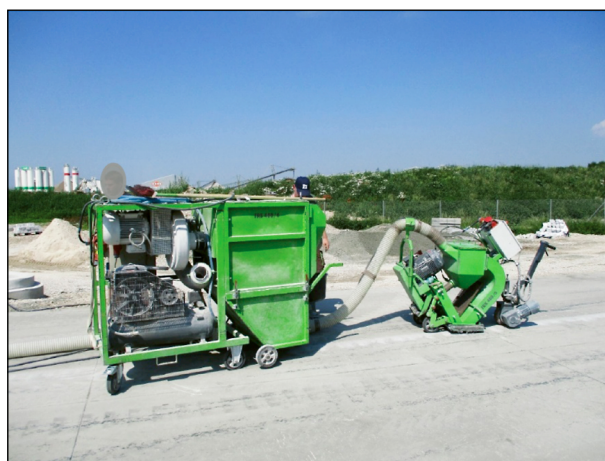
Bild 56: Kugelstrahlreinigung der UB Oberfläche
