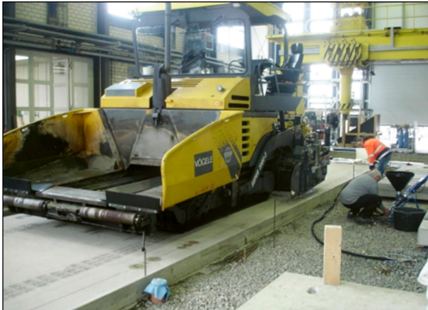
Bild 9: Einbau des OPB (HOFMEISTER, 2017)
