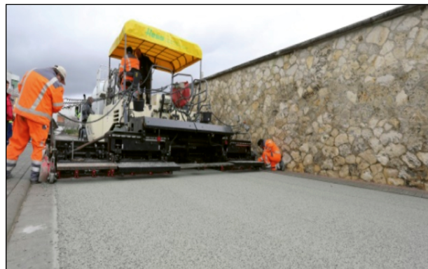
Bild 11: Einbau OPB (InformationsZentrum Beton GmbH, 2013)
