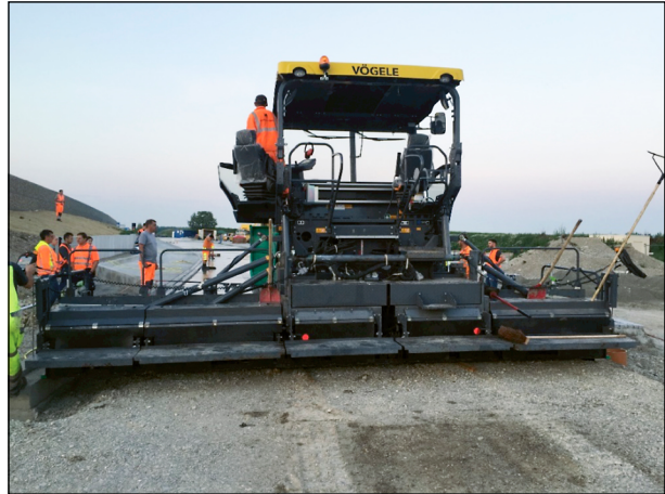
Bild 76: Straßenfertiger mit angebauten Bohlensegmenten
