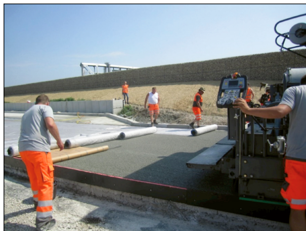
Bild 84: Auflegen Vlies und Waschbetonpapier
