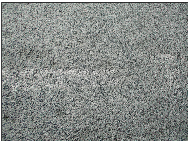
Bild 137: OPB PWC-Anlage Brunngas, nach 10 Monaten Liegezeit
