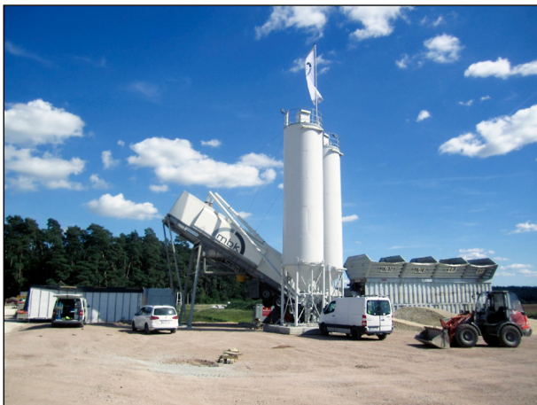
Bild 13: Mobile Mischanlage zur Herstellung des OPB
