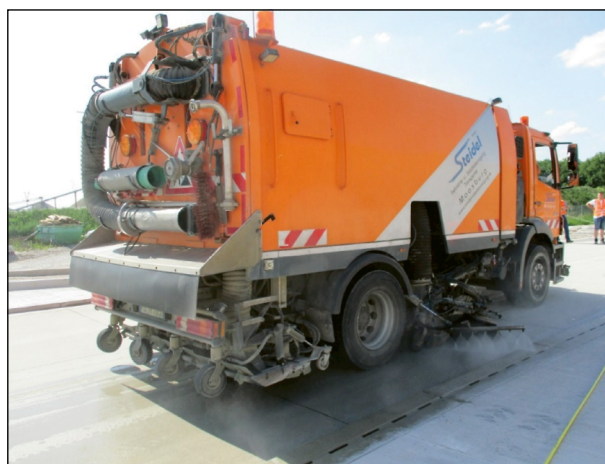
Bild 55: Reinigungsfahrzeug zur Oberflächenreinigung des UB
