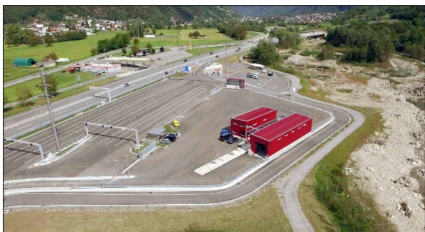
Bild 6: Kontrollplatz des Schwerverkehrskontrollzentrums im schweizerischen San-Vittore (© ASTRA, Sekundärquelle: Alpen-Initiative, „Kontrollzentrum San Vittore. Primärquelle: Bundesamt für Strassen ASTRA, „Kontrollzentrum San Vittore“)
