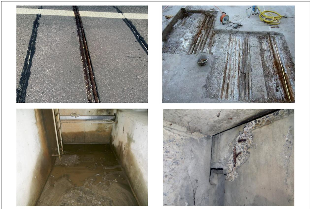
Bild 7-3: Typische Schädigungen an Stahl- und Spannbetonbrücken (Fotos: Kristian Schellenberg)
