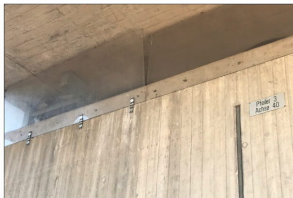
Bild 22: Achse 40 Lager 40.1 Demontage Vogelschutz
