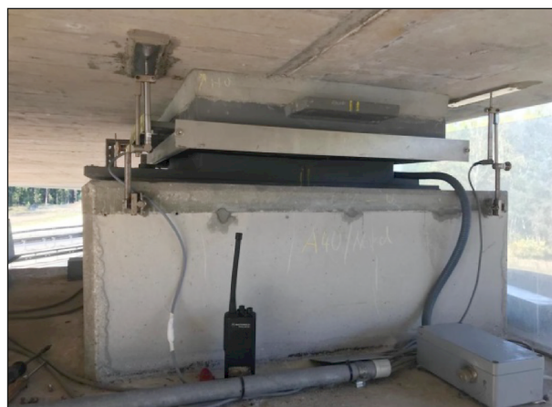
Bild 23: Lager 40.1 Bereich Wartung/Reparatur
