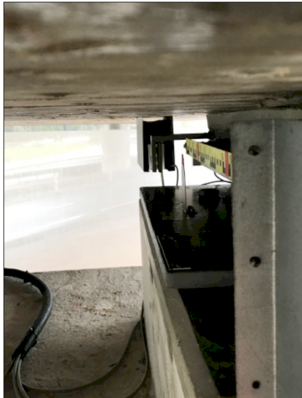
Bild 17: Lager 40.1 Sichtkontrolle
