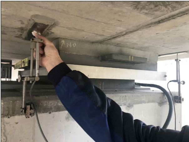
Bild 25: Achse 40 Lager 40.1 – Wartung Sensoren
