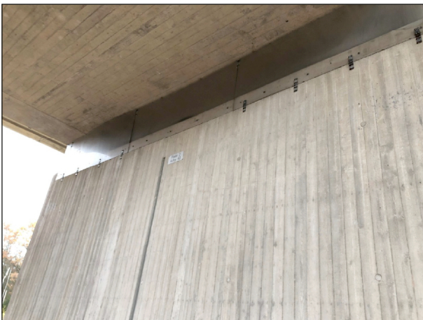
Bild 26: Achse 40 – Vogelschutz nach Reparatur
