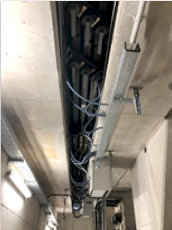
Bild 27: ÜK nach Wartungsarbeiten
