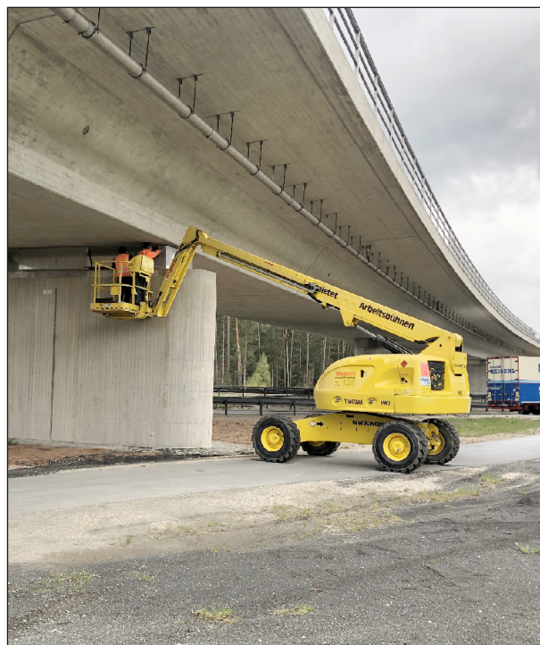
Bild 34: Achse 40 Lager 40.1 Durchführung der Wartungsarbeiten
