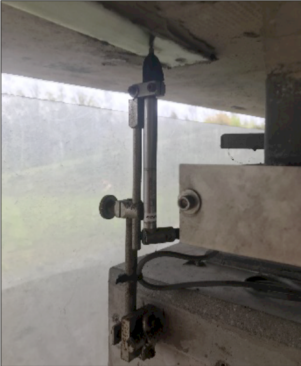
Bild 36: Wartungsarbeiten an MS28v
