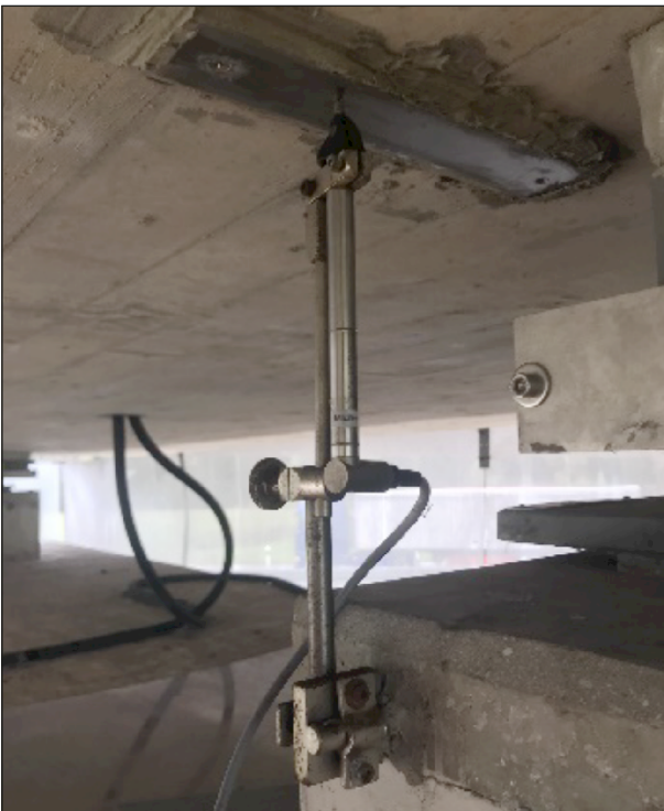
Bild 37: Wartungsarbeiten an MS29v
