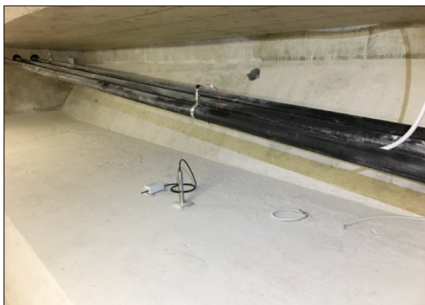
Bild 18: Beschleunigungssensoren am Spannseil
