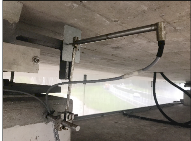
Bild 38: Wartungsarbeiten an MS 30h
