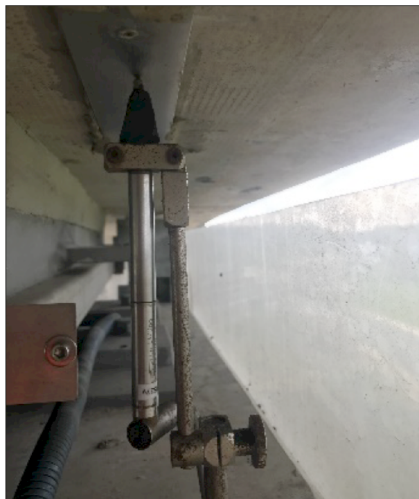
Bild 35: Wartungsarbeiten an MS27v
