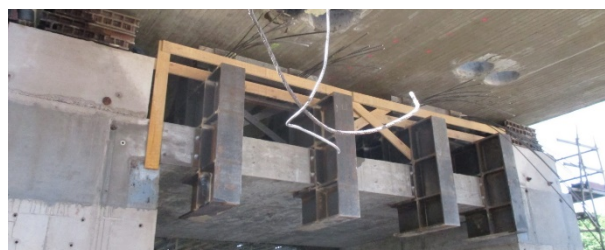
Bild 3-38: Zugstrangverankerung an H109 (© HOCHTIEF)
