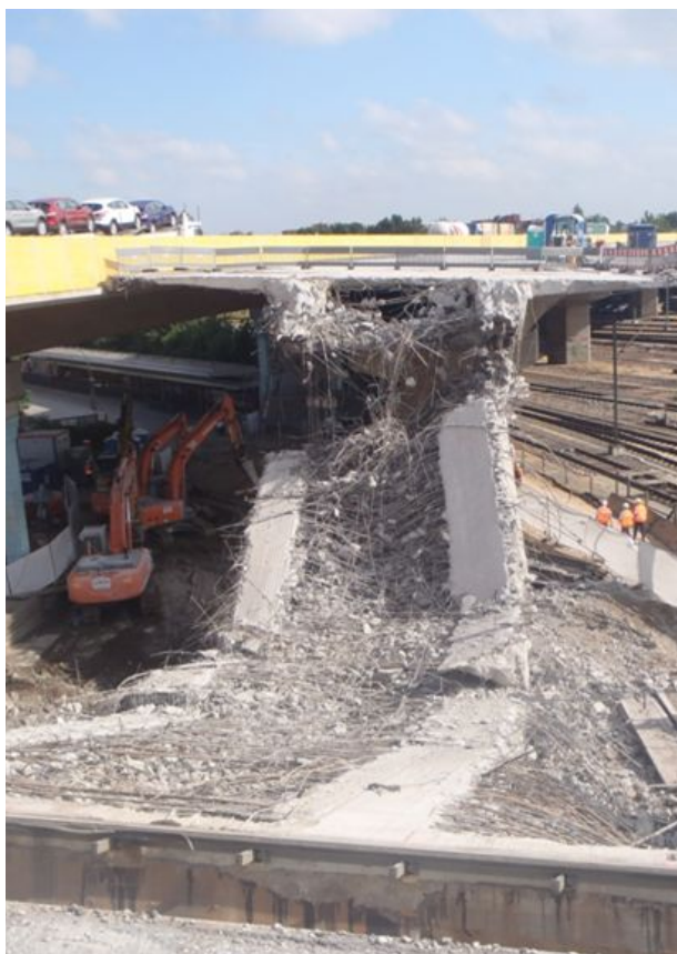
Bild 3-23: Abgesenkte Stege mit Bodenplatte – Ansicht von oben (© HOCHTIEF/Zoran Zivanic)
