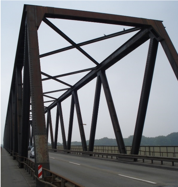
Bild 3-4: Fachwerkkonstruktion der alten Strombrücke (© Schüßler-Plan)
