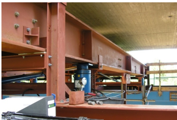
Bild 4-21: Teilbare, hydraulisch gestützte Grundrahmen im Abbruchzustand (© thyssenkrupp Infrastructure)
