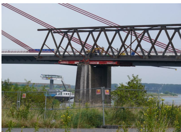
Bild 3-11: Vershubträger am Stropfteilern (© Traggerüste Weise)
