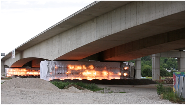
Bild 1-22: Explosion des Pfeilers (© IMAGOCURA, Jürgen Stresius)
