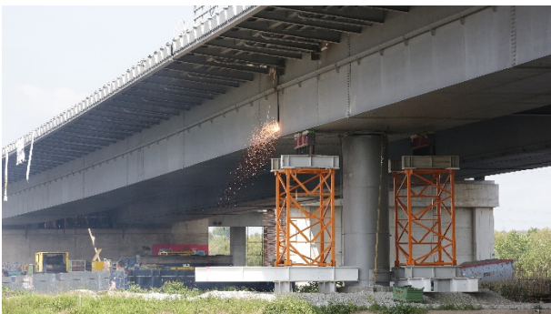
Bild 2-1: Durchschneiden des gelagerten Überbaus (© IMAGOCURA, Jürgen Stresius)
