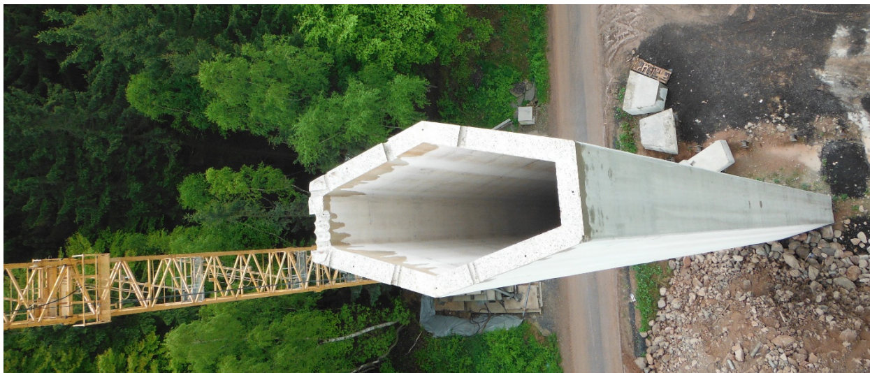
Bild 4-20: Pfeilerschaft nach Abnehmen der Pfeilerkopfsegmente (© Adam Hörnig Baugesellschaft mbH & Co. KG)
