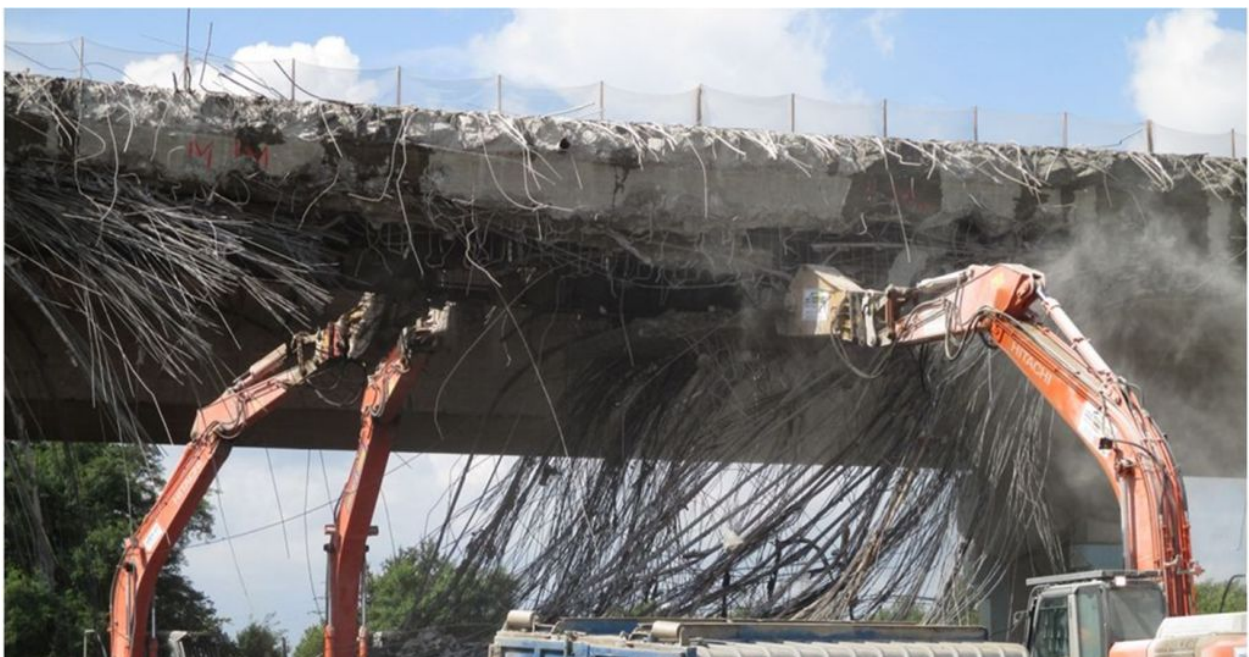
Bild 3-22: Kontrolliertes Absenken des Troges (© HOCHTIEF/Roland Garn)
