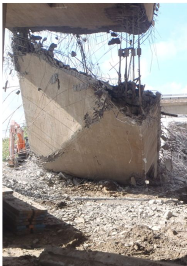
Bild 3-24: Abgesenkte Stege mit Bodenplatte – Ansicht von unten (© HOCHTIEF/Zoran Zivanic)
