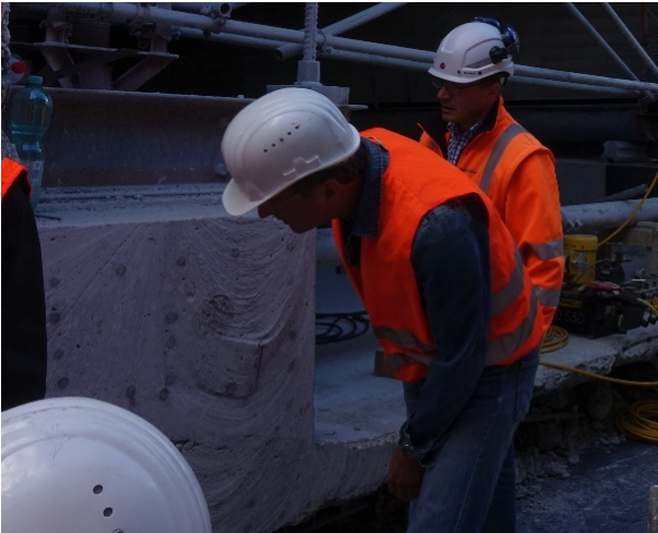
Bild 4-11: Überprüfung der nachträglichen Verankerung der Spannglieder an einem Trennschnitt (© Marx Krontal Partner)
