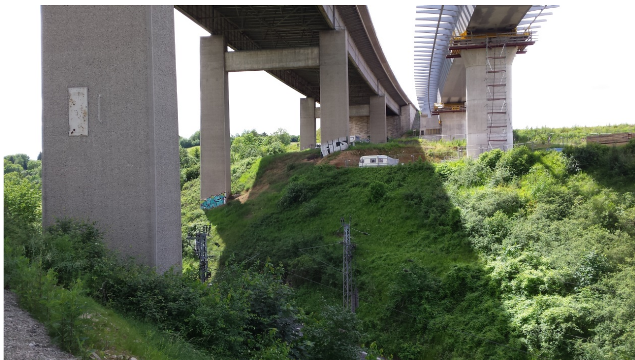
Bild 7-7: Geländesituation Bahnfeld Bestandsbauwerk (© Ed. Züblin AG)
