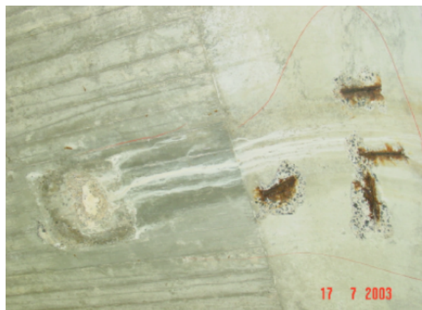
Bild 4-30: Aussinterungen im Kragarmbereich (© Hessen Mobil)
