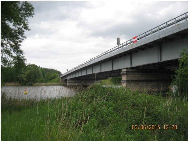
Bild 10-19: Gesamtansicht des Bauwerks vor Beginn der Bauarbeiten (© Ingenieurbüro Dipl.-Ing. Ulrich Jünger)
