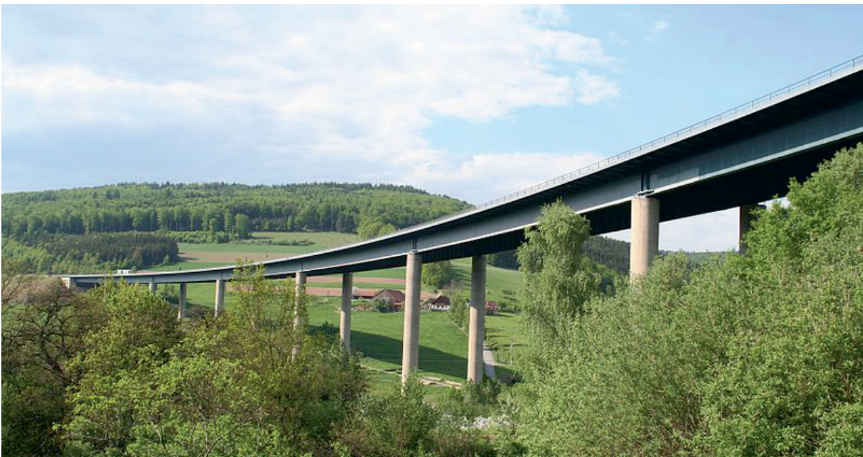
Bild 1-2: Bestandsbauwerk (© Max Bögl)
