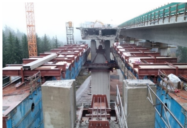
Bild 4-22: Teilbare, hydraulisch gestützte Grundrahmen in Verschiebeposition (© thyssenkrupp Infrastructure)
