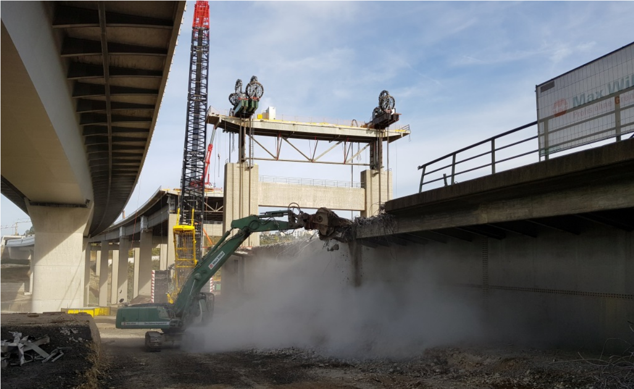
Bild 7-19: Abbruch abgesenktes Feld I-II (© Ed. Züblin AG)
