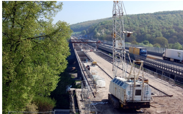
Bild 7-31: Abbruch der Fahrbelagplatte (© Schüßler-Plan)
