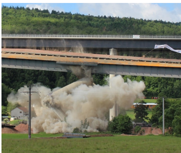
Bild 1-14: Pfeiler knickt ein, Überbau folgt der Schwerkraft (© Thüringer Sprenggesellschaft mbH)
