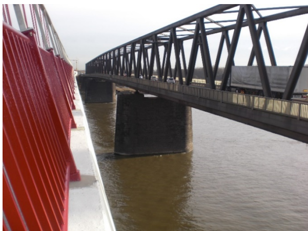
Bild 3-15: Bestandsbrücke neben dem Neubau (© Schüßler-Plan)
