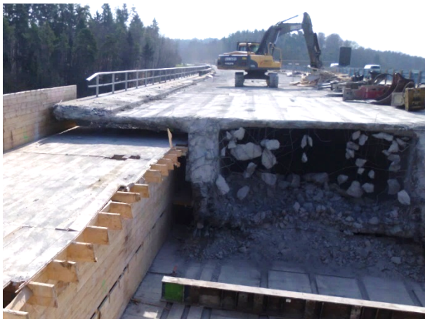
Bild 5-3: Abbruch auf die Holzschalung mit Hilfe eines Abbruchbaggers am Überbau Nord (© RP Freiburg)
