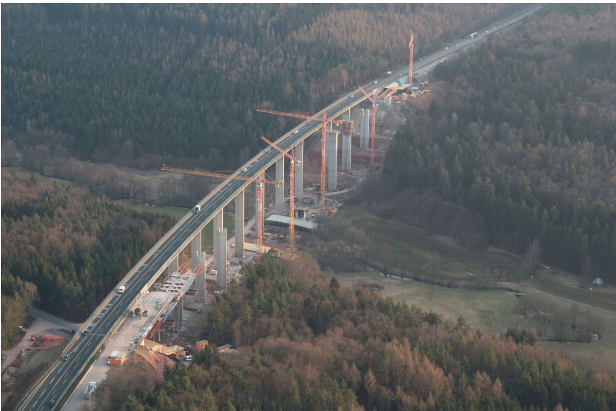
Bild 0-1: Rück- und Ersatzneubau der Döllbachtalbrücke (© Adam Hörnig Baugesellschaft mbH & Co. KG)
