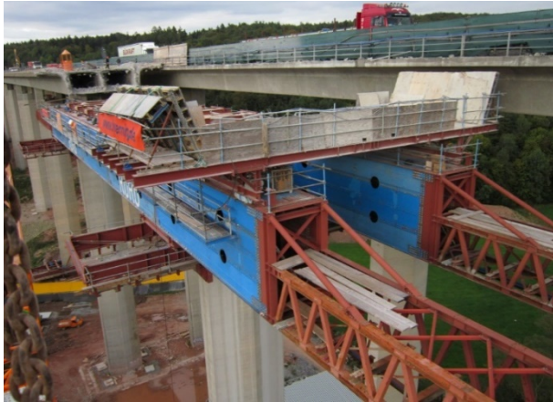
Bild 4-24: Ansicht Abbruchbühne vor Verschieb des VSG in den nächsten Abbruchabschnitt (© thyssenkrupp Infrastructure)
