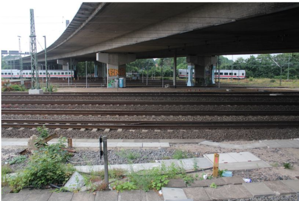
Bild 3-17: Brücke vor dem Abbruch (© HOCHTIEF)
