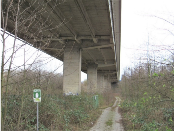
Bild 9-9: Untersicht des Querschnitts mit Hammerkopfstützen (© Schüßler-Plan)
