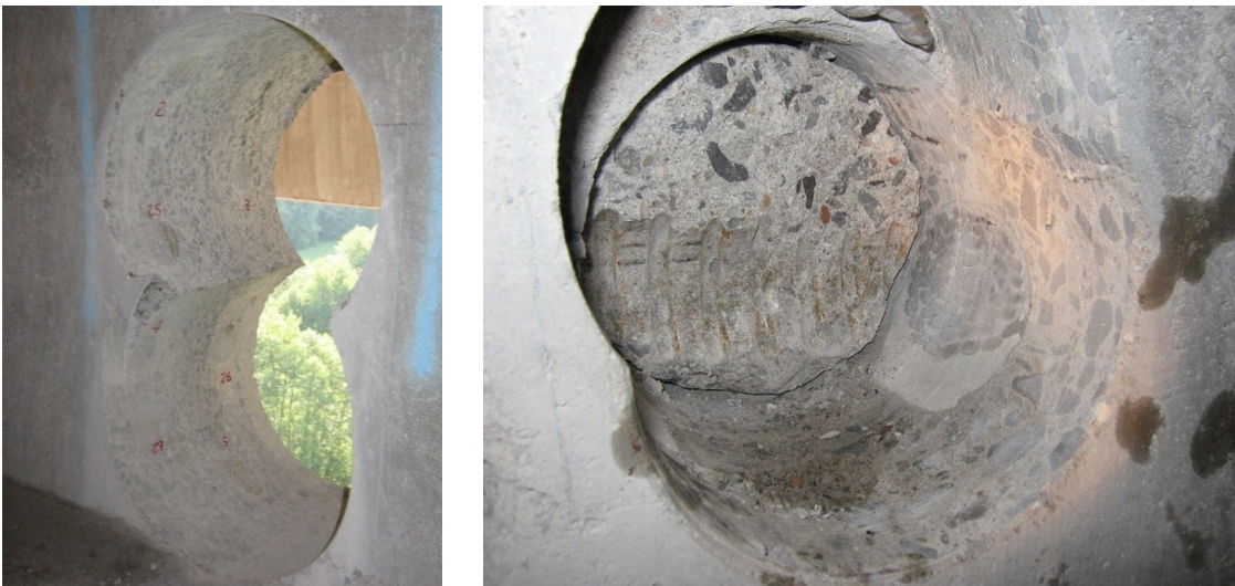
Bild 4-39: Kernbohrungen zum Trennen der Längsspannglieder im Brückensteg (© Adam Hörnig Baugesellschaft mbH & Co. KG)
