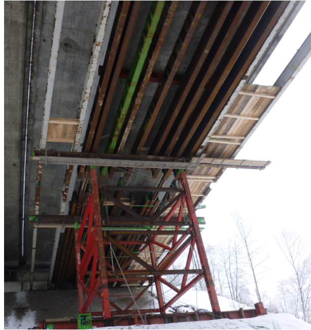
Bild 5-6: Traggerüstturm mit Längs- und Querträgern des Überbaus Nord (© Ingenieurgruppe Bauen)
