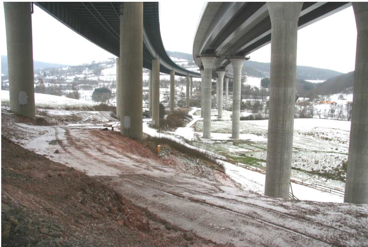
Bild 1-6: Bestandsbauwerk (links) – neue Brückenhälfte (rechts) (© Max Bögl)
