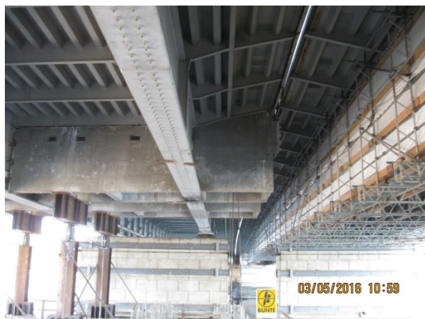
Bild 10-20: Untersicht mit Betonrost (© Ingenieurbüro Dipl.-Ing. Ulrich Jünger)
