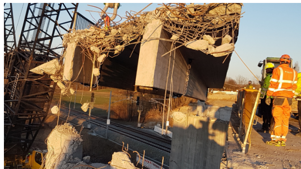
Bild 10-16: Rückbau östliches Widerlager (© Max Wild GmbH)
