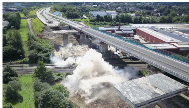
Bild 9-24: Sprengen der Pfeiler neben den Gleisen (© Die Autobahn GmbH des Bundes)
