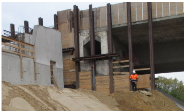
Bild 3-39: Mittelstreifen Verbau Achse 16 (© HOCHTIEF)
