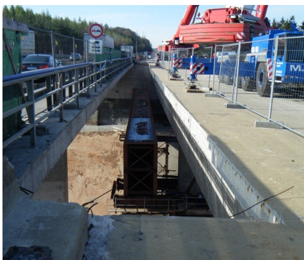
Bild 4-40: Freigeschnittener Kragarm zur Montage des VSG im 1. Abschnitt (© thyssenkrupp Infrastructure)
