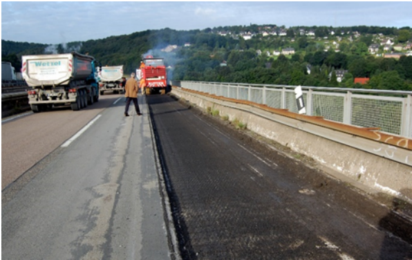
Bild 7-28: Rückbau des Fahrbelags (© Schüßler-Plan)
