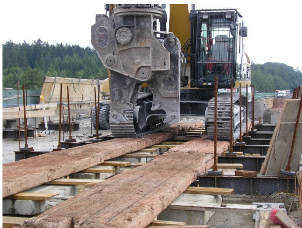
Bild 4-42: Überfahrt des Abbruchbaggers über temporären Zwischenpfeiler nach Rückbau des ersten Teils des Hauptfeldes (© thyssenkrupp Infrastructure)
