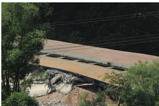
Bild 1-15: Pfeiler und Überbau nach der Sprengung (© Thüringer Sprenggesellschaft mbH)
