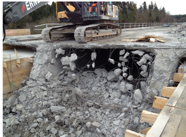
Bild 5-4: Abbruch auf die Holzschalung mit Hilfe eines Abbruchbaggers am Überbau Nord (© RP Freiburg)
