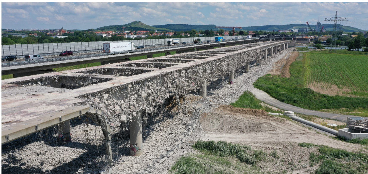
Bild 9-5: Perforierte westliche Vorlandbrücke (© IMAGOCURA, Jürgen Stresius)
