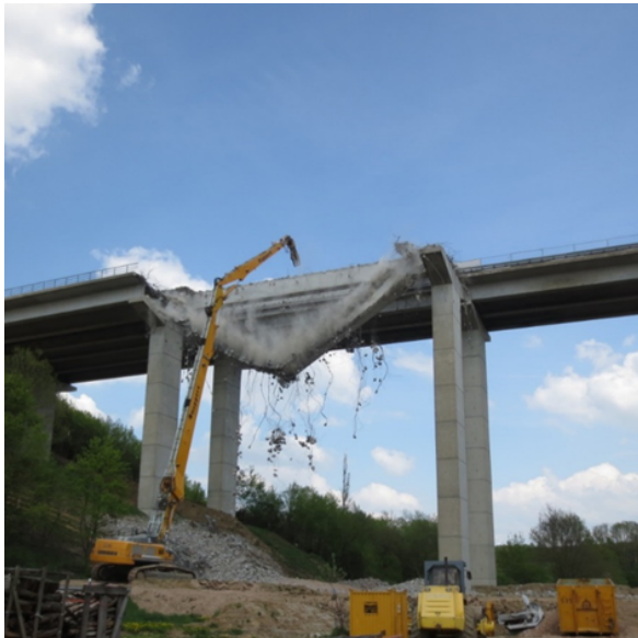
Bild 8-9: Abbruch der Längsträger mit einem Longfrontbagger (© Adam Hörnig Baugesellschaft mbH & Co. KG)
