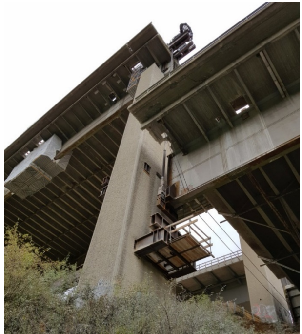
Bild 7-17: Anschlagpunkt Litzentechnik am Hauptträgerende (© Ed. Züblin AG)
