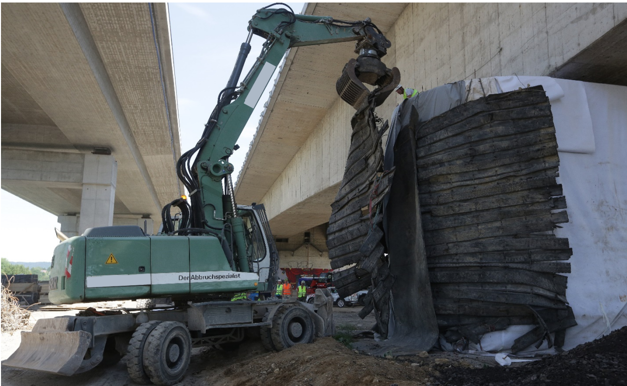
Bild 1-21: Installation des Streifflugschutzes (© IMAGOCURA, Jürgen Stresius)
