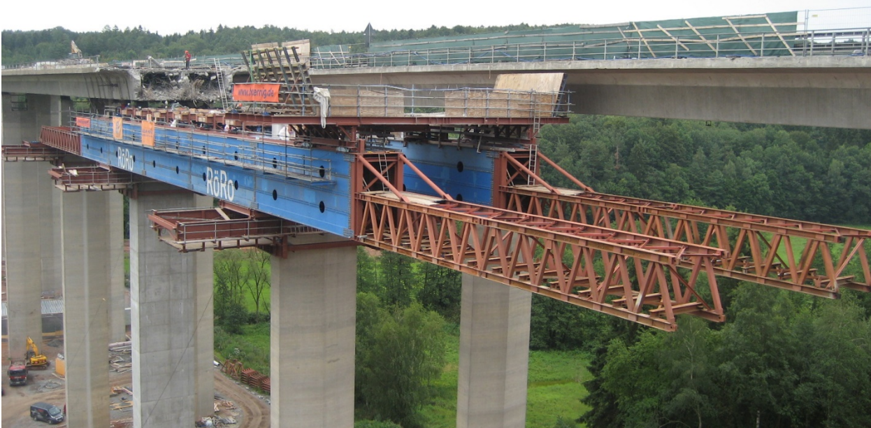
Bild 4-17: Abschnittsweser Rückbau des Überbaus durch Abbruchbagger (3. Abschnitt, 1. Hälfte des 70 m-Feldes) (© thyssenkrupp Infrastructure)
