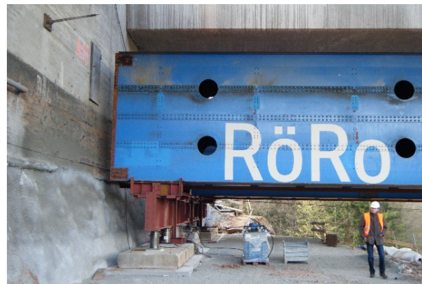
Bild 4-37: Widerlager nach Sicherung bei Montage VSG (© thyssenkrupp Infrastructure)
