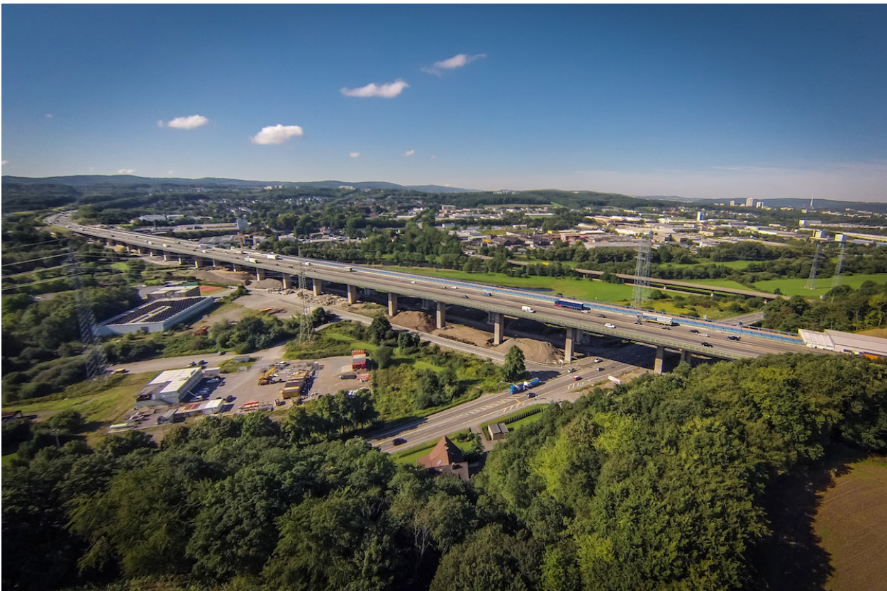
Bild 9-6: Lennetalbrücke aus der Vogelperspektive (© Moß Abbruch-Erdbau-Recycling)
