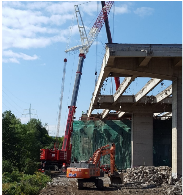
Bild 9-22: Ausheben der Fahrbahnplatte im Bereich Gleise (© Die Autobahn GmbH des Bundes)
