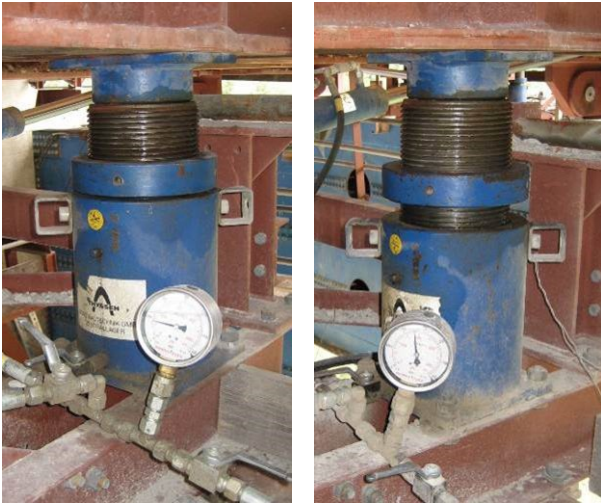
Bild 4-44: Hydraulikpresse und Lage des (noch nicht nachgestellten) Stellrings vor und nach Anpassung des Pressendruckes (© BÜCHTING + STREIT AG)
