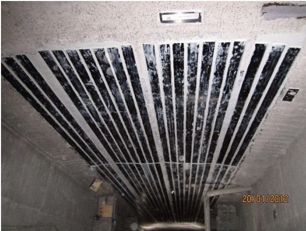
Bild 4-34: Verstärkung durch in Längsrichtung aufgeklebte CFK-Lamellen an der Unterseite der Hohlkastendecke (© Adam Hörnig Baugesellschaft mbH & Co. KG)
