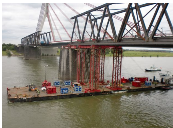
Bild 3-12: Übergabe auf den Ponton (© Traggerüste Weise)
