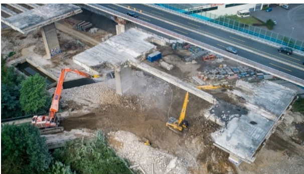
Bild 9-21: Sukzessives Ausstemmen der Längsträger (© Moß Abbruch-Erdbau-Recycling)
