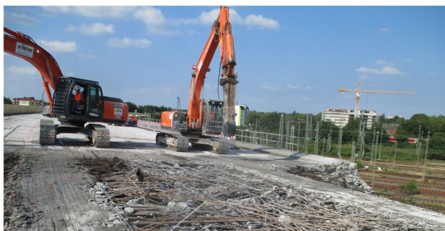
Bild 3-20: Abbruch der Kragarme (© HOCHTIEF)
