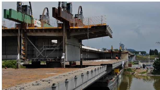
Bild 2-2: Absenkvorgang des südlichen Überbaus (© IMAGOCURA, Jürgen Stresius)
