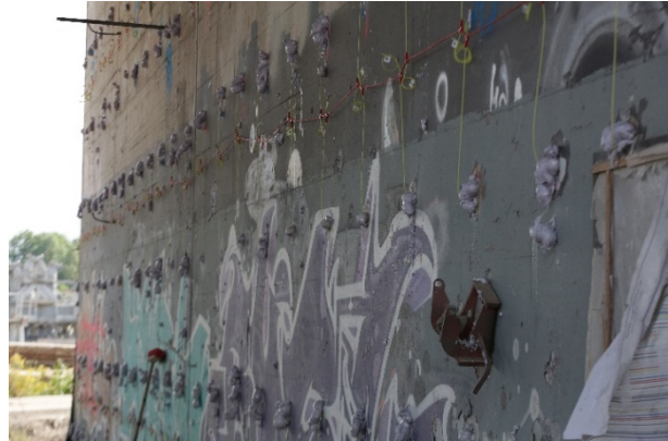
Bild 1-20: Pfeiler mit den Sprengstofflöchern (© IMAGOCURA, Jürgen Stresius)
