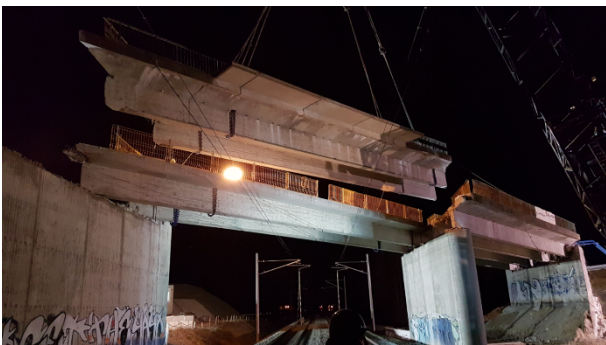
Bild 10-15: Überbau Auskranken über Gleise (© Max Wild GmbH)
