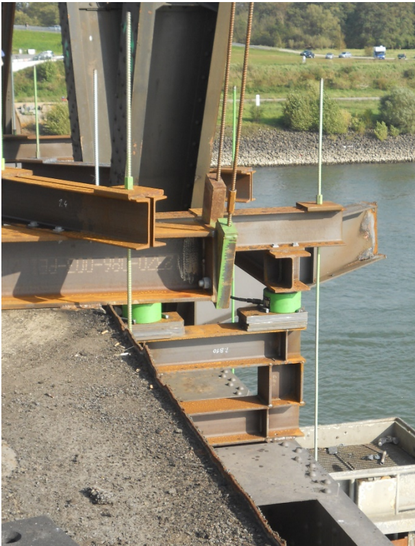
Bild 3-16: Ausgeführte Querkraftkopplung (© Schüßler-Plan)
