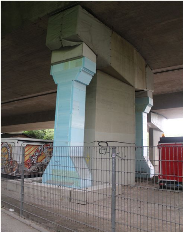
Bild 3-41: Temporäre Verstärkung der Hammerköpfe an der Westbrücke (© HOCHTIEF)
