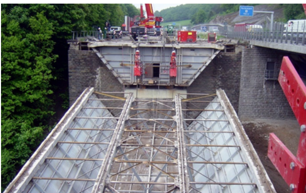
Bild 7-32: Ablassen mittels Litzenhebern (© Schüßler-Plan)
