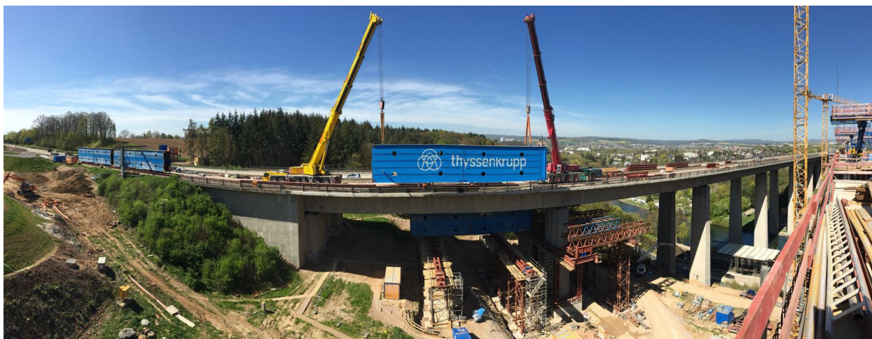
Bild 4-12: Montage der Vorschubrüstung vom Überbau mit Mobilkränen (© thyssenkrupp infrastructure)
