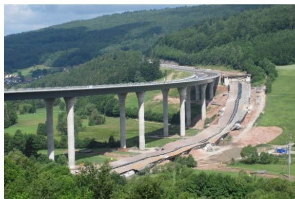
Bild 1-16: Bestandsbrücke nach der Sprengung (© Thüringer Sprenggesellschaft mbH)
