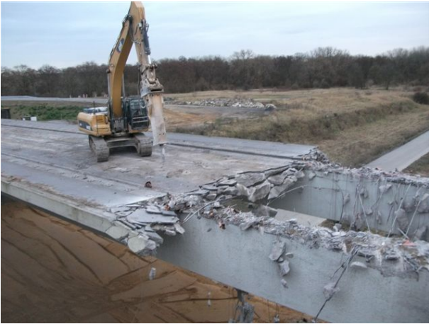
Bild 3-13: Rückbau der Vorlandbrücken (© Schüßler-Plan)
