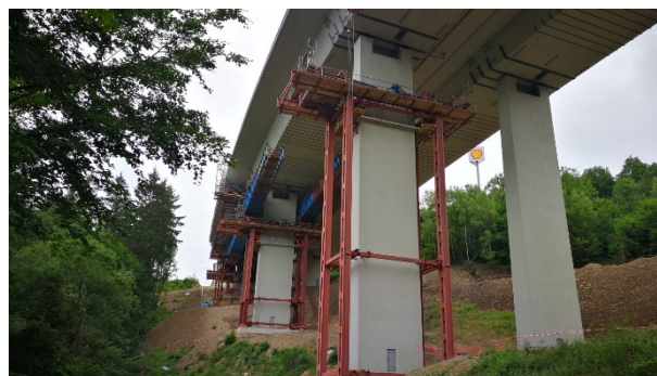
Bild 4-56: Vorschubgerüst mit bodengestützter Pfeilereinrüstung, Stützhöhe ca. 25 m (© thyssenkrupp Infrastructure GmbH)
