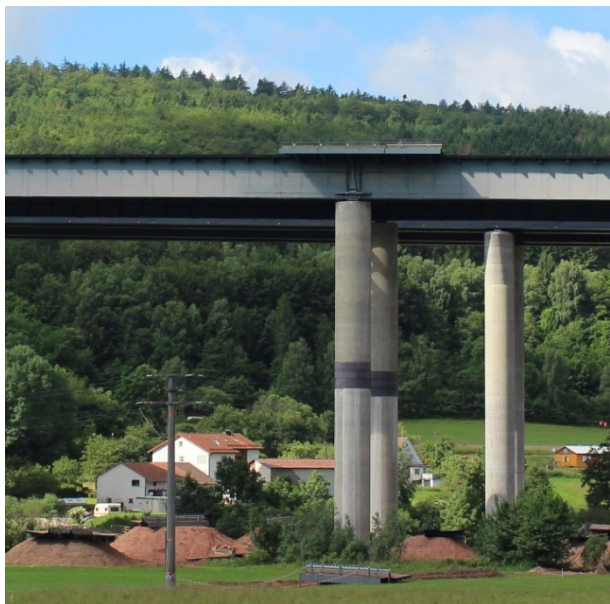
Bild 1-12: Pfeiler kurz vor der Sprengung (© Thüringer Sprenggesellschaft mbH)
