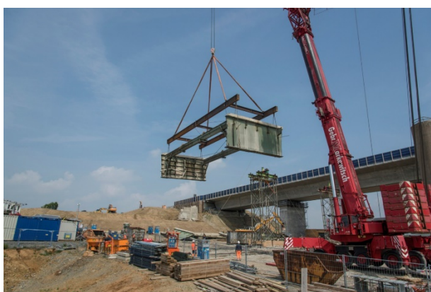
Bild 10-28: Ausheben eines 10 m-Elements mittels Traverse (© Wolfgang Mordhorst)
