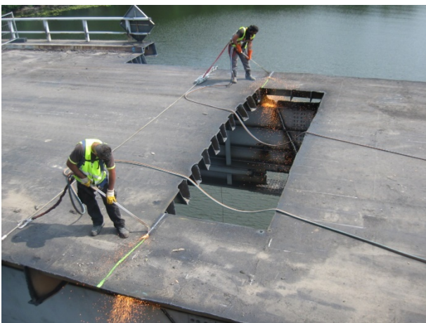
Bild 10-21: Trennschnitt in Bauwerksmitte (© Ingenieurbüro Dipl.-Ing. Ulrich Jünger)
