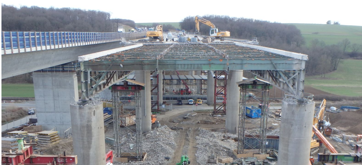
Bild 10-24: Stahlobergurt mit verbleibender Betonverstärkung und Hilfsstützen (© Büchting + Streit AG)
