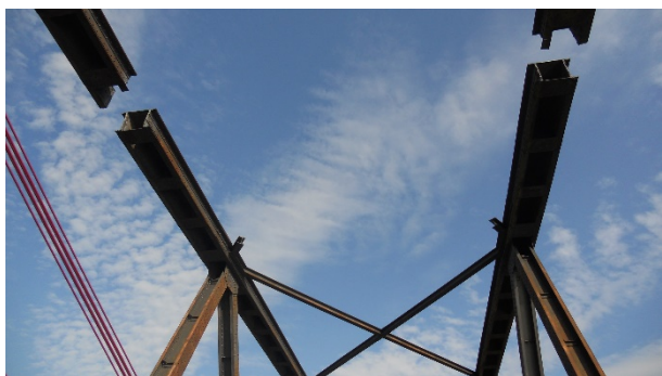
Bild 3-8: Durchtrennter Überbau mit Höhenversatz (© Schüssler-Plan)
