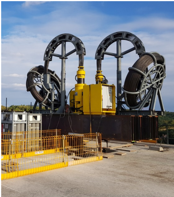
Bild 7-16: Einsatzbereit montierte Litzentechnik (© Ed. Züblin AG)
