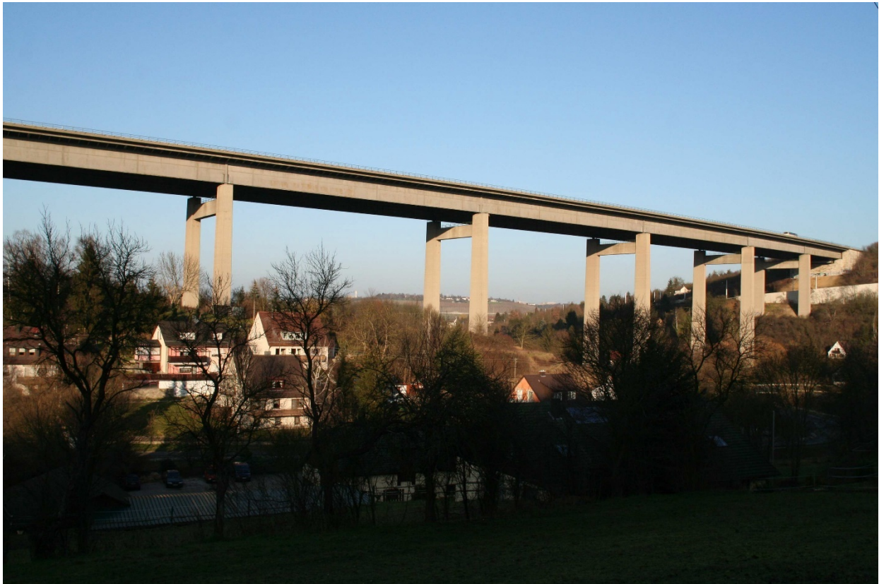
Bild 7-1: Talbrücke Heidingsfeld im Jahr 2014 Blick Richtung Nürnberg (© ABDN)
