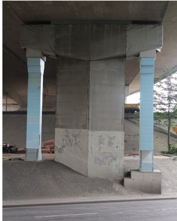
Bild 3-42: Temporäre Verstärkung der Hammerköpfe an der Westbrücke (© HOCHTIEF)
