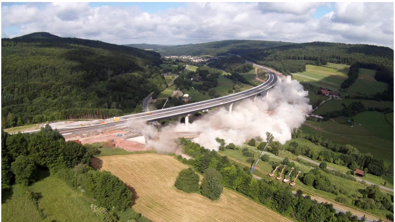
Bild 1-17: Staubentwicklung während der Sprengung (© Thüringer Sprenggesellschaft mbH)
