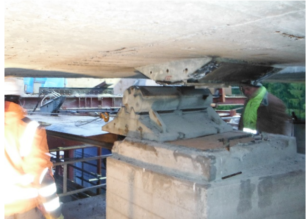
Bild 4-25: Ausbau der Brückenlager (© thyssenkrupp Infrastructure)
