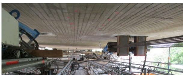
Bild 3-40: Litzenheber an den Steckträger (© HOCHTIEF)
