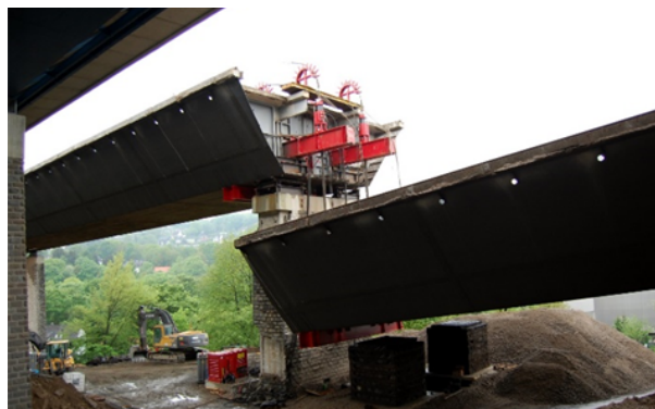
Bild 7-33: Ablassen mittels Litzenhebern (© Schüßler-Plan)
