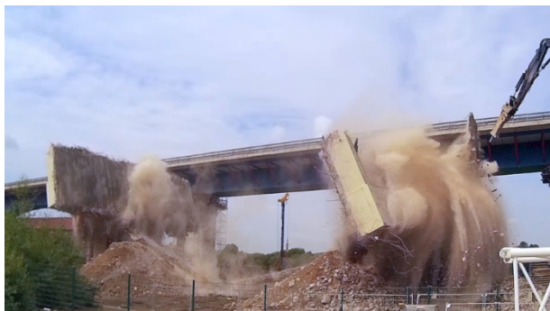
Bild 9-23: Choreografie des Rückbaus (© Weissenfels Ingenieure)
