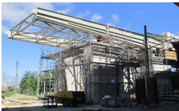
Bild 3-32: Montage des Schnabels Überbau West (© HOCHTIEF)
