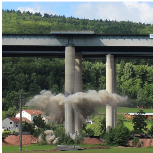
Bild 1-13: Pfeiler im Moment der Sprengung (© Thüringer Sprenggesellschaft mbH)
