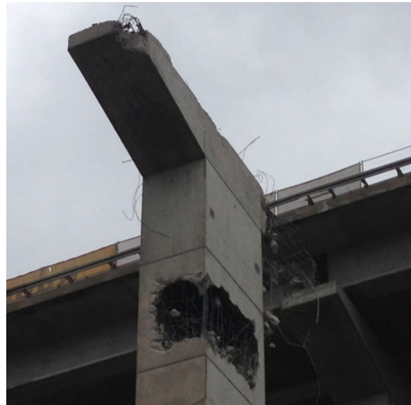
Bild 8-10: Herstellung Fallmaul für Pfeilerkopfabwurf (© Adam Hörnig Baugesellschaft mbH & Co. KG)
