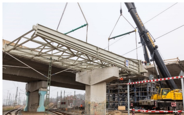
Bild 3-33: Montage des Schnabels Überbau Ost (© HOCHTIEF)
