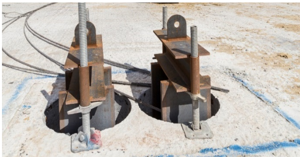
Bild 3-35: Steckträger (© HOCHTIEF)
