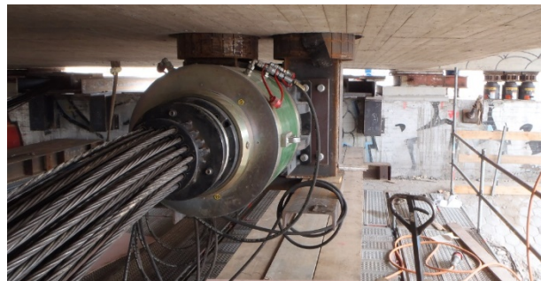
Bild 3-36: Presse am Steckträger und Zange am Widerlager 14 (© HOCHTIEF)
