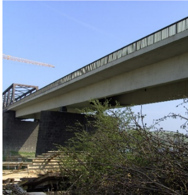
Bild 3-5: Vorlandbrücke der alten Rheinbrücke (© Schüßler-Plan)
