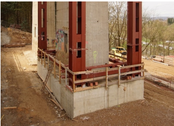
Bild 4-8: Fundamentkränze zur Aufständigung der Hilfsstützen (© Marx Krontal Partner)
