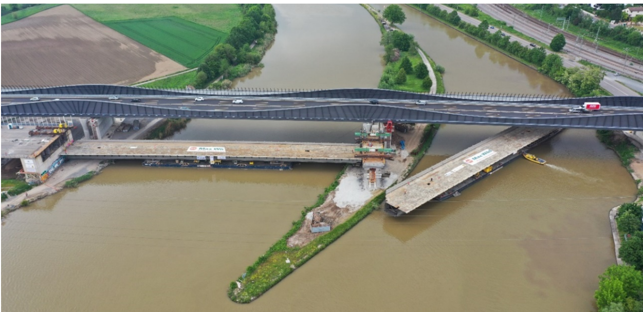
Bild 2-3: Ausschwimmen des nordöstlichen Überbaus; Teilbauwerk Nord-West auf dem Ponton gelagert (© IMAGOCURA, Jürgen Stresius)
