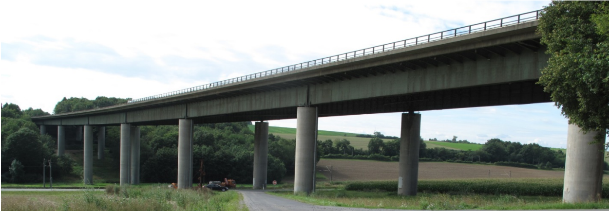
Bild 10-23: Bestandsbauwerk (Quelle: ABDNB)
