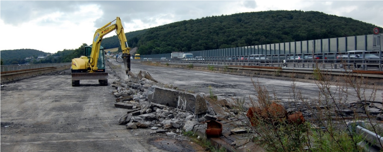
Bild 7-27: Leichtern des Überbaus durch Rückbau der Schutzeinrichtungen (© Schüßler-Plan)
