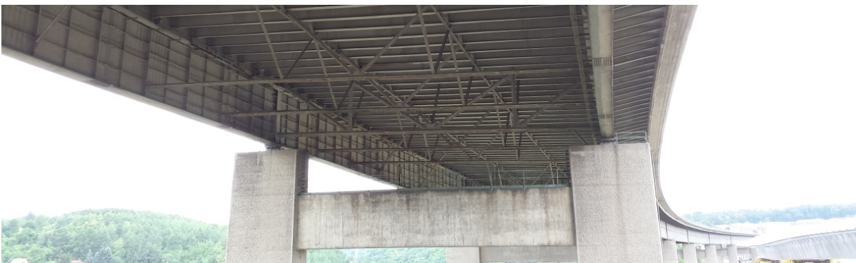
Bild 7-4: Brückenuntersicht im Jahr 2016 (© Ed. Züblin AG)
