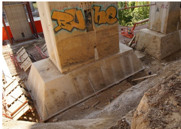
Bild 4-9: Schräge Bestandsfundamente (© Marx Krontal Partner)
