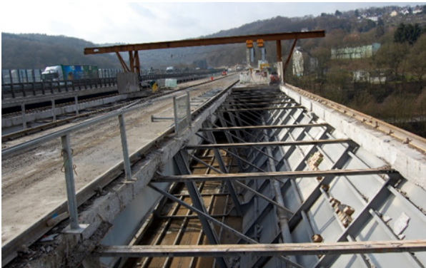
Bild 7-30: Abbruch der Fahrbelagplatte (© Schüßler-Plan)
