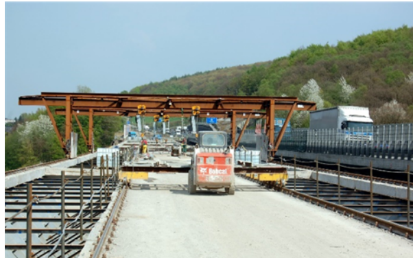
Bild 7-29: Demontagegerät für den Fahrbelagrückbau (© Schüßler-Plan)
