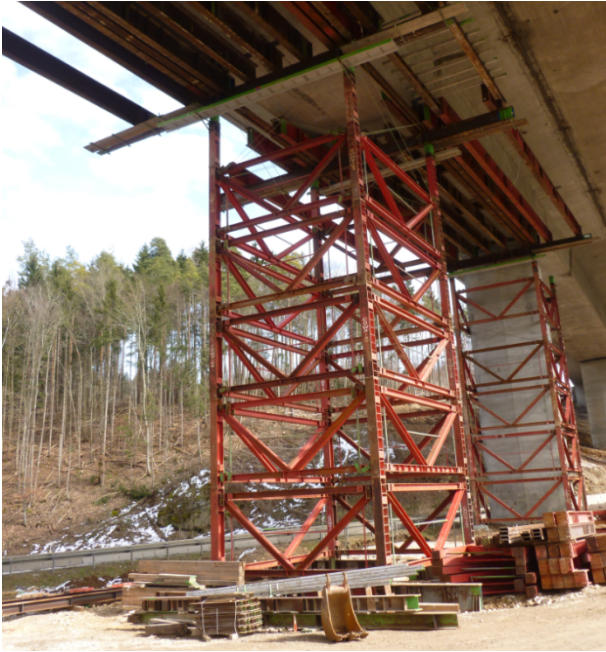
Bild 5-5: Traggerüstturm mit Längs- und Querträgern des Überbaus Nord (© Ingenieurgruppe Bauen)
