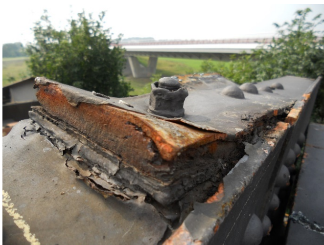
Bild 3-14: Massive Blattrostbildung (© Schüssler-Plan)
