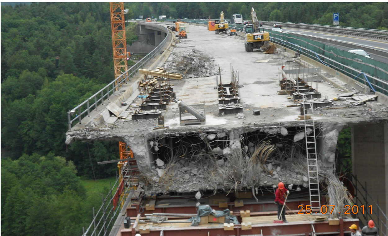
Bild 0-2: Rückbau der Döllbachtalbrücke (© Adam Hörnig Baugesellschaft mbH & Co. KG)
