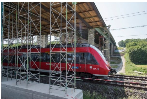
Bild 10-26: Stationäre Schutzgerüst über die Bahnlinie (© Wolfgang Mordhorst)
