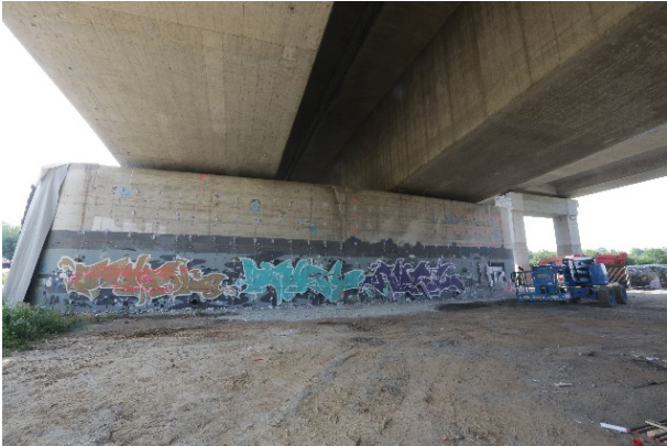
Bild 1-19: Pfeiler mit den Sprengstofflöchern (© IMAGOCURA, Jürgen Stresius)
