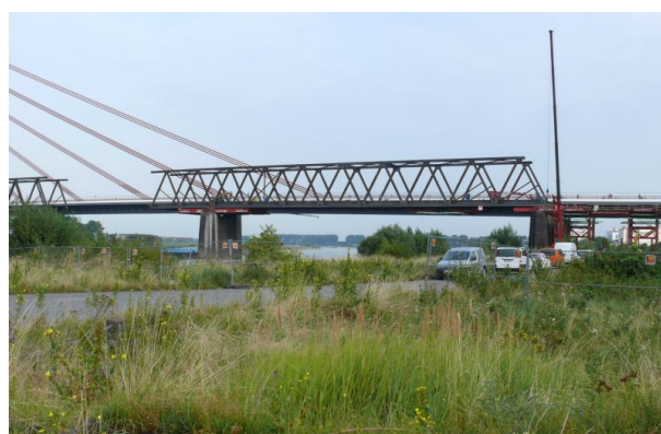
Bild 3-10: Vershub der Brücke (© Traggerüste Weise)
