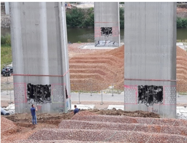
Bild 4-4: Vorschwächung der Pfeiler zur Sprengung (© Marx Krontal Partner)
