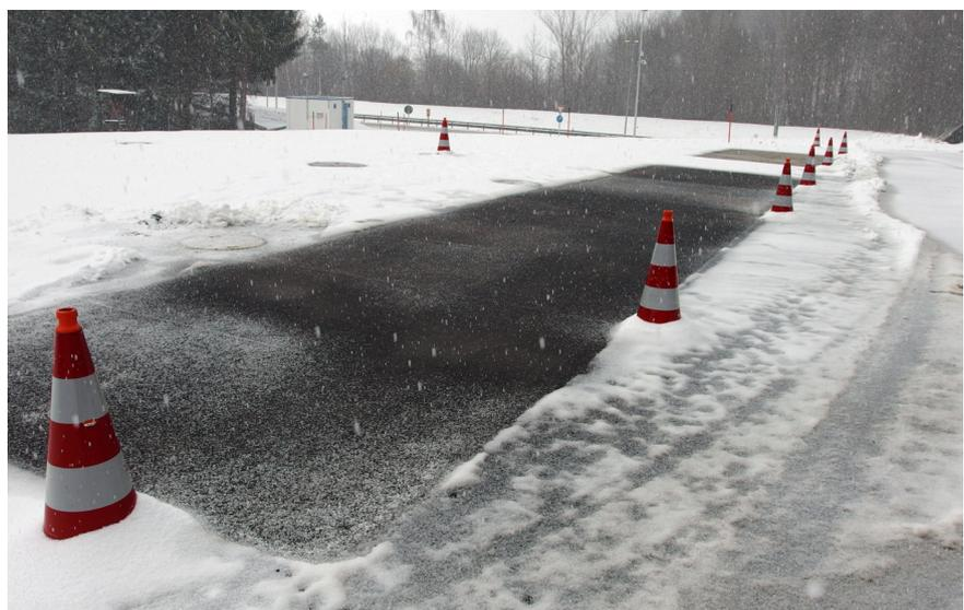
Die geothermische Pilotanlage am Grenztunnel Füssen im Testbetrieb – die beheizten Flächen sind bei leichtem Schneefall deutlich zu erkennen
