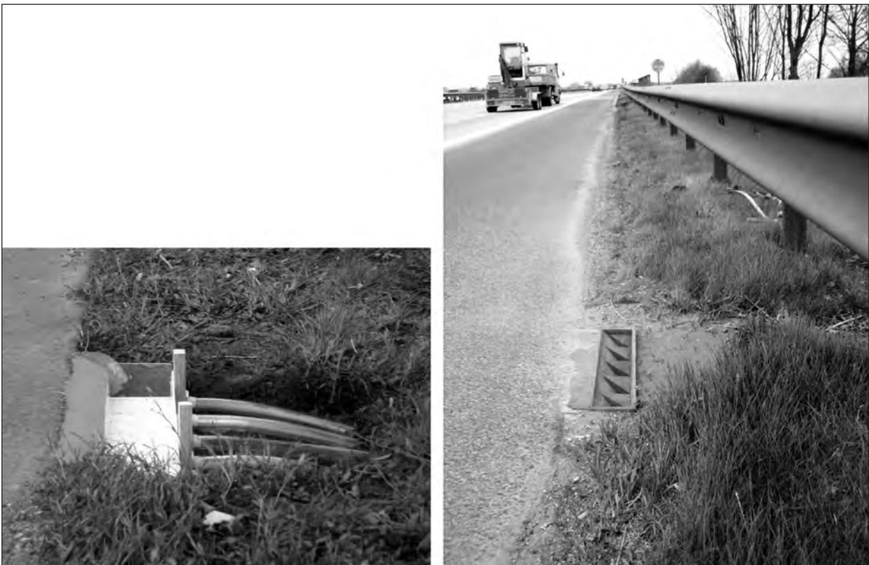
**Bild 9:** Abflusssammler: rechts der erste Sammlertyp, links die verbesserte Sammlerkonstruktion
