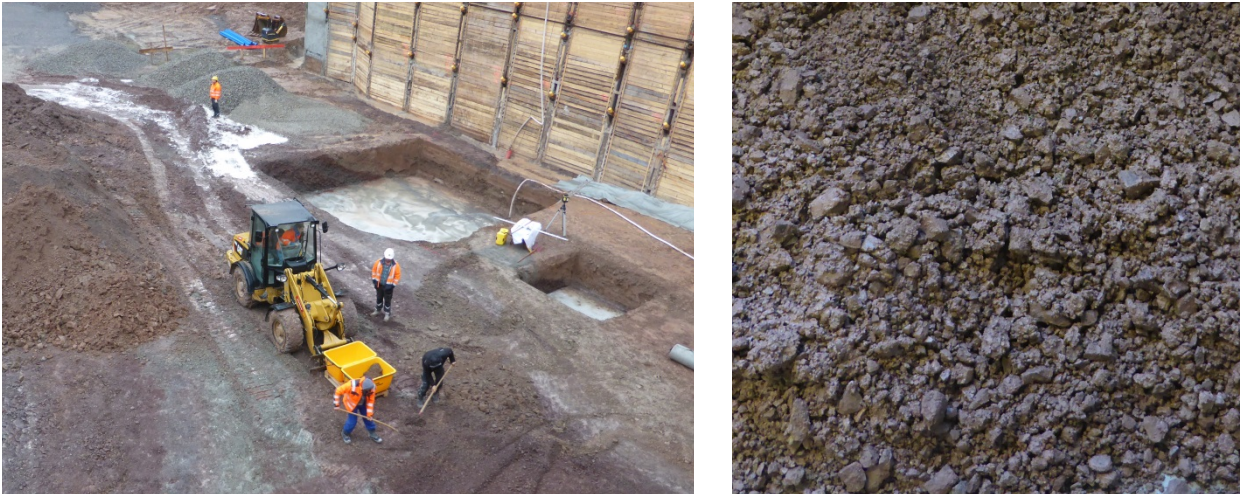
Bild 4.3: dunkelroter Mergel, Entnahmestelle Baugrubensohle (links) und aufbereitete Proben < 31,5 mm (rechts)
