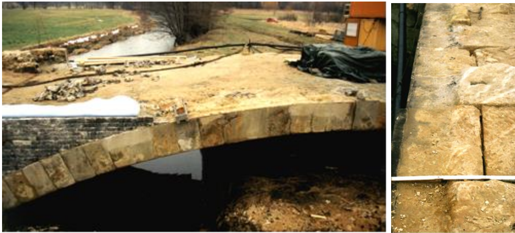
Bild 3 Ansicht freigelegter Bogen, Draufsicht Randbereich
