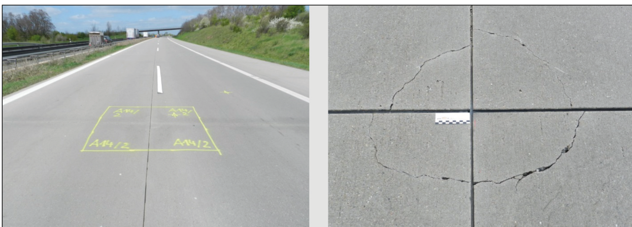
Bild 4-25: BAB A14, LS/1.ÜS, Schadenskategorie II, beginnende Rissbildung im Fugenkreuz.
