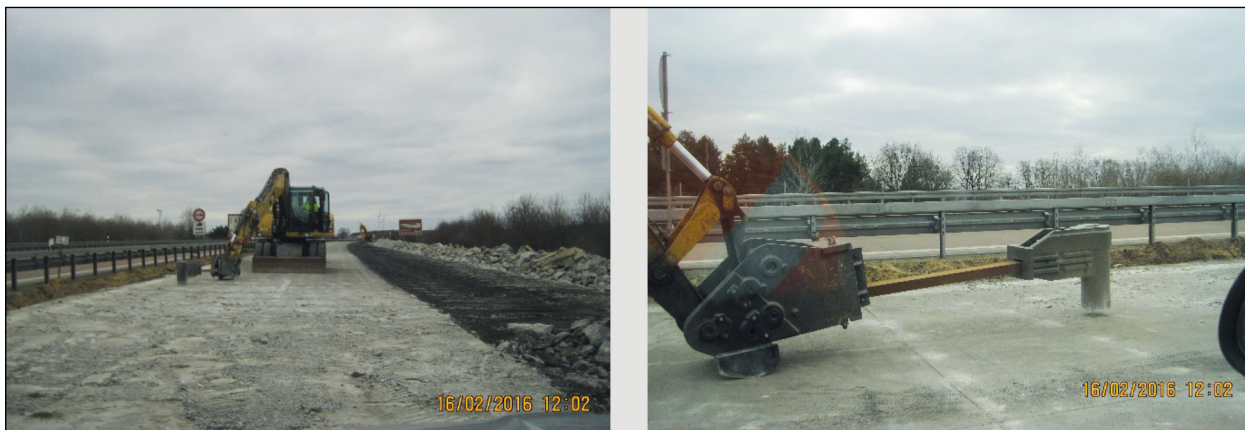
Bild 8-8: Links: Aufbruchhammer Power Sledge (Quelle: Frau Klee). Rechts: Detail zum Aufbruchhammer.
