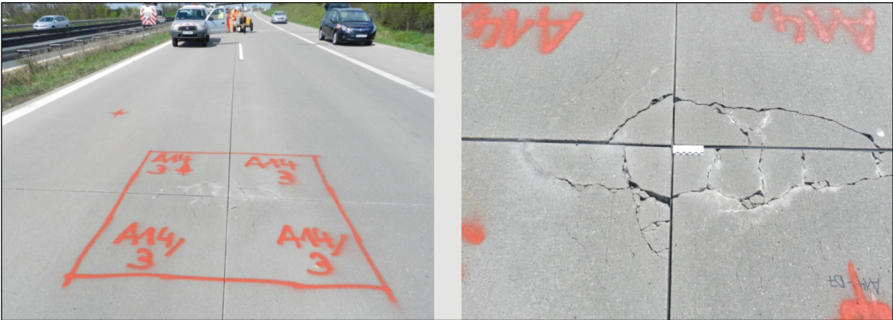
Bild 4-27: BAB A14, LS/1.ÜS, Schadenskategorie III, beginnende Verschotterung.
