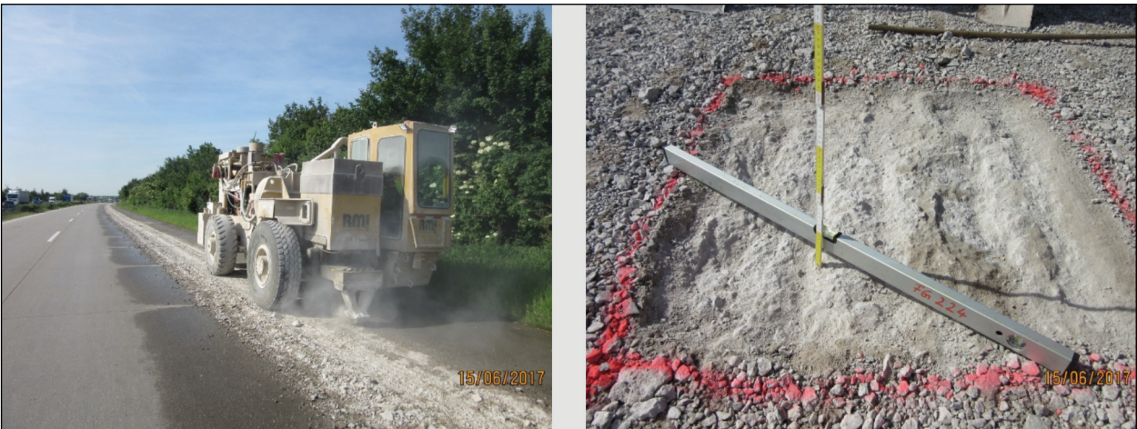
Bild 8-5: Links: Oberfläche Fahrbahndecke beim Rubblizing (Quelle: Dr. Rother). Rechts: Oberfläche nach dem Zertrümmern, ohne nennenswerte Tiefenwirkung (Quelle: Dr. Rother).
