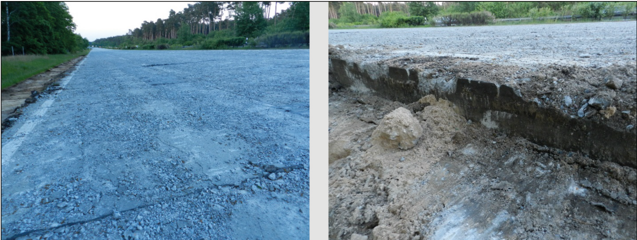
Bild 8-4: Links: Oberfläche Fahrbahndecke nach dem Zertrümmern mit der Polygonalbandagenwalze. Rechts: Nach Zertrümmern ohne nennenswerte Rissbildung über die Deckenhöhe.
