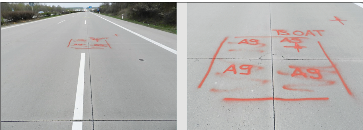
Bild 4-8: BAB A9, LS/1.ÜS, Schadenskategorie III, beginnende Verschotterung.
