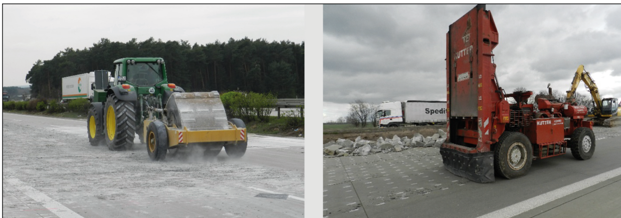
Bild 8-6: Links: Polygonalbandagenwalze (Würfelwalze). Rechts: Fallschwert.
