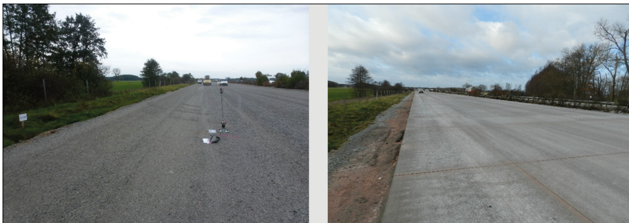
Bild 5-7: Übersichtsaufnahme über den 100 m langen Streckenabschnitt zwischen km 17+000 und km 16+900 vor (links) und nach (rechts) dem Einbau der Fahrbahndecke.
