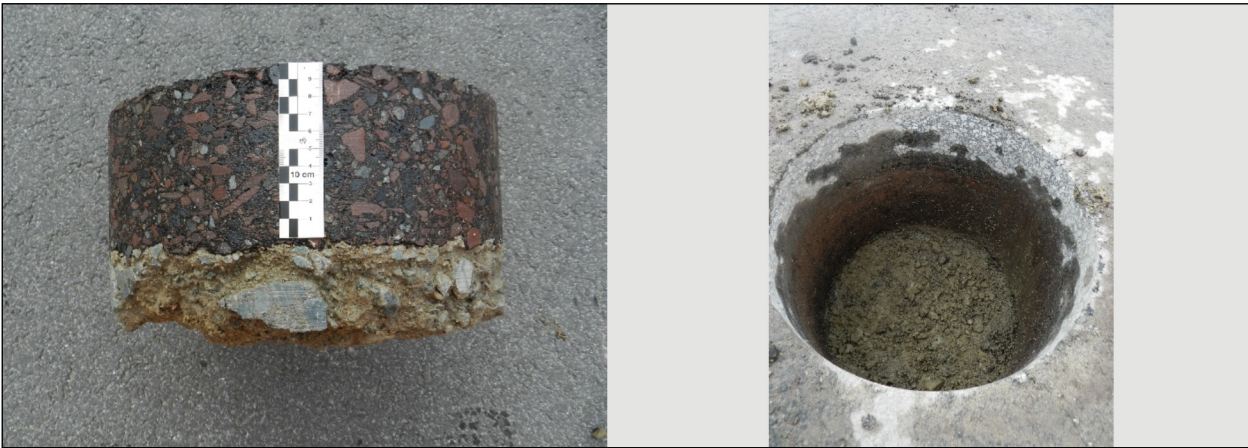
Bild 6-5: Bohrkern 1 (links) und RC-ToB im Bohrloch 1 (rechts) nach Bohrkernentnahme
