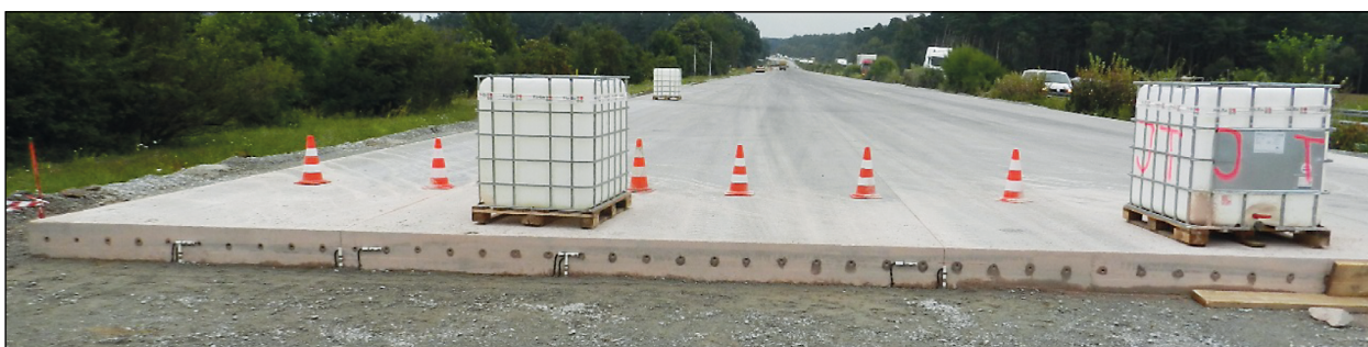
Bild 5-4: Lage der Sensorstäbe am Tagesansatz (spätere Pressfuge) bei km 36+190.
