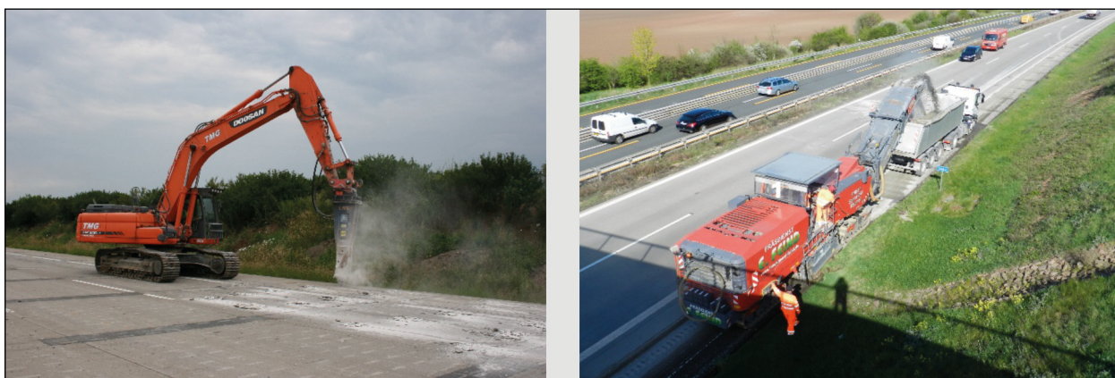
Bild 8-7: Links: Meißel (Quelle: Dr. Wieland). Rechts: Fräse.
