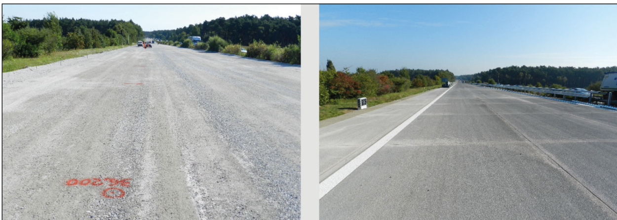
Bild 5-1: Übersichtsaufnahme über den 100 m langen Streckenabschnitt zwischen km 36+100 und km 36+200 vor (links) und nach (rechts) dem Einbau der Fahrbahndecke.
