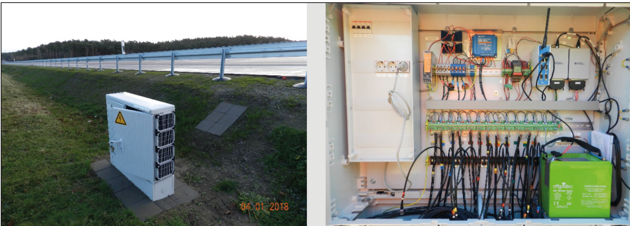
Bild 5-6: Fertiggestellter Gerätekasten bei km 36+190.
