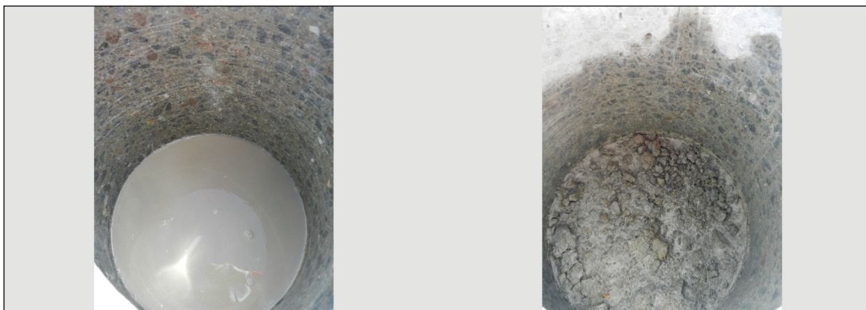
Bild 6-2: Bohrloch nach Bohrkernentnahme (links) und nach dem Entfernen von überschüssigem Bohrwasser.
