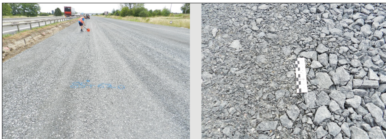
Bild 5-8: Übersichtsaufnahme (links) über den 100 m langen Streckenabschnitt zwischen km 85+700 und km 85+600 und Oberfläche der Schottertragschicht (rechts) nach dem Verdichten bei km 85+620.
