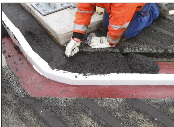
Bild 8: Einbringen des Unterbaus aus Polymerbeton (1)
