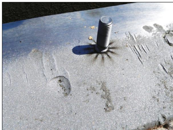
Bild 54: Schweißbolzen zur einseitigen Fixierung (1)
