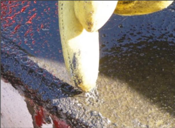
Bild 11: Aufbringen des Haftvermittlers, Prüfen der Konsistenz (1)
