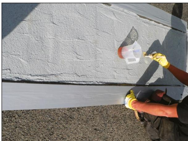
Bild 17: Haftvermittler bei Wartezeiten über 12 Stunden (1)
