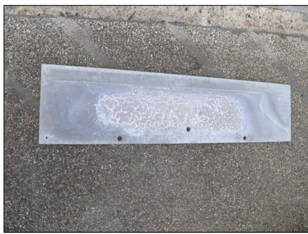
Bild 55: Abdeckblech mit Bohrungen anstelle von Zentrierstiften zur Fixierung (1)
