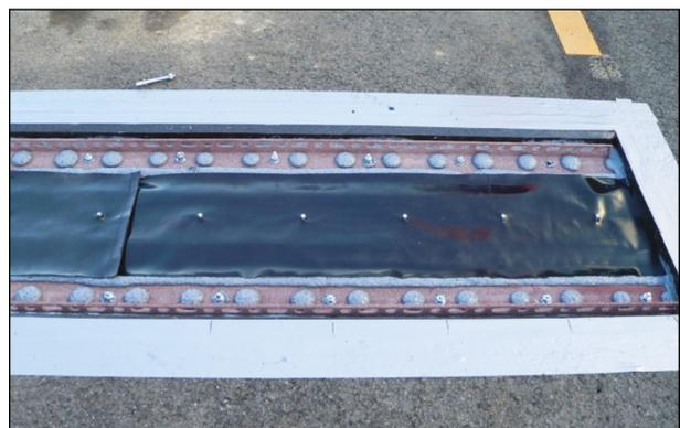
Bild 15: Trennlage über den Abdeckblechen (1)
