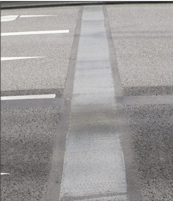
Bild 99: Fahrbahnübergänge aus Polyurethan mit Stützbalken (1)
