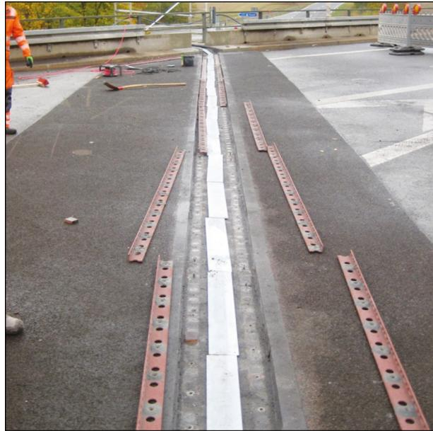
Bild 118: Fahrbahnübergang aus Polyurethan, beidseitig mit Stützbalken und Gussasphaltstreifen (5)
