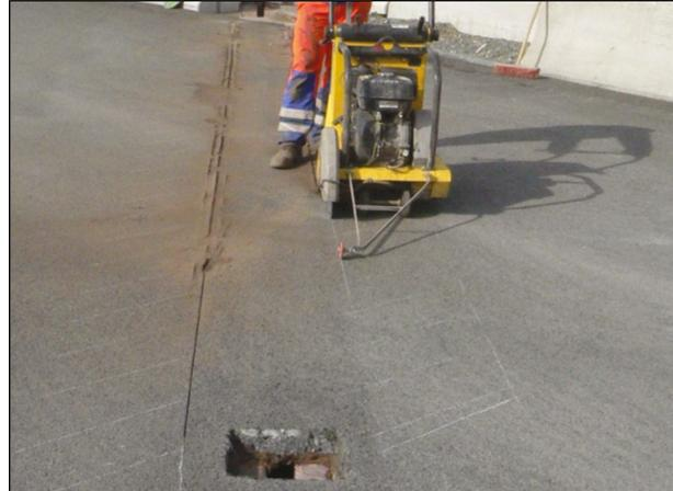
Bild 6: Lagebestimmung und Schneiden des Belages (1)
