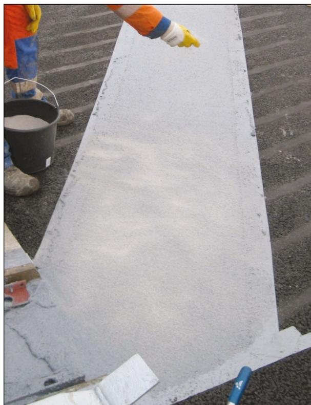
Bild 24: Abstreuen der Oberfläche der letzten Polyurethanschicht (3)
