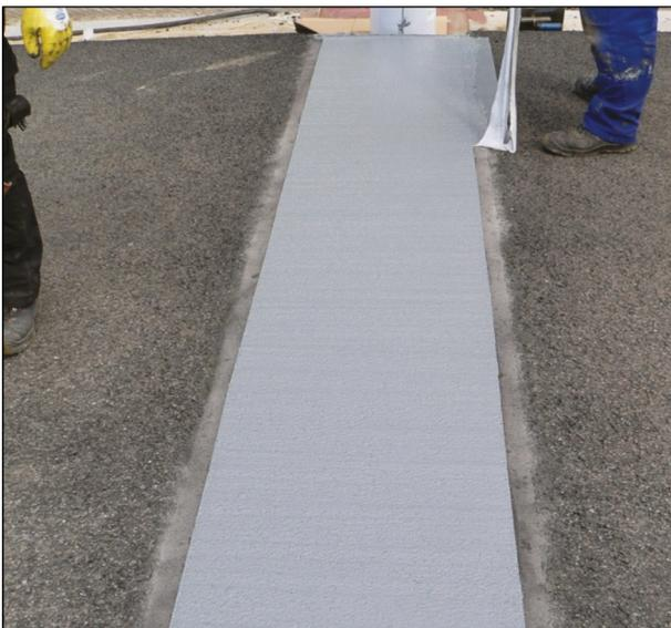
Bild 73: Fahrbahnübergang aus Polyurethan mit Stützbalken (1)
