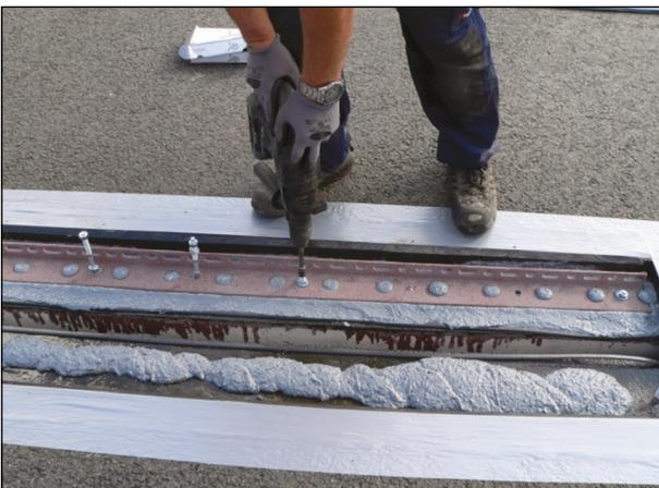
Bild 13: Einbau der gelochten Stahlwinkel (1)
