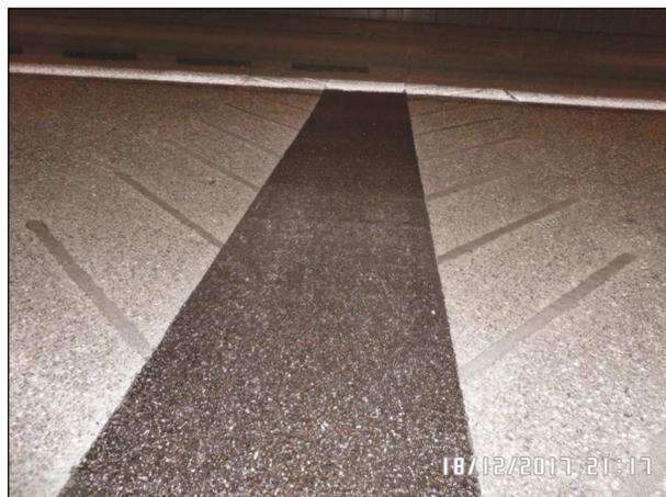
Bild 77: Fahrbahnübergang aus Polyurethan mit Stützrippen im Asphalt (2)
