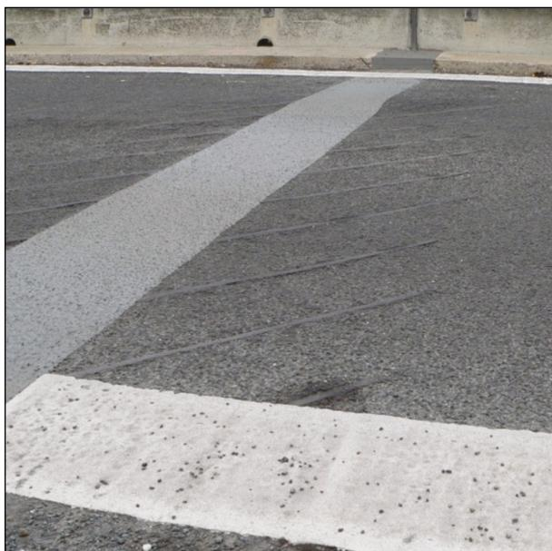
Bild 102: Fahrbahnübergänge aus Polyurethan mit Stützrippen im angrenzenden Belag (1)
