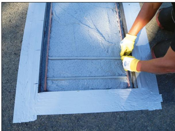
Bild 16: Einsetzen der Stabilisatoren (1)
