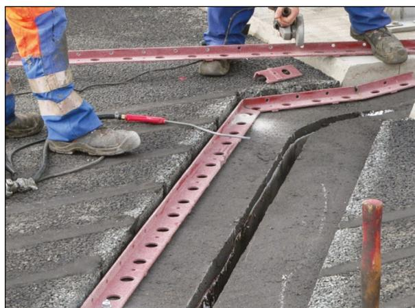
Bild 9: Anpassen und 1. Andübeln der Stahlwinkel (1)
