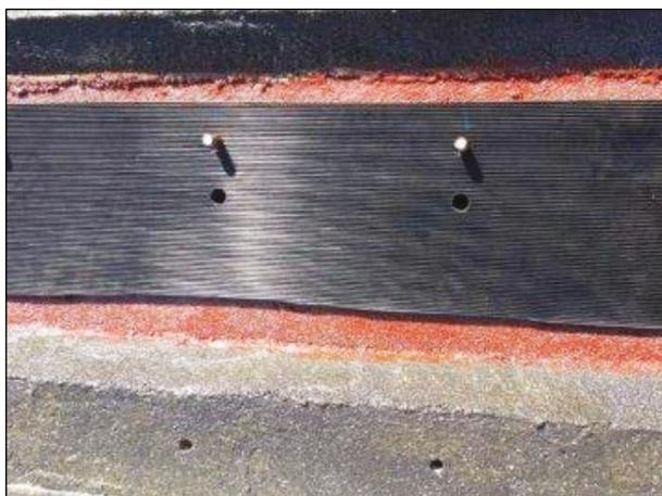
Bild 114: Feinriefenmatte, angeschrägter Unterbau, Schweißbolzen zur Fixierung (2)
