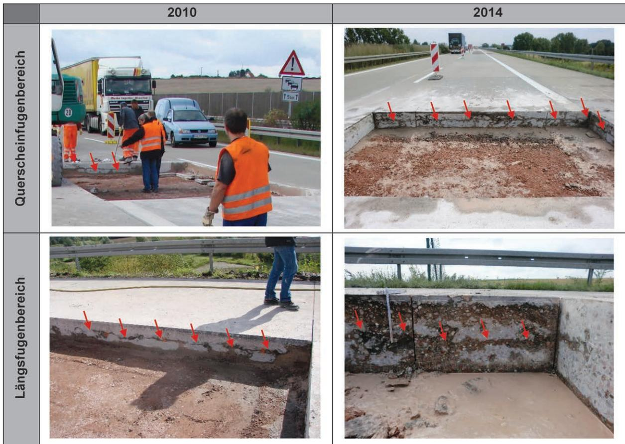
Bild 26: Fotodokumentation zur horizontalen Rissbildung im Bereich der Querschein- und Längsfugen in der Ebene der Dübel und Anker
