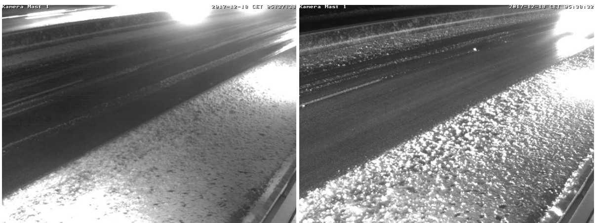
Fahrbahnzustand vor und unmittelbar nach dem Räumen um 05:38 Uhr
