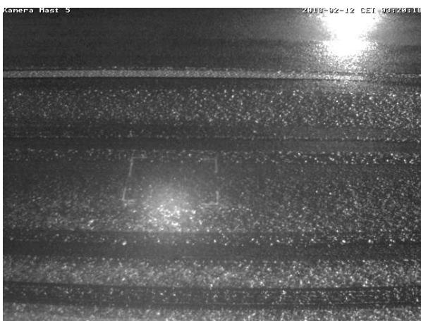
Fahrbahnzustand 03:20 Uhr auf dem linken Fahrstreifen
