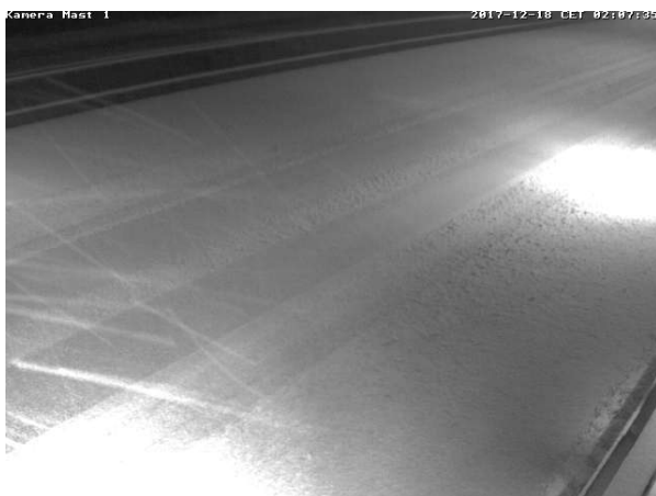
Fahrbahnzustand um 02:07 Uhr
