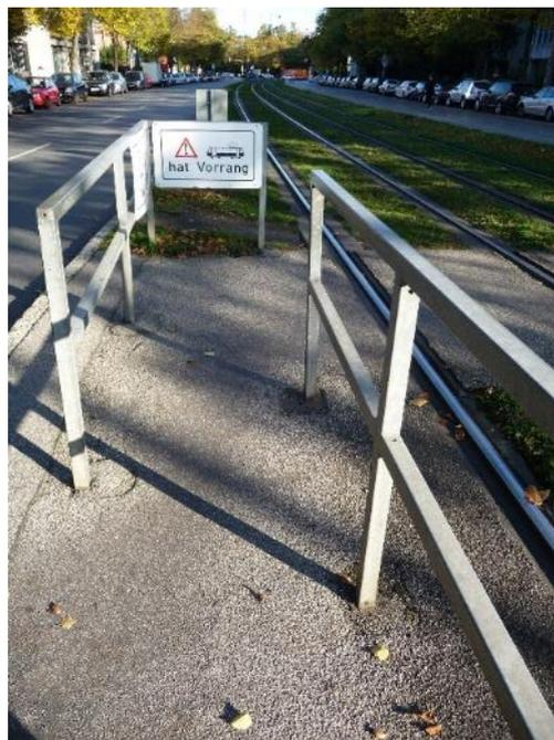
**Bild 97:** Beispiel für eine Gleisquerung mit eng zusammenstehenden Umlaufsperrn
