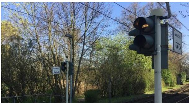
**Bild 4:** Fahrsignal F 0 bei „Grün“ für Fußgänger an einem mit Lichtzeichenanlage technisch gesicherten Bahnübergang
