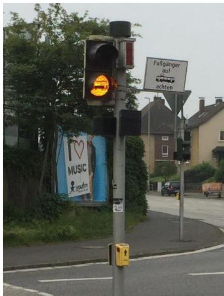
**Bild 7:** Zweifeldiges Springlicht mit Sinnbild „Straßenbahn“ – Anordnung übereinander (Kassel)
