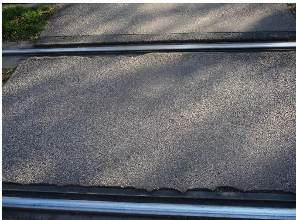
**Bild 106:** Beispiel für Asphaltaufbrüche an der Gleiseindeckung neben den Schienen
