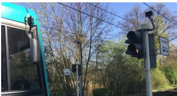
**Bild 5:** Fahrsignal F 1 bei „Rot“ für Fußgänger an einem mit Lichtzeichenanlage technisch gesicherten Bahnübergang
