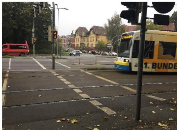
**Bild 29:** Beispiel für ROT-DUNKEL-Signalisierung mit zweifeldigem Signalgeber, 200 mm Leuchtfelddurchmesser (Schwerin)
