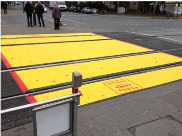
**Bild 49:** Flächige Einfärbung<sup>86</sup> der Konfliktfläche und markierter Warnhinweis mit Sinnbild „Straßenbahn“ (Hannover) (Foto: üstra)
