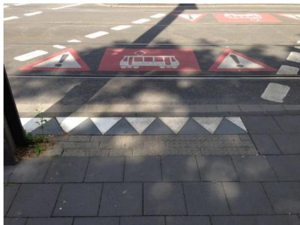
**Bild 46:** Markierungen VZ 101 StVO und ZZ 1048-19 StVO sowie „Haifischzähne“ (hier als Betonsteineinlage, Düsseldorf)
