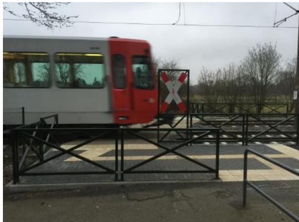
**Bild 36:** Andreaskreuz an einer Gleisquerung (Bahnübergang i. S. d. BOStrab) über einen unabhängigen Bahnkörper
