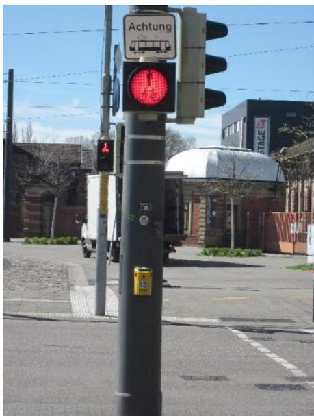
**Bild 30:** Beispiel für ROT-DUNKEL-Signalisierung mit einfeldigem Signalgeber, 300 mm Leuchtfelddurchmesser (Karlsruhe)
