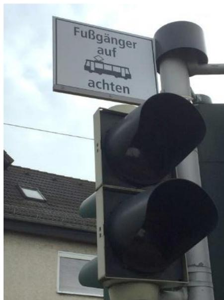
**Bild 39:** Sinnbild „Straßenbahn“ nach StVO mit zusätzlichem schriftlichem Hinweis – Montage oberhalb der Signalgeber (Kassel)
