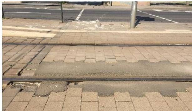
**Bild 19:** Beispiel für Schäden an der Oberfläche im Bereich der Gleisquerung
