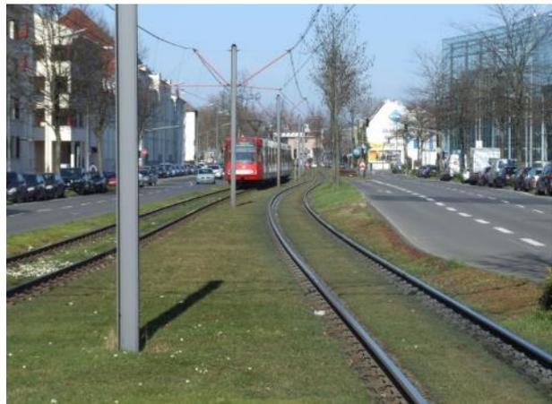
**Bild 2:** Beispiel für eine Straßenbahn auf besonderem Bahnkörper
