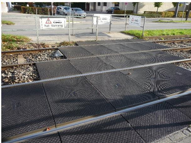
**Bild 107:** Bahnübergangssystem an einer Gleisquerung (Beispiel Stadt B)
