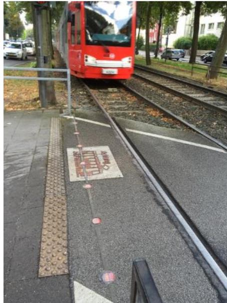
**Bild 23:** Bodenwarnleuchten an einer Gleisquerung in Köln
