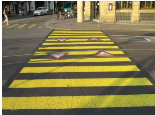
**Bild 21:** Fußgängerüberweg mit zusätzlicher Warnmarkierungen „Straßenbahn“ auf den Gleisen in der Schweiz (Quelle: NÜBOLD et al. 2014)<sup>71</sup>
