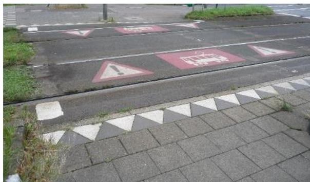
**Bild 92:** Gleisquerung mit Warnhinweisen (Markierung und visuell kontrastierende Elemente) in Stadt C
