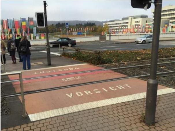
**Bild 48:** Flächige, rote Einfärbung der Gleisquerung, markierter schriftlicher Warnhinweis und markiertes Sinnbild „Straßenbahn“ (Bonn)
