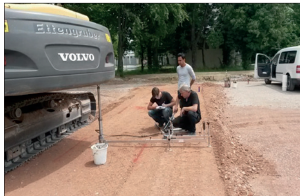
Bild 169: Mitarbeiter des ZG bei der Durchführung von statischen Plattendruckversuchen
