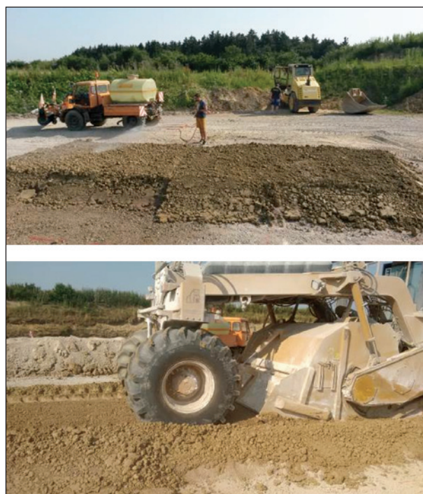
Bild 93: Wasserzugabe zum leicht plastischen Ton und Einfräsen des zugegebenen Wassers mit 2 Fräsdurchgängen
