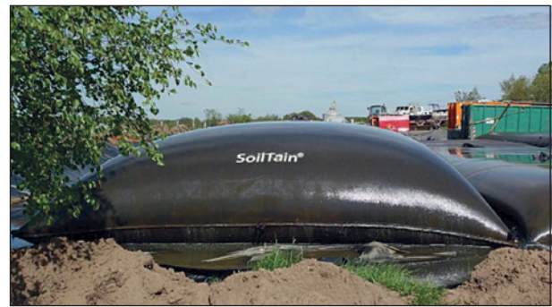
Bild 39: Gefüllter Geotextil-Container (aus WILKE & HANGEN [163])
