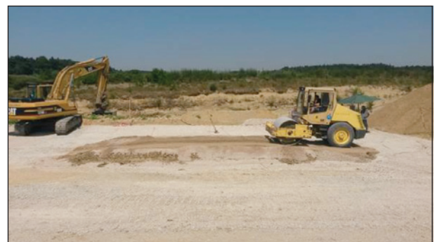
Bild 90: Verdichtung des gefrästen Schichtpaketes
