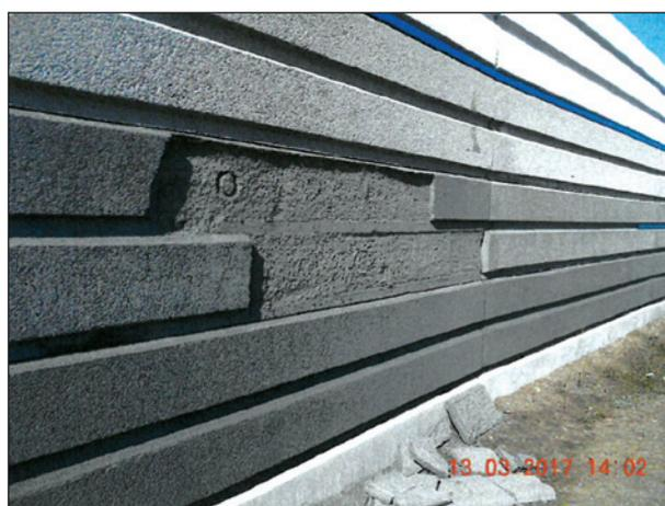
Bild 4.21: Schäden an Vorsatzschale von Beton-Lsw infolge von Witterungsprozessen oder mechanischer Krafteinwirkung (Quelle: BMVI)
