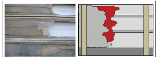
Bild 5.43: MP 4-4: Teilweise fehlende vorderseitige Aluminium-Schale, teilweise fehlender Absorber und Rückwand von Aluminium-Lsw intakt
