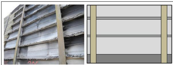
Bild 5.41: MP 4-2: Verbrannte Vorderseite, fehlender Absorber und Rückseite von Aluminium-Lsw intakt
