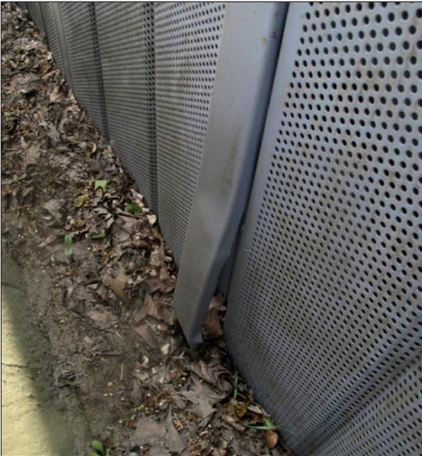
Bild 4.11: Vertikale schlitzförmige Leckage an Aluminium-Lsw durch lose Abdeckung (Quelle: Walloon Road Administration, Belgien)
