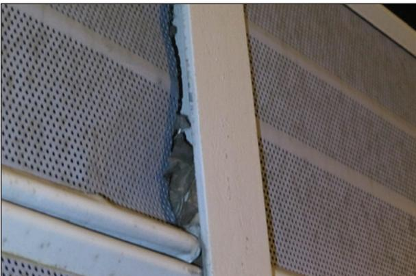
Bild 4.12: Vertikale Undichtheit durch thermische Verformung an Aluminium-Lsw (Quelle: Walloon Road Administration, Belgien)
