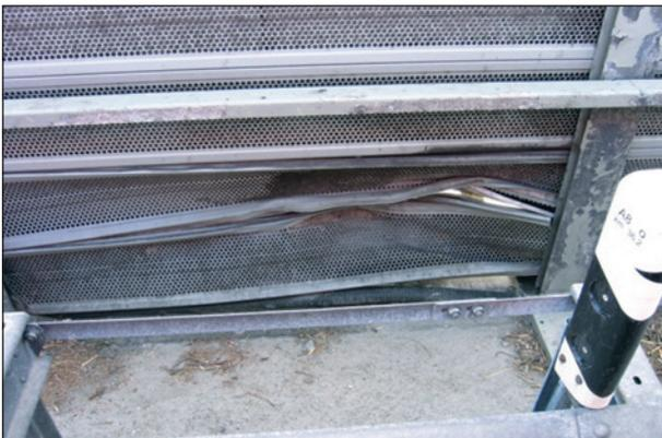
Bild 4.2: Aufprall-Unfallschaden an Aluminium-Lsw (Quelle: BMVI)
