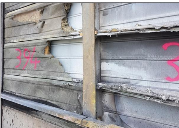
Bild 4.3: Unfallschaden mit Brand an Aluminium-Lsw (Quelle: BMVI)
