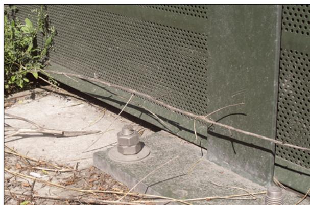
Bild 4.9: Schlitzförmige Leckagen zwischen Aluminium-Lsw und Fundament (Quelle: Walloon Road Administration, Belgien)
