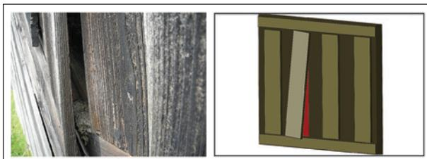
Bild 5.39: MP 3: Spalt in Rückwand von Holz-Lsw
