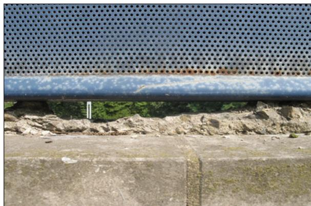
Bild 4.8: Schlitzförmige Leckagen zwischen Aluminium-Lsw und Fundament (Quelle: Walloon Road Administration, Belgien)
