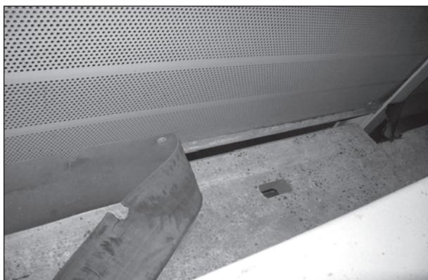
Bild 4.7: Schlitzförmige Leckage zwischen Aluminium-Lsw und Fundament durch fehlende Bodenabschlussleiste (Quelle: Walloon Road Administration, Belgien)
