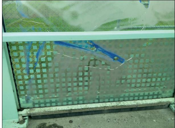
Bild 4.24: Langgestreckter Riss an transparenter Lsw
