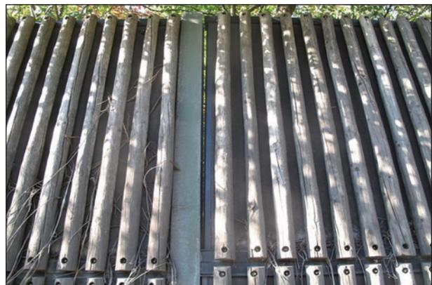
Bild 4.14: Vertikale schlitzförmige Leckage mangelhafte Montage oder thermische Verformung infolge von Witterungsprozessen an Holz-Lsw (Quelle: Walloon Road Administration, Belgien)
