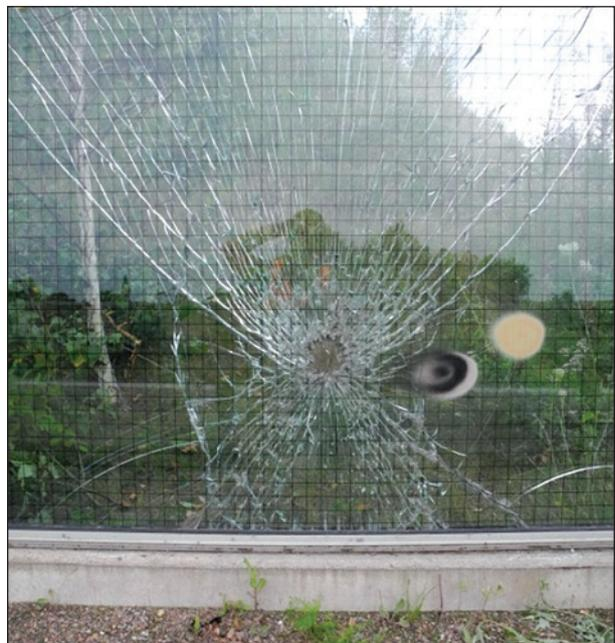
Bild 4.25: Netzartige Risse mit Loch in transparenter Lsw
