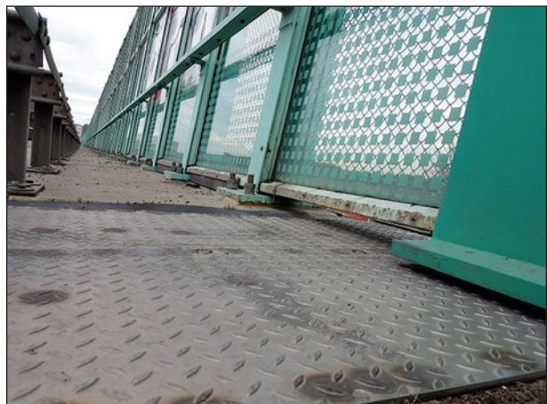
Bild 4.26: Schlitzförmige Leckage zwischen transparenter Lsw und Fahrweg auf Brücke durch fehlende Bodenabschlussleiste
