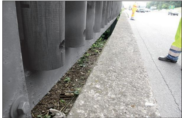
Bild 4.13: Horizontale schlitzförmige Leckage durch fehlende Bodenabschlussleiste an Holz-Lsw (Quelle: Walloon Road Administration, Belgien)
