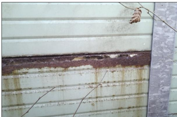
Bild 4.5: Schlitzförmige Leckage durch Korrosion an Aluminium-Lsw (Quelle: Walloon Road Administration, Belgien)
