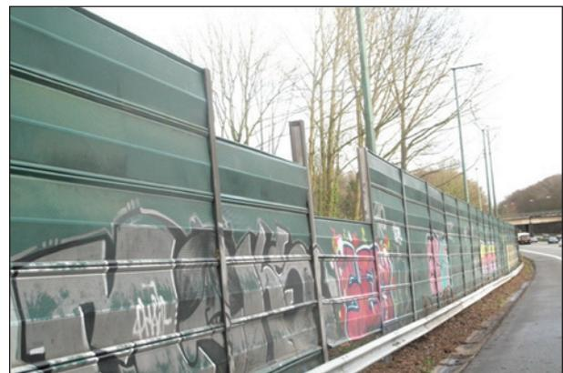
Bild 4.4: Großflächige Leckage durch fehlende Kassetten in Aluminium-Lsw (Quelle: Walloon Road Administration, Belgien)
