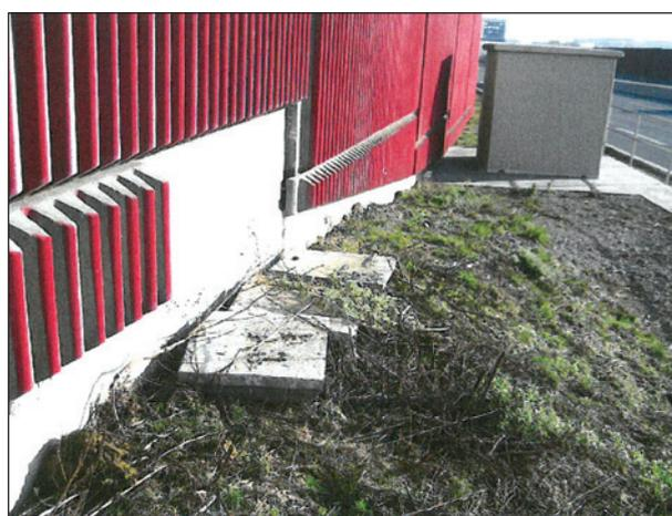
Bild 4.20: Schäden an Vorsatzschale von Beton-Lsw (aus Einkornbeton) infolge von Witterungsprozessen oder mechanischer Krafteinwirkung (Quelle: BMVI)
