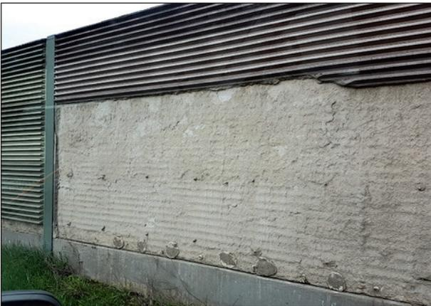
Bild 4.23: Schäden an Vorsatzschale von Beton-Lsw infolge von Witterungsprozessen oder mechanischer Krafteinwirkung
