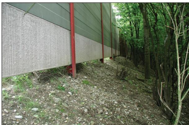
Bild 4.6: Schlitzförmige Leckage unterhalb des Fundaments von Aluminium-Lsw durch Erdbauschaden (Quelle: BMVI)
