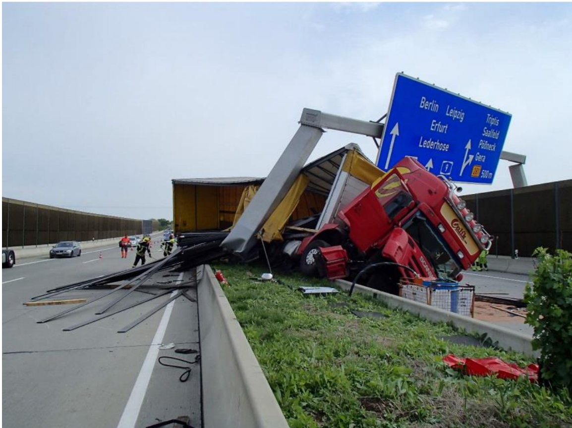
Abbildung 15 - LKW-Anprall an eine VZB aus Aluminium, BAB A9
