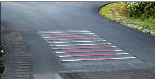
Bild 21: Rüttelstrecke von 6,70 m Länge und 2 m Breite mit 3 cm tiefen Einfräsungen.
