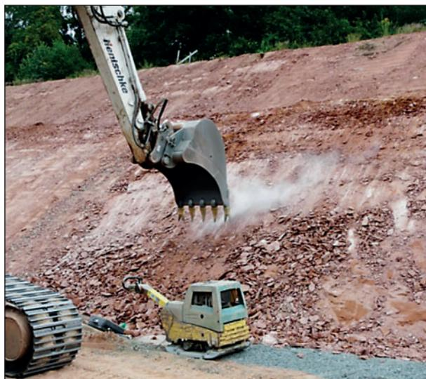
Bild 4.20: Abtrag mittels Löffel mit Felszähnen
