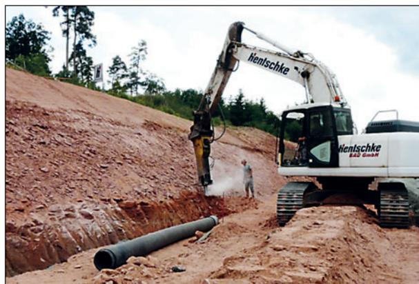
Bild 4.21: Bodenabtrag mittels Meißel
