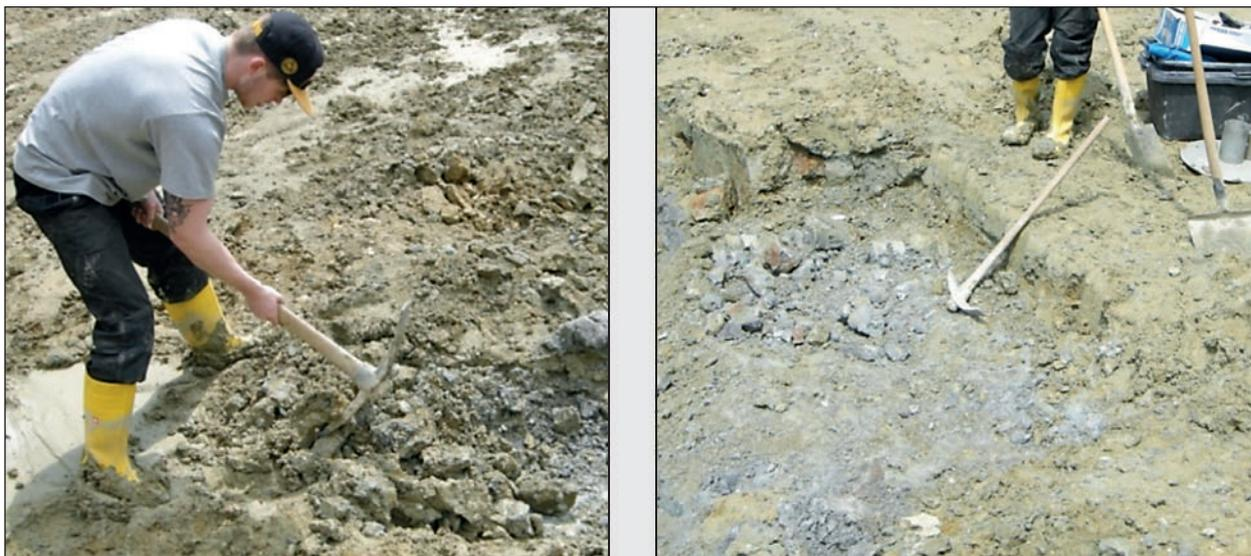
**Bild 4.1:** links: Beispiel händische Schurfherstellung mit Pickel und Schaufel; rechts: abgegrabener Bereich von ca. 1 m x 2 m
