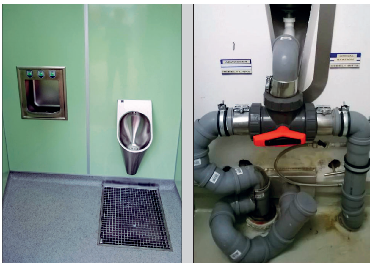
Bild 2-6: Urinalkabine (links) und rückseitiger Anschluss mit Option zur Urinseparation (rechts)
