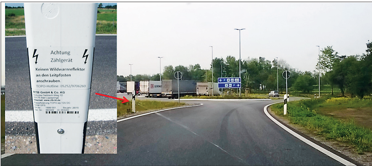
Bild 2-12 Zählstelle auf der Auffahrtsrampe zur PWC Anlage Jalmer Moor
