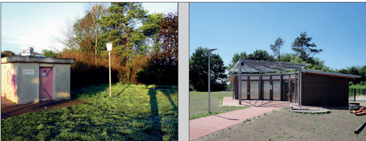
Bild 2-4: altes (links) und neues (rechts) WC-Häuschen der PWC-Anlage Jalmer Moor
