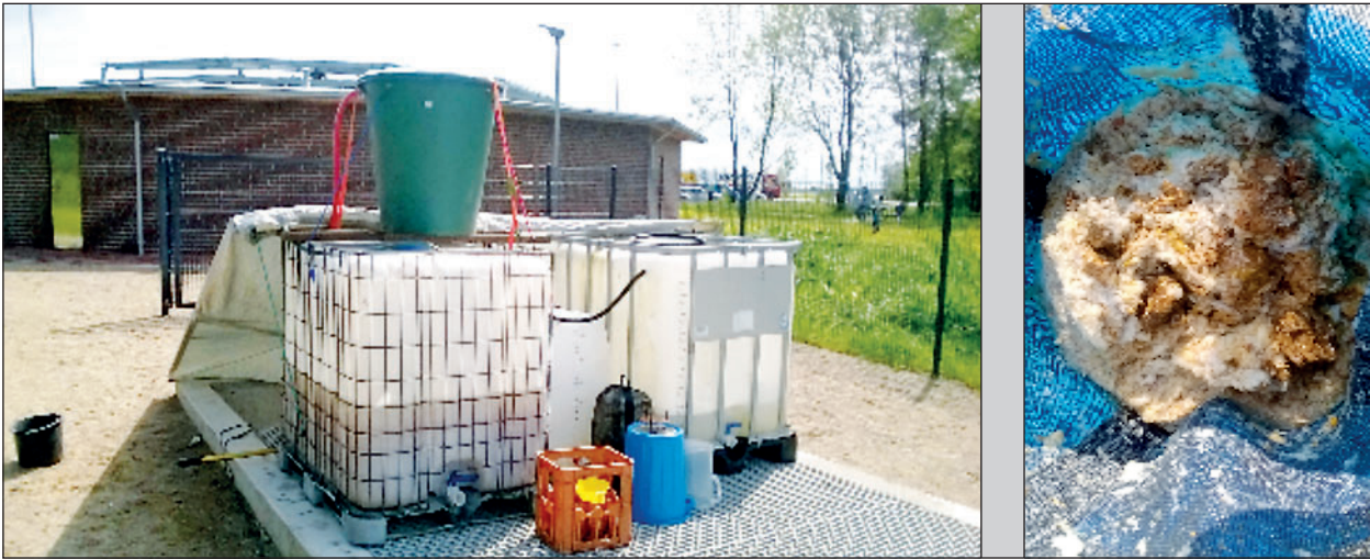
Bild 3-12: Blick auf die Speicher zur Bilanzierung und Probenahme von Siebdurchgang und Siebgutfiltrat (linkes Bild) sowie in einen mit Siebgut gefüllten Filtersack (rechtes Bild)
