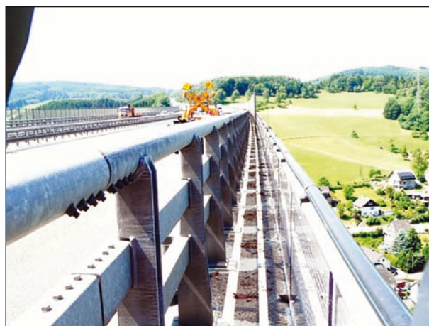
Bild 65: Beispiel: Sehr hohe Schutzeinrichtung mit Standardgeländer (Quelle: BAST, MAYER)
