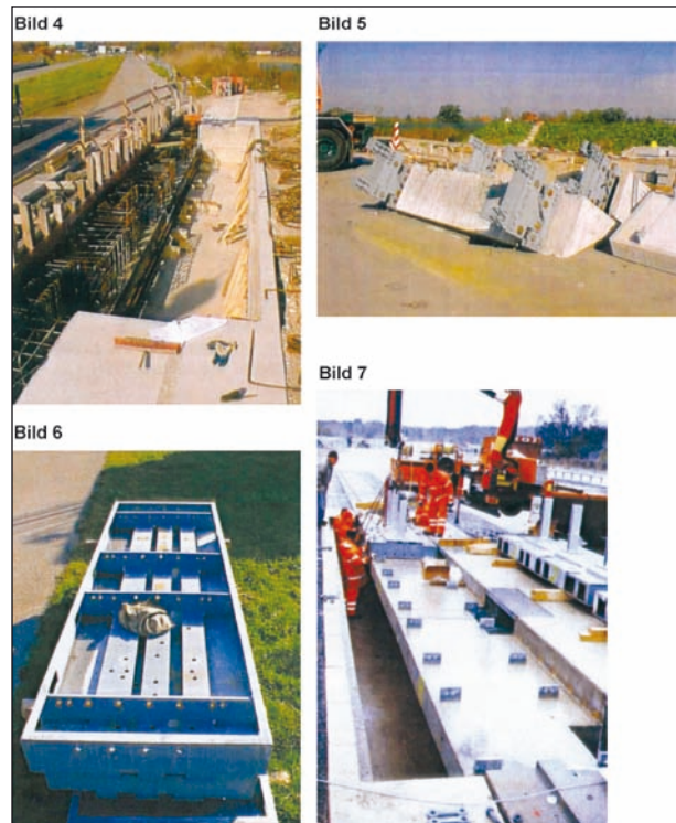
Bild 4: Versuchsanlage im Bau, Bild aus [6]
