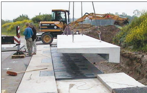
Bild 19: 12-m-Kappe beim Einbau in die Messbrücke (TÜV Automotive GmbH)
