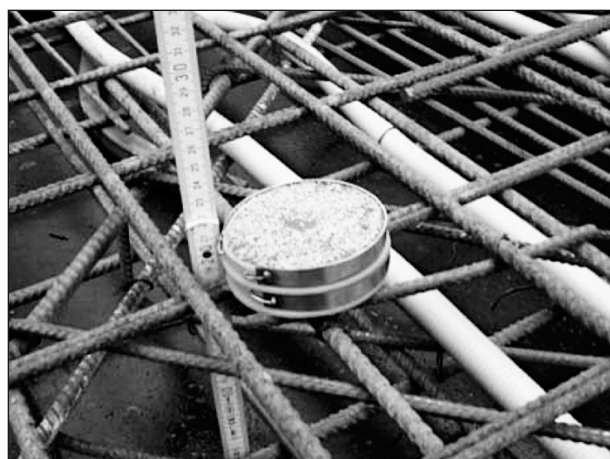
Bild 26: Bewehrungsstahl mit Feuchtedetektor
