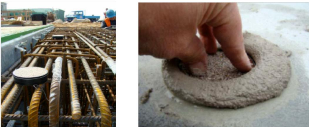
**Abb. 18:** Einbau eines Sensors vor dem Betonieren (li) und als Kernlochbohrung am Bestandsbauwerk (re) (21)
