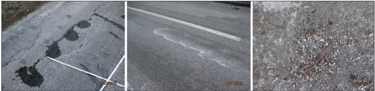
Bild 67: Salzränder aufgrund von Feuchtigkeit über Nacht (links) bzw. durch ein altes Messfeld (Mitte). Zusammengekehrte Salzreste vom Randstreifen (rechts)
