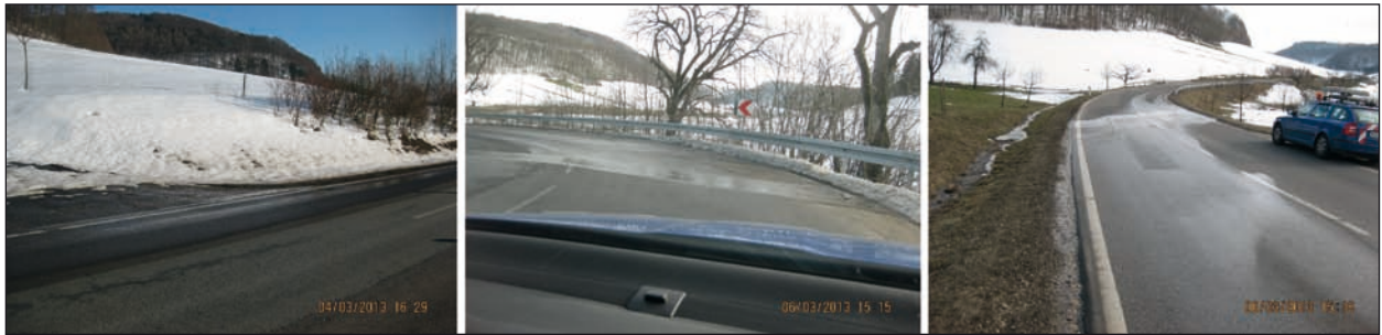
Bild 114: Feuchte bzw. nasse Fahrbahn aufgrund von Schneeschmelze
