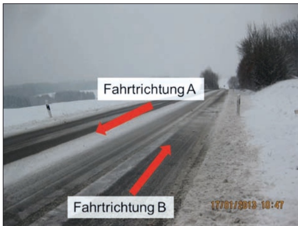
Bild 110: Fahrbahnzustand auf der L 1075
