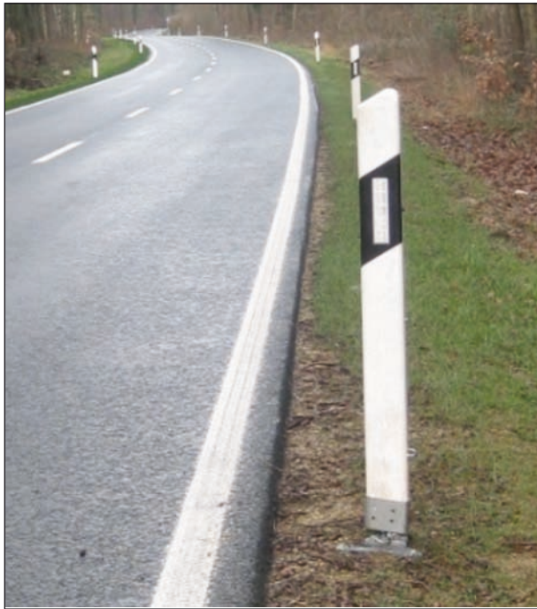
Bild 11: Leitpfosten mit integriertem Radargerät SR5
