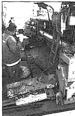
**Bild 31:** Einbau der Gussasphaltschutzschicht mit Fertiger
