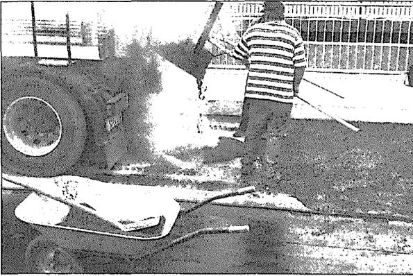
Bild 32: Handeinbau der Gussasphaltschutzschicht
