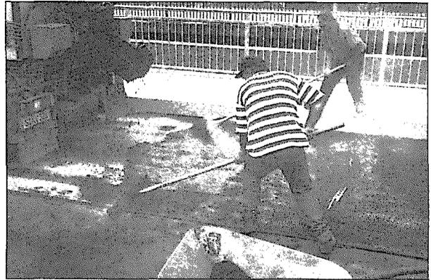
Bild 33: Handeinbau der Gussasphaltschutzschicht
