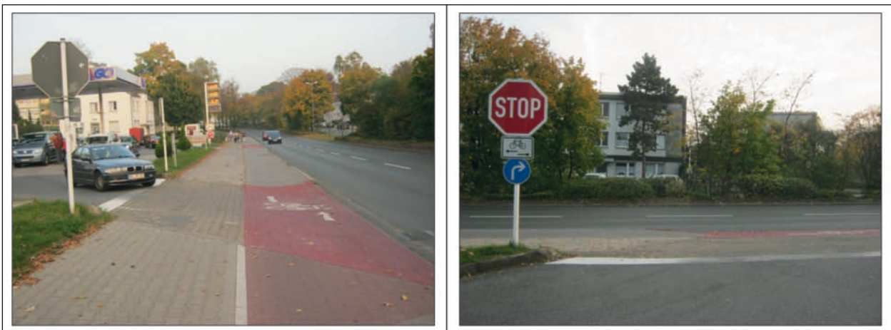
Bild 7-25: Sicherung gemäß VwV-StVO (2 Z 206), Rotfärbung Radweg, Richtungspfeile, Sinnbild „Fahrrad“, aber fehlende Furtmarkierung und zügige Einbiegemöglichkeit
