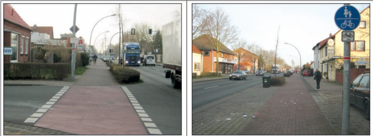
Bild 6-3: Einseitiger Geh- und Radweg mit Benutzungsrecht in linker und Benutzungspflicht in rechter Fahrtrichtung
