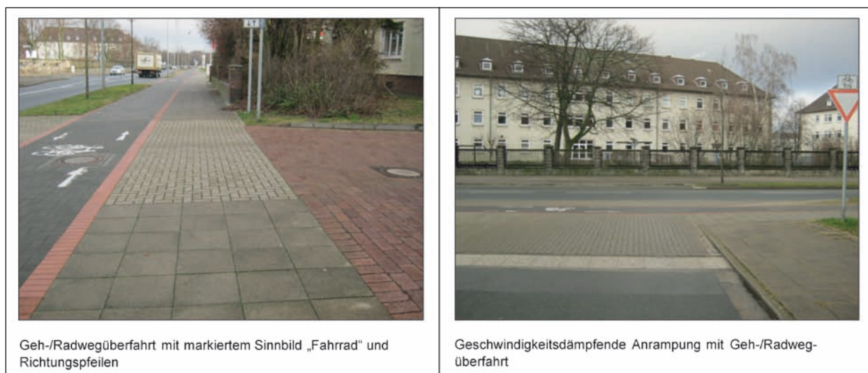
Bild 7-18: Beispiele mit zusätzlicher baulicher Sicherung
