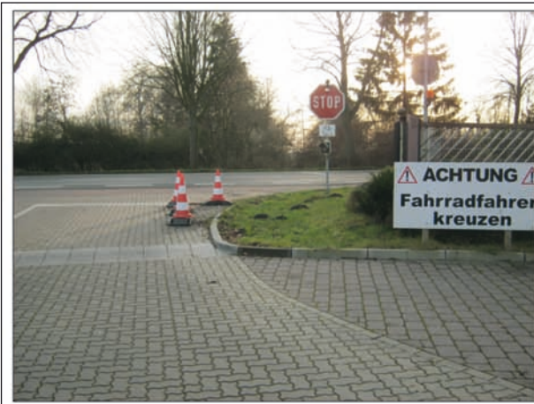
Bild 7-27: Sicherung gemäß VwV (beleuchtetes Z 206) und zusätzlich mit geschwindigkeitsdämpfender Aufpflasterung, Blinklicht und Warnhinweis
