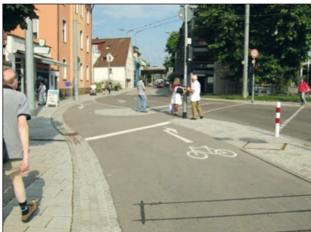
Bild 4-5: Überquerungsanlage am Ende eines Zweirichtungsradweges
