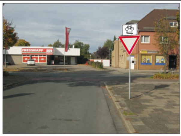
Bild 7-26: Sicherung gemäß VwV-StVO und roteingefärbte Radverkehrsfurt (Sicht auf Radverkehr in rechter Richtung eingeschränkt, Markierung im Jahr 2013 ausgebleicht)
