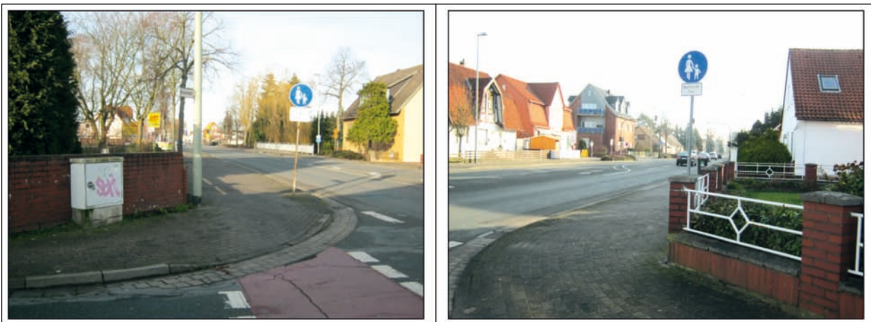
Bild 6-4: Für Radverkehr in beiden Richtungen freigegebener Gehweg, gegenüberliegende Straßenseite in beiden Richtungen benutzungspflichtiger Radweg Hinweis: Diese Kombination ist unzulässig, da durch die Benutzungspflicht des Radweges auf der einen Straßenseite der Gehweg mit zugelassenem Radverkehr auf der anderen Straßenseite vom Radverkehr nicht mehr benutzt werden darf.
