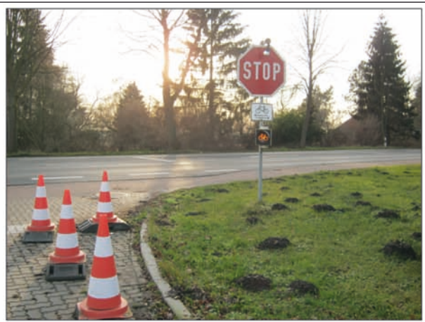
Bild 7-27: Sicherung gemäß VwV (beleuchtetes Z 206) und zusätzlich mit geschwindigkeitsdämpfender Aufpflasterung, Blinklicht und Warnhinweis
