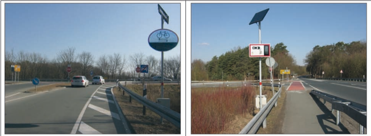
Bild 7-22: Einmündung an anbaufreiem Geh- und Radweg mit Zweirichtungsbetrieb, Verkehrszeichen gemäß VwV und Rotmarkierung der Radverkehrsfurt, Dialog-Display. Es besteht eine ausreichende Sicht, aber eine zügige Einbiegemöglichkeit
