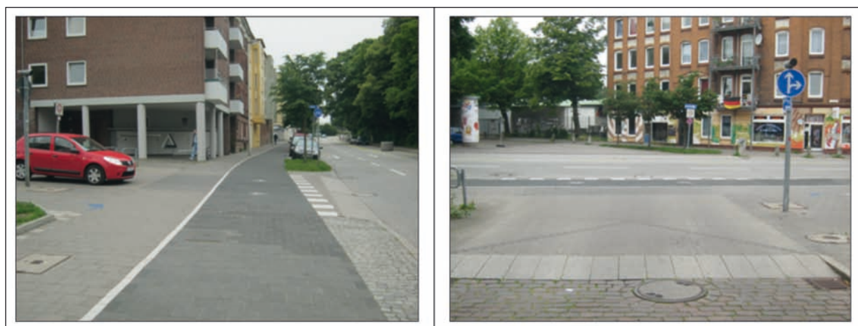
Bild 7-19: Beispiel für zusätzliche bauliche Sicherung ohne Anordnung von Verkehrszeichen, da Zufahrt über abgesenkten Bord erfolgt
