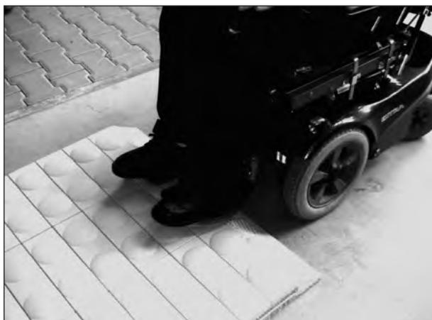
**Bild 4/10:** Einsatz von abgeschrägten Hochborden: Die Fußstütze befindet sich bei vielen Benutzern (gemäß den jeweiligen individuellen Voraussetzungen) dicht über dem Boden. Dadurch wird z. B. das Auffahren auf Bordsteinkanten erschwert bzw. ggf. verhindert. Hier: Auffahrt auf ein „Aufmerksamkeitsfeld“ mit taktil erfassbarer Noppenstruktur
