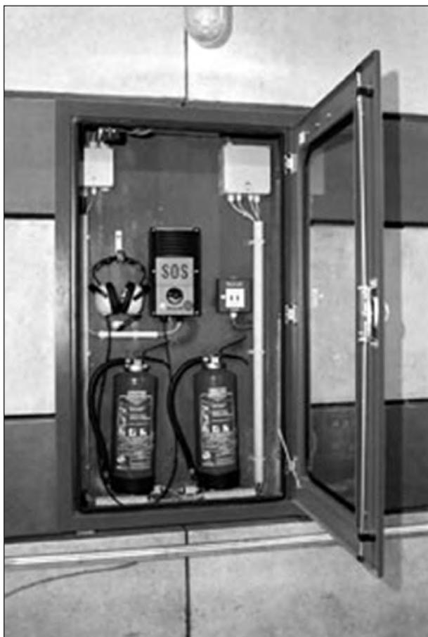
**Bild 4/14:** Handlauf und Notrufnische mit abnehmbarer Einsprecheinrichtung – Hemelinger Tunnel
