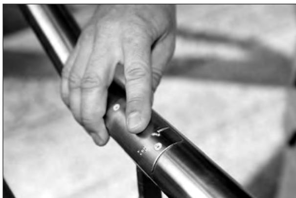
**Bild 4/15:** Taktile Markierung auf einem Handlauf
