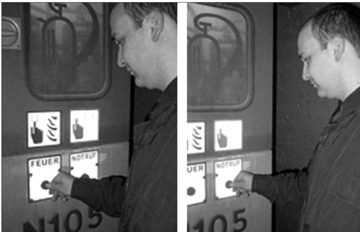
**Bild 4/21:** Beispiel für eine Notrufeinrichtung mit Druckknöpfen zur Konkretisierung unterschiedlicher Notfälle
