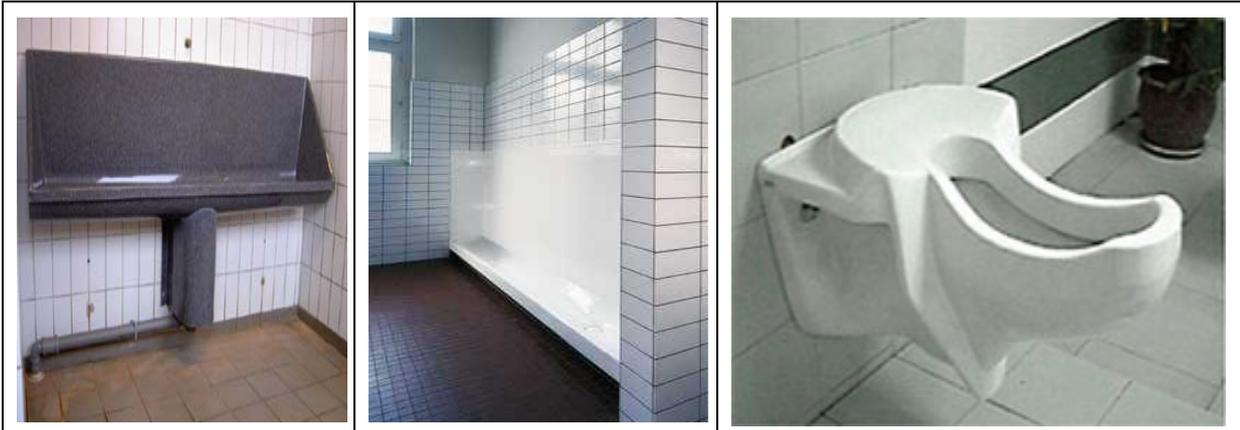
Abbildung 8-6: Wasserloses Rinnenurinal für Herren aus Kunststoff<sup>21</sup> (links) und Keramik<sup>22</sup> (Mitte) sowie Frauenurinal aus Keramik<sup>23</sup> (rechts)
