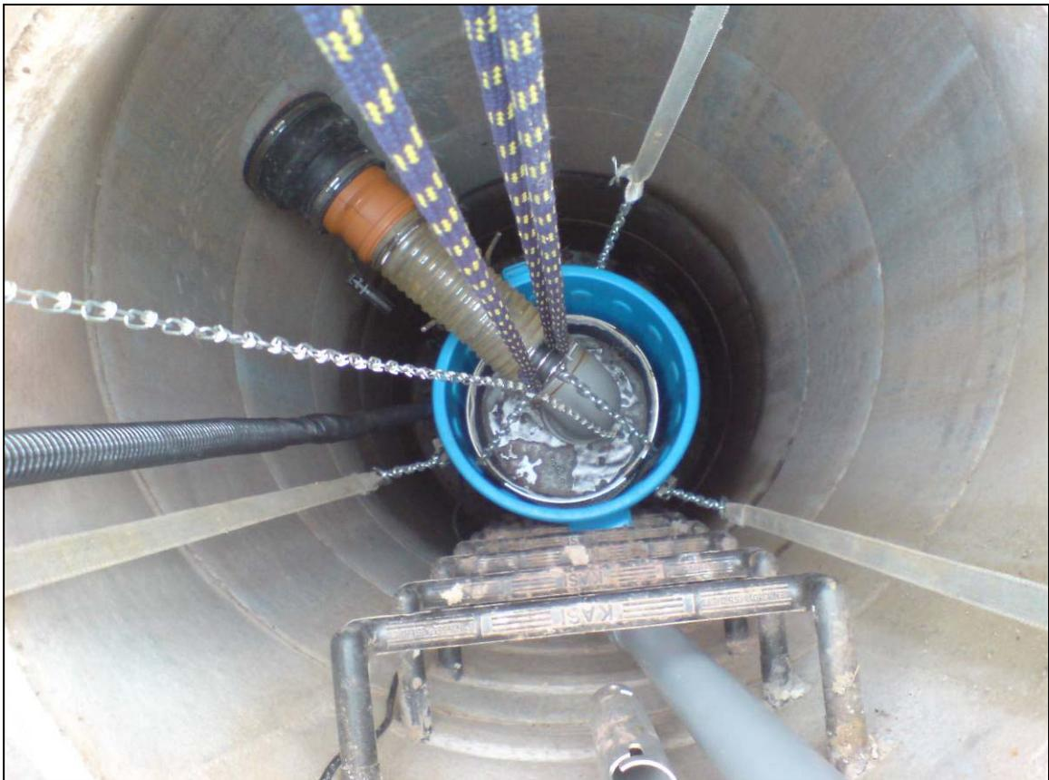
Abbildung 7-2: Probenahmekonstruktion im Betrieb an der PWC-Anlage Adlersberg; oben: oberirdisch, unten: im Schacht.
