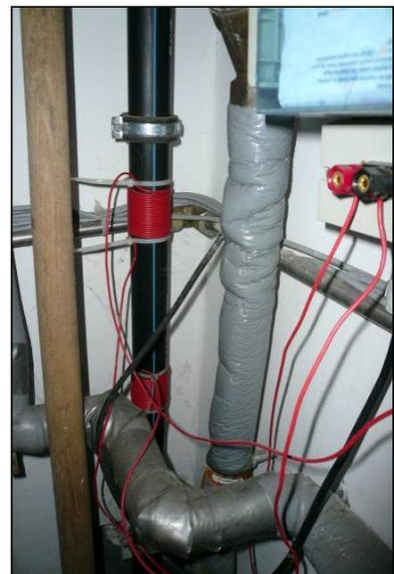
Abbildung 5-3: Dosierung von Chemikalien (links) und Anlegen elektromagnetischer Felder (rechts) zur Prävention von Ablagerungen in den Abwasserrohren
