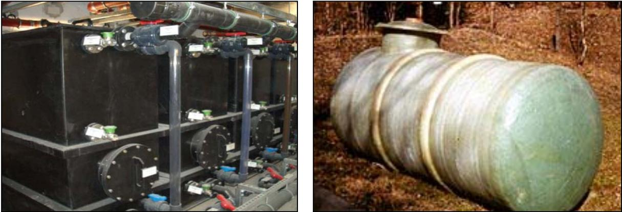
Abbildung 3-2: Urinspeicher der GTZ in Eschborn (links) und ein Urinspeicher der VKA GmbH<sup>13</sup> (rechts)
