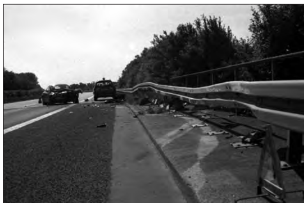
Bild 3: Endstellung des Fahrzeugs und deformierter Bereich der Stahlschutzeinrichtung
