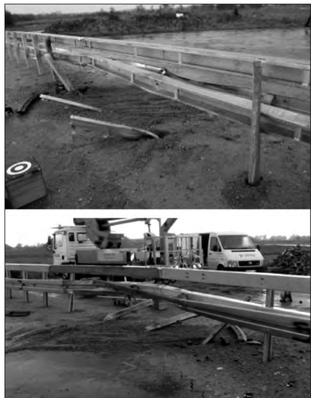
Bild 27: Stahlschutzeinrichtung nach dem Versuch
