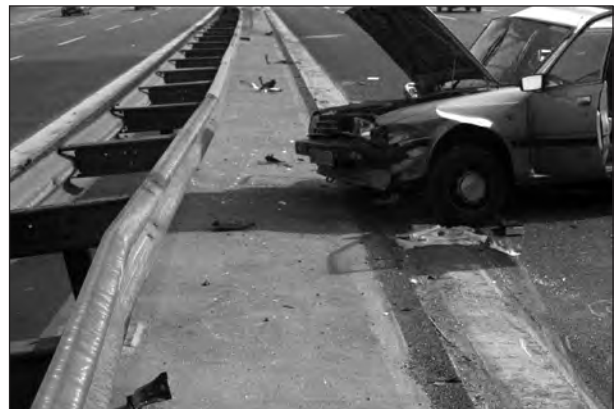
Bild 8: Durch den Anprall des Nissan beschädigte Schutzplanke
