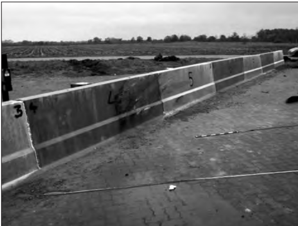
Bild 34: Schutzeinrichtung nach dem Versuch
