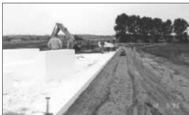
Bild 51: 5. Lage EPS-Hartschaumstoff in der Geh- und Radwegüberführung
