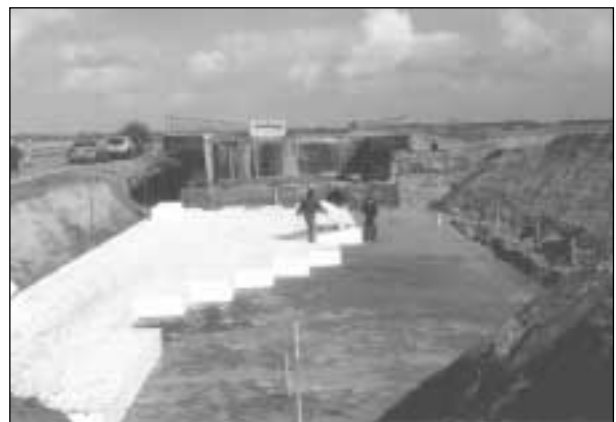
Bild 27: Einbau der 1. EPS-Lage südlich der Brücke über das Larreiter Tief
