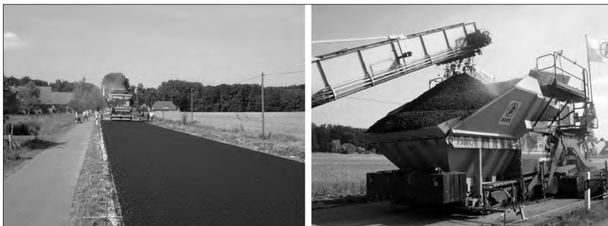
Bild 4: Bauabschnitt 2007; Einbau Probestrecke L 94 bei Melle am 19.06.2007
