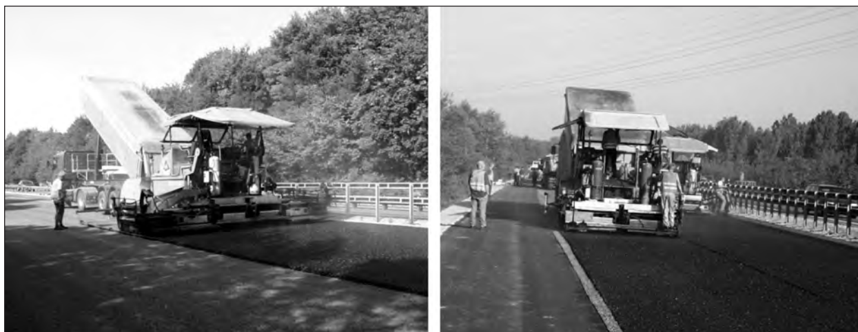
Bild 2: Bauabschnitt 2006; Einbau untere Schicht OPA 0/16 am 15.09.2006
