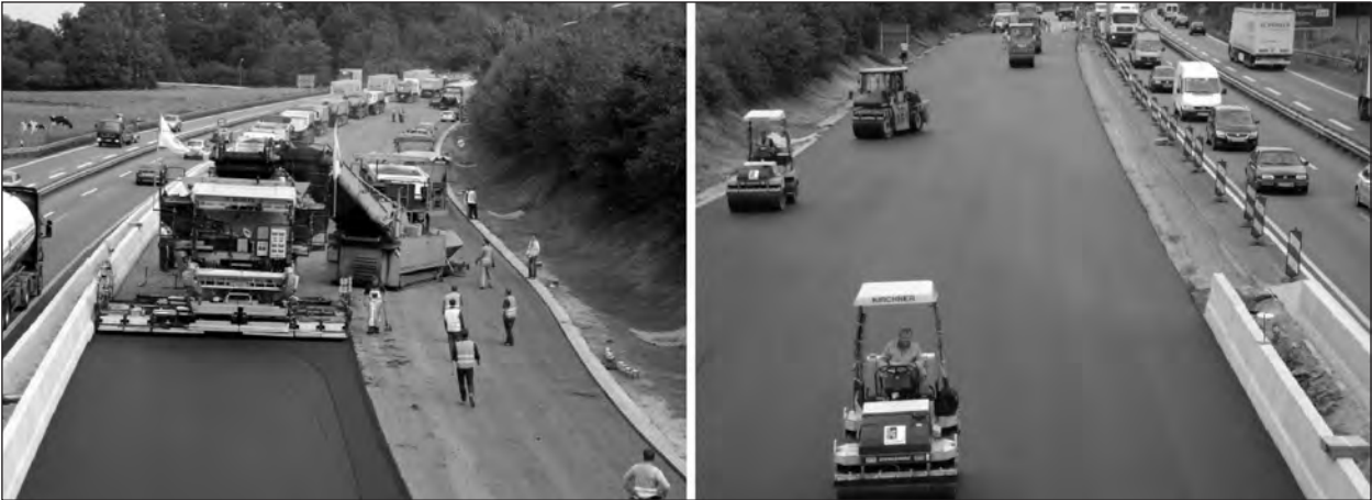
Bild 5: Einbau Bauabschnitt 2007; Teilabschnitt 2007-3 am 05.09.2007
