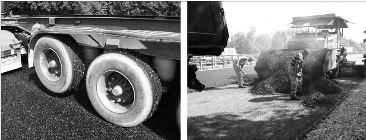
Bild 3: Einbau Bauabschnitt 2006; Details
