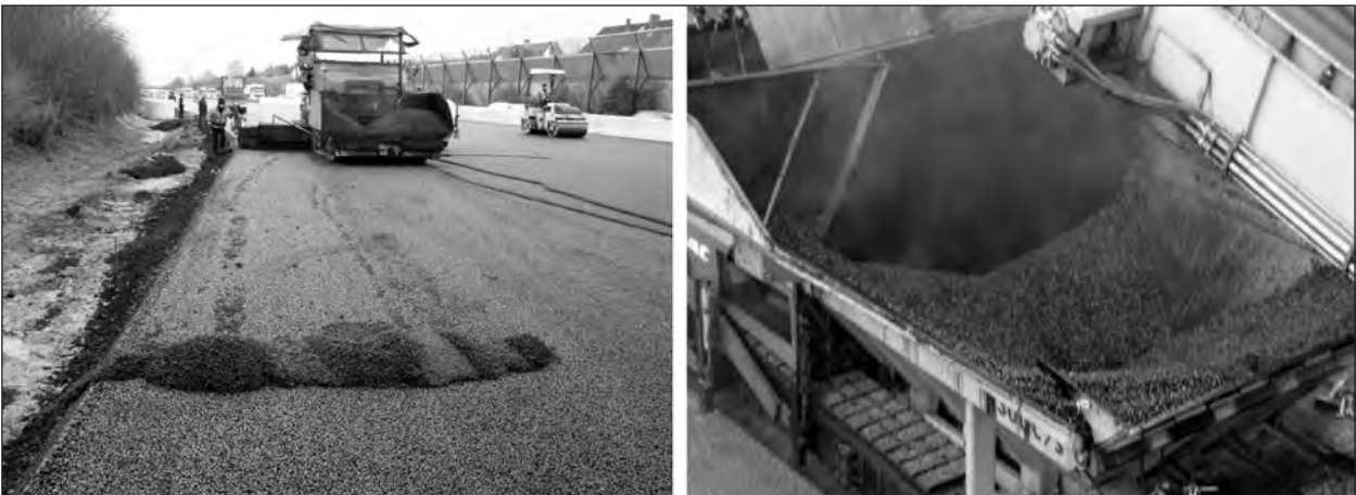
Bild 6: Einbau Bauabschnitt 2007; Details
